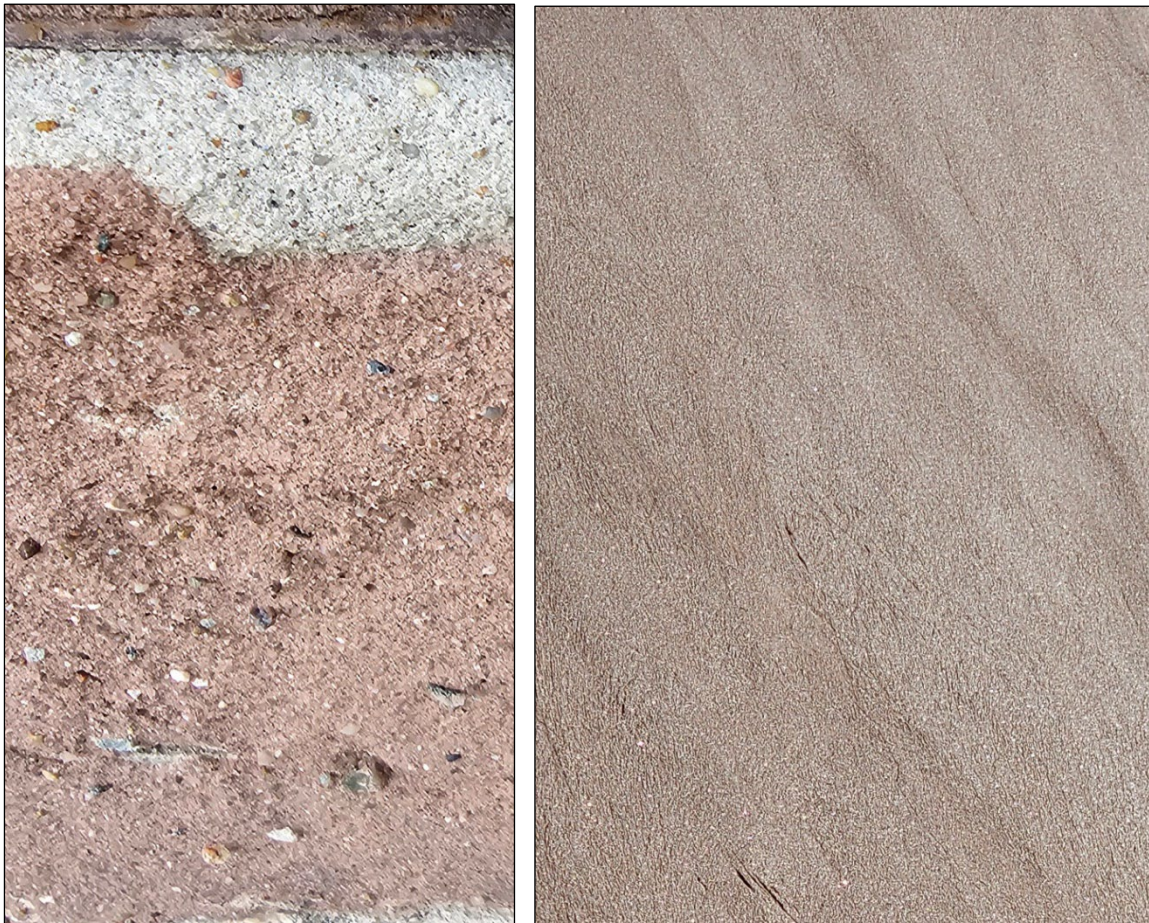
Il. 34. i 35. Pierwotne, barwione w masie tynki zachowane w elewacji południowej.
