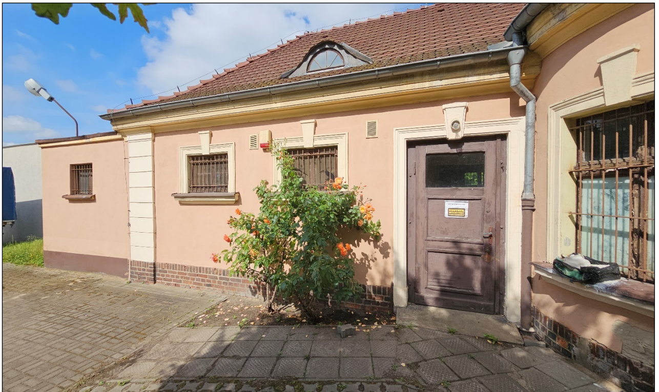
Fot. 33. Budynek dawnej zwierzętarni. Południowy odcinek elewacji frontowej - wschodniej.
