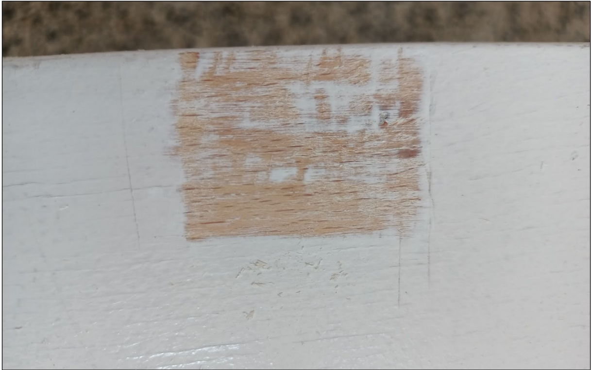
Il. 43. Jedna z odkrywek wykonanych na powierzchni drewnianych ławek. Malowanie wielokrotne farbami białymi.
