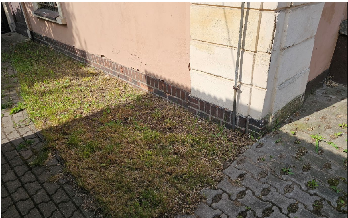
Fot. 37. Budynek dawnej zwierzętarni. Klinkierowy cokół budynku i nawierzchnie z kostki betonowej w sąsiedztwie.
