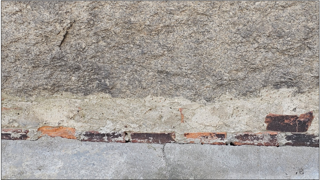
Il. 13. Odsłonięta podmurówka ceglana pod granitowym cokółem w elewacji południowej.
