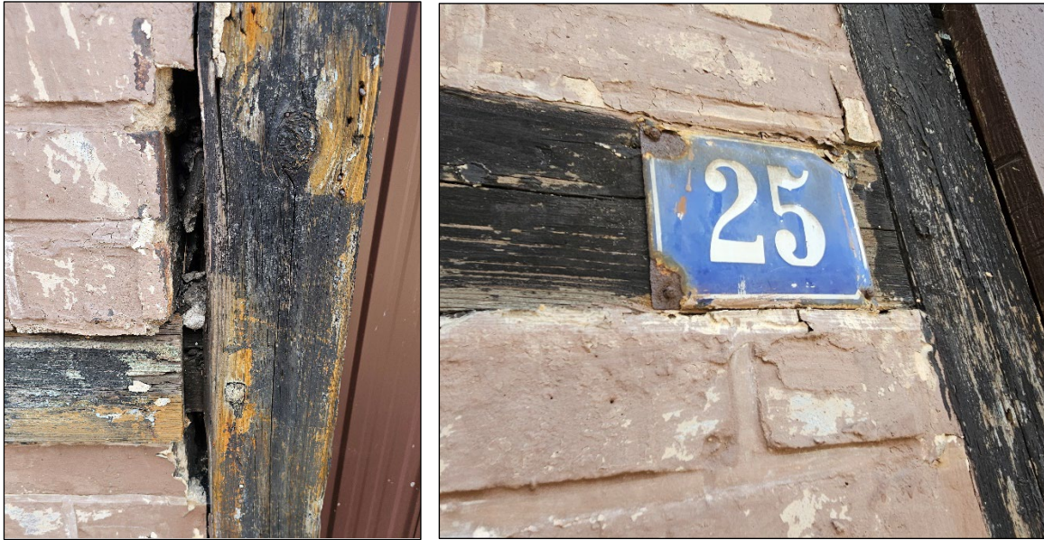
Il. 50. i 51. Drewniane elementy konstrukcji ryglowej zabezpieczone ciemnymi impregnatami do drewna. Wypełnienie ceglane w kolorze naturalnym cegły klinkierowej łączonej jasną spoiną wapienną.
