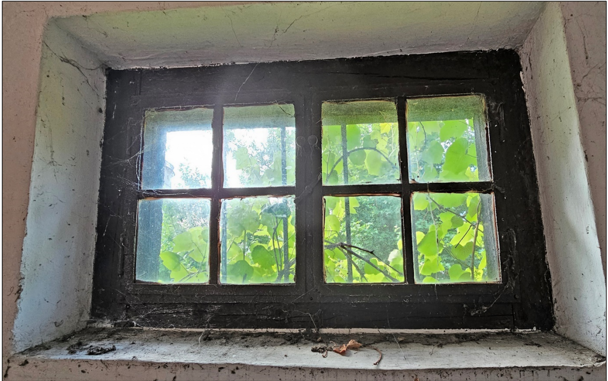
Fot. 48. Budynek gospodarczy. Wewnętrzna strona ślusarki okiennej w ścianie południowej.
