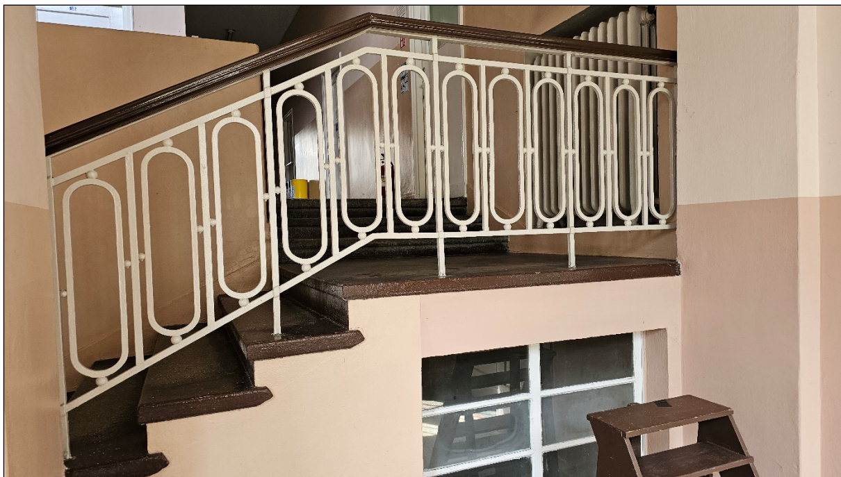
Fot. 26. Balustrada początkowego biegu schodów.
