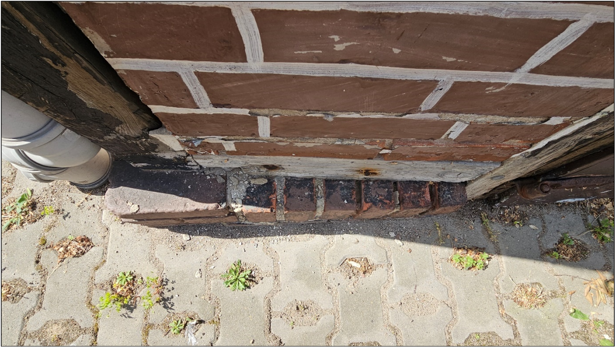
Fot. 43. Budynek gospodarczy. Widok na cokół ceglany. Wypełnienie ceglane fach malowane wtórnie farbami elewacyjnymi..
