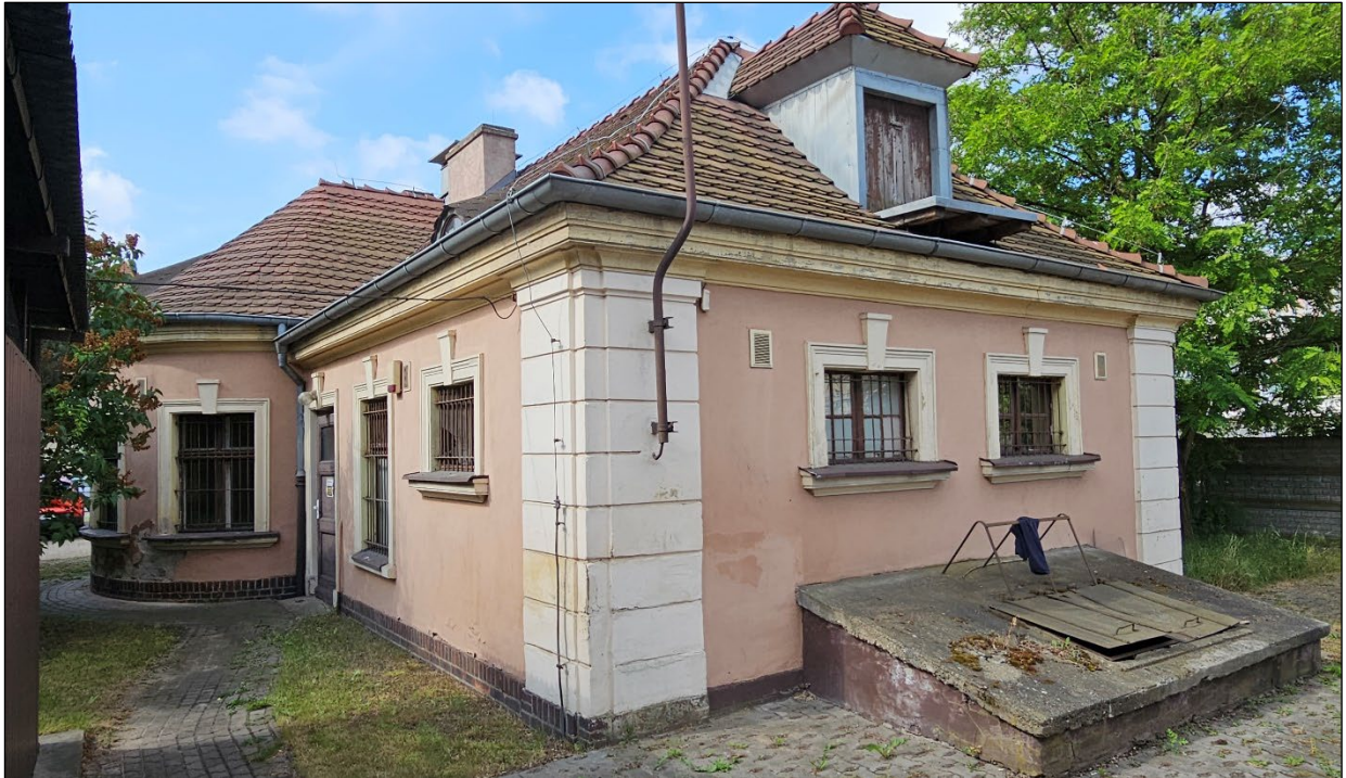
Fot. 28. Budynek dawnej zwierzętarni. Widok ogólny od strony północno wschodniej.
