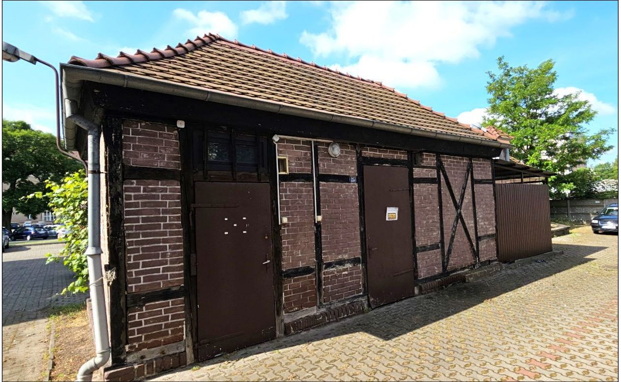
Fot.41. Budynek gospodarczy. Widok ogólny od strony północno wschodniej.
