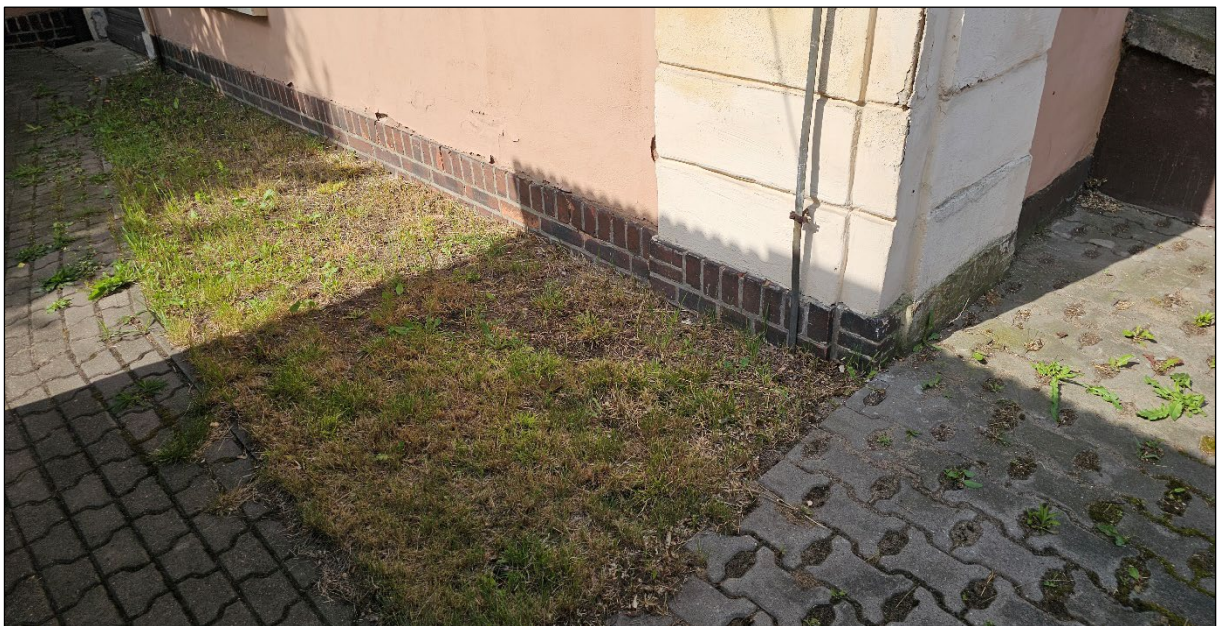
Il. 19. i 20. Na fotografii górnej piwnica z ocembrowaniem i zadaszaniem przy północnej, szczytowej elewacji budynku. Poniżej nawierzchnia wzdłuż północnego skrzydła (el. frontowa).
