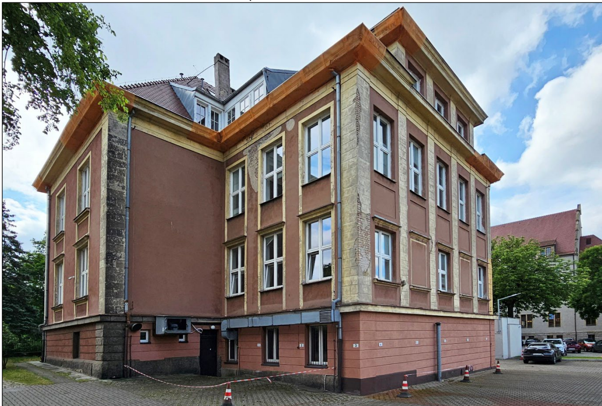
Fot. 8. Widok ogólny budynku frontowego od strony północno zachodniej, z poziomu dziedzińca.
