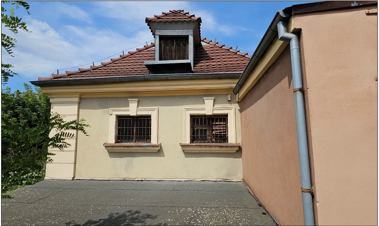
Fot. 32. Budynek dawnej zwierzętarni. Elewacja szczytowa - południowa.
