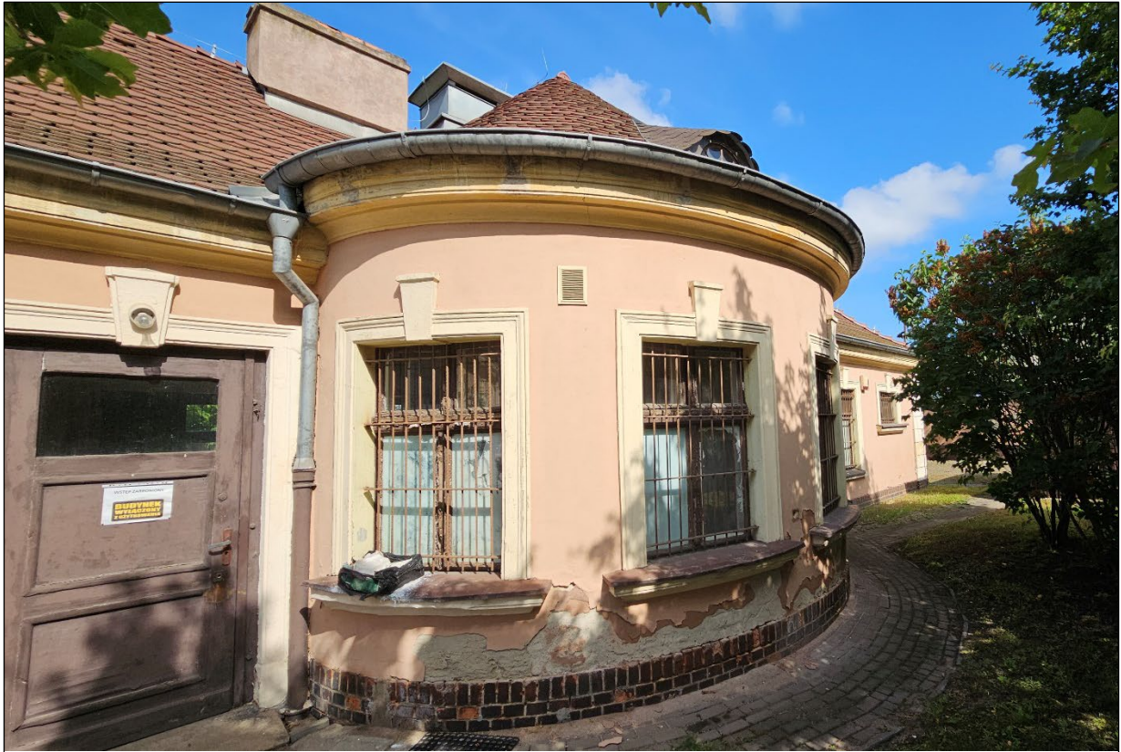
Fot. 34. Budynek dawnej zwierzętarni. Ryzalit na osi elewacji frontowej - wschodniej.
