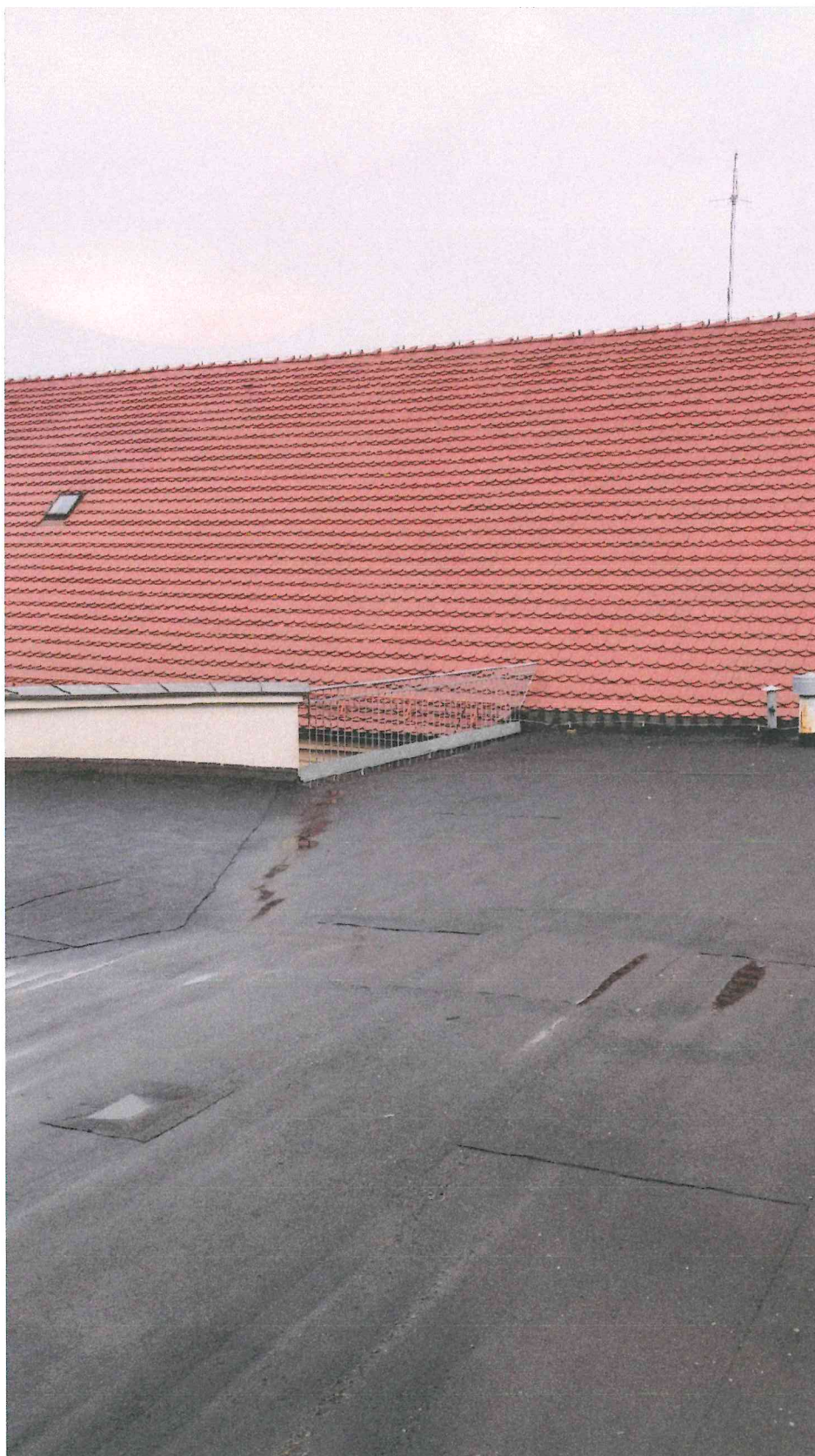
Zdjęcie nr 4. Przekrycie dachu budynku głównego z papy i dachówki ceramicznej.
