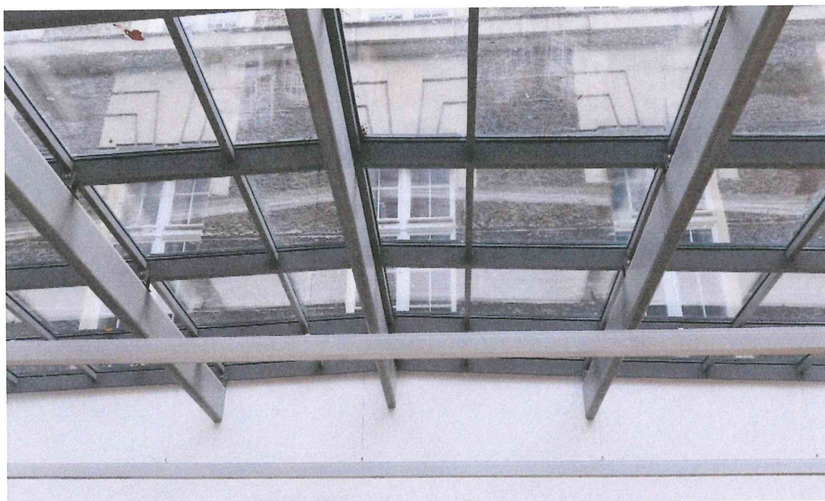
Zdjęcie nr 5. Przeszklenie dachu łącznika pomiędzy Budynkiem Głównym a Biblioteką.
