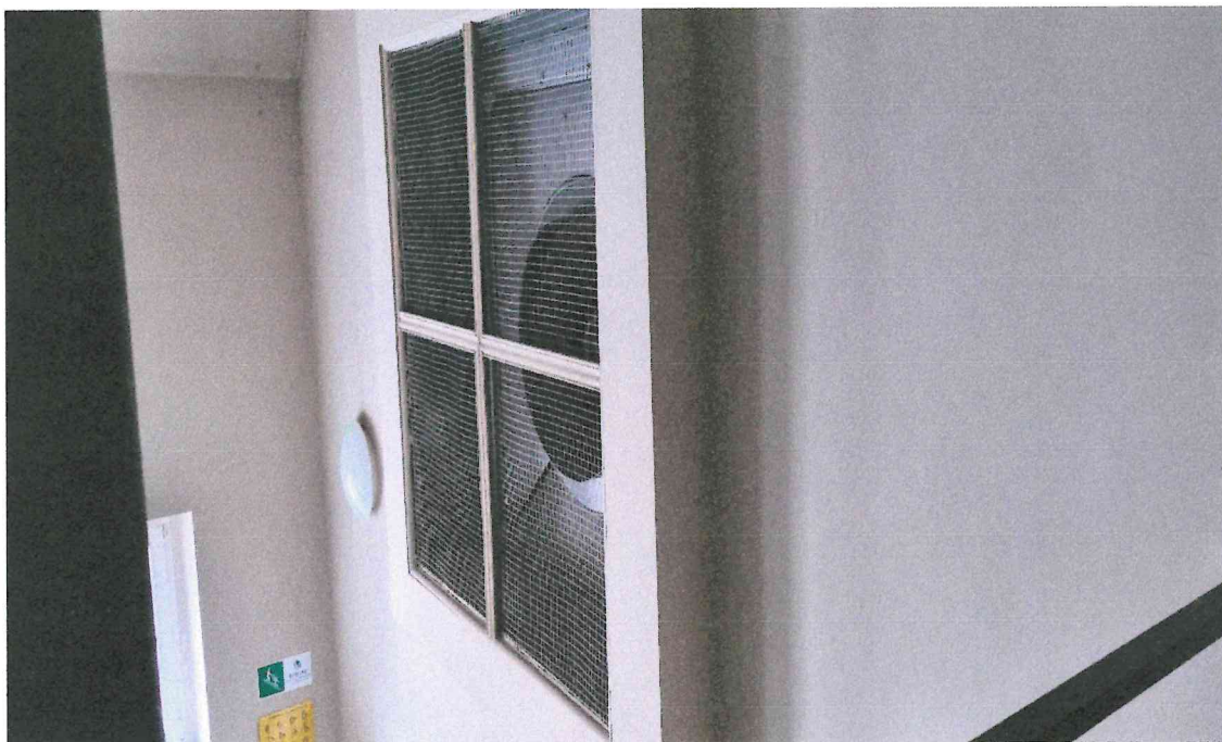
Zdjęcie nr 8. Wentylator systemu napowietrzania klatki schodowej KS 6.
