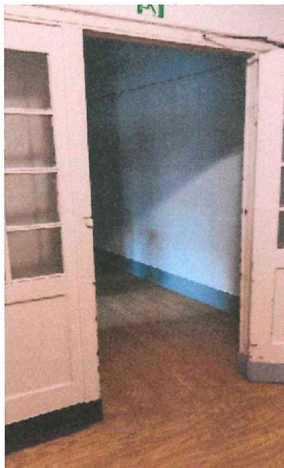
Zdjęcie nr 9. Wyjście z klatki schodowej KS5, szerokość drzwi wynosząca 0,685 m.
