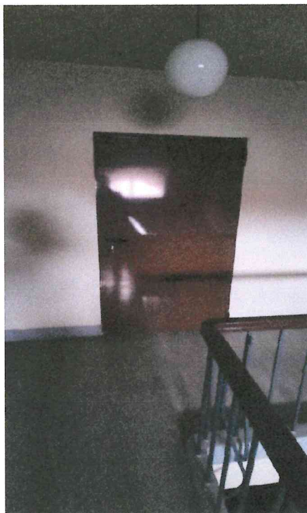
Zdjęcie nr 10. Drzwi prowadzące na poddasze z klatki schodowej KS1 – bez klasy odporności ogniowej.
