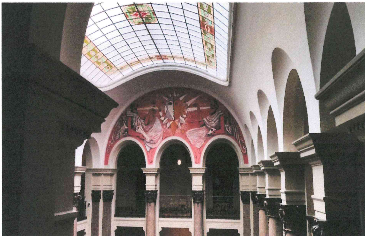
Zdjęcie nr 15. Przeszklenie nawy głównej holu – przestrzeń stanowiąca czasowy zbiornik dymu.
