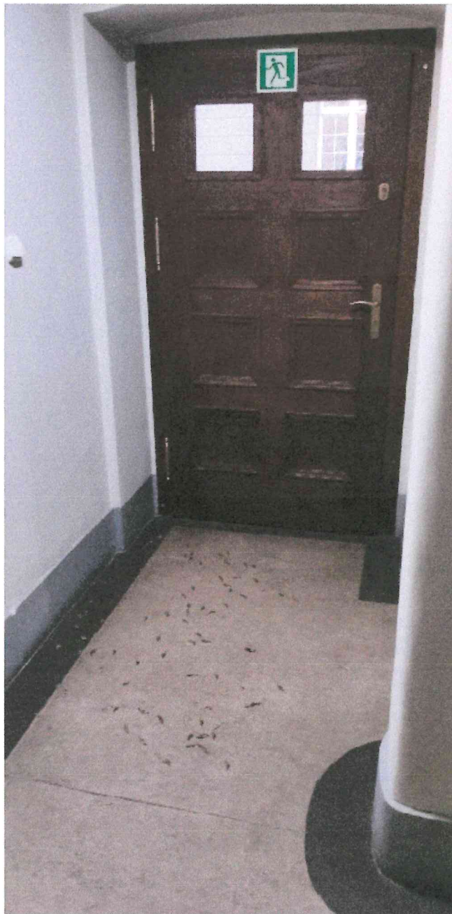
Zdjęcie nr 20. Przewężenie na parterze klatki KS2.
