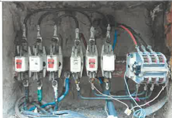
Podstawy bezpiecznikowe patrząc od strony lewej:
