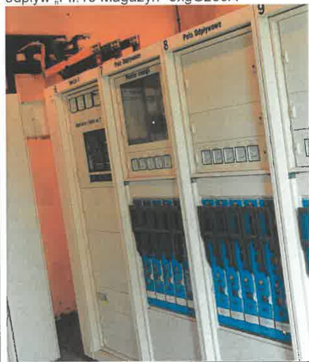
Zabezpieczenie w stacji transformatorowej odpływ „FII.10 Magazyn” 3xgG250A
