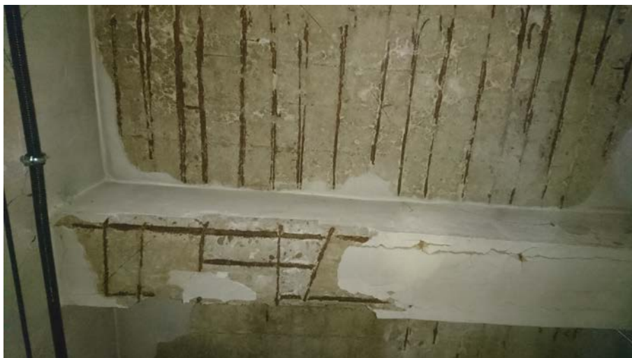
Fot. 7.2 Brak otuliny, widoczne zbrojenie belek rusztu pomiędzy osiami 4-10 i B-C.
