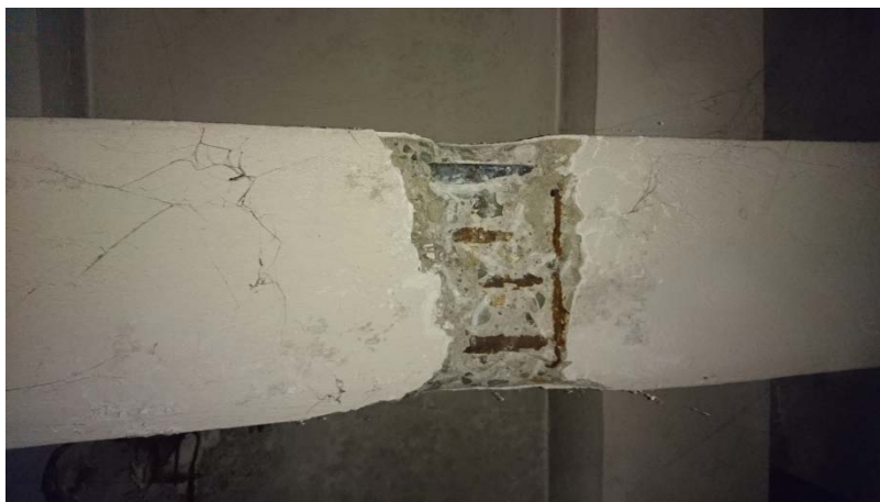
Fot. 6.6 Zbrojenie belki BI-4.
