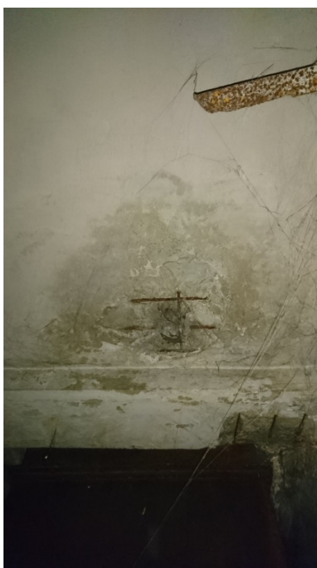
Fot. 7.3 Braki fragmentów betonu w płycie.
