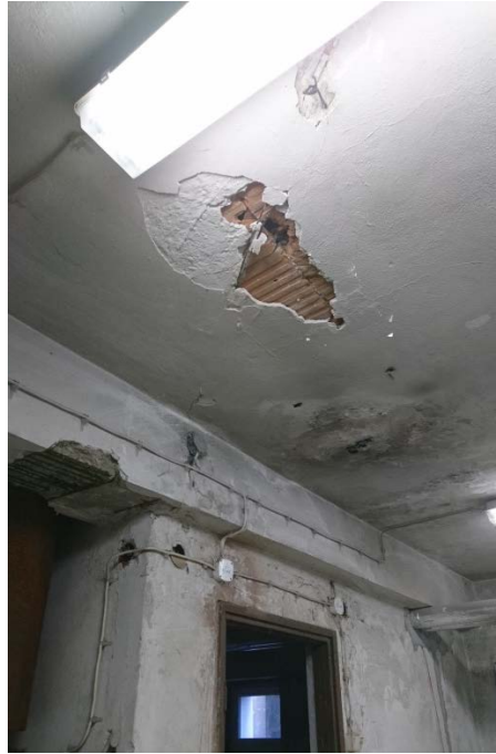
Fot. 6.8 Odkrywka w płycie Pł-5 – strop Ackermana.
