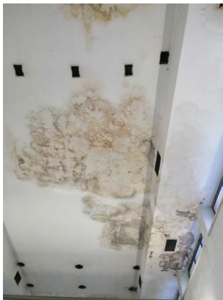
Fot. 7.8 Zalanie stropodachu.
