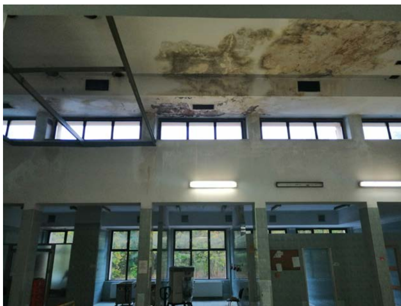
Fot. 7.7 Zalania widoczne na stropodachu.
