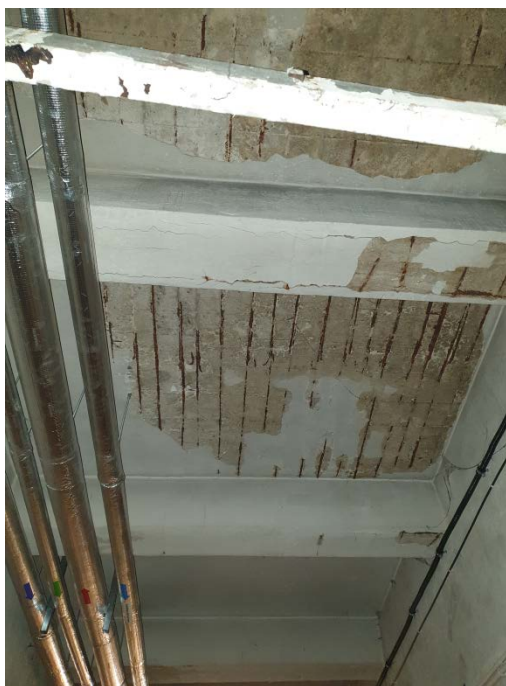
Fot. 7.1 Widoczne zbrojenie, brak otuliny w płycie i belce osie 4-5 i A-B.
