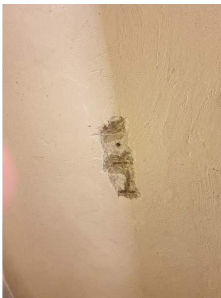
Fot. 6.2 Zbrojenie płyty Pł-1.
