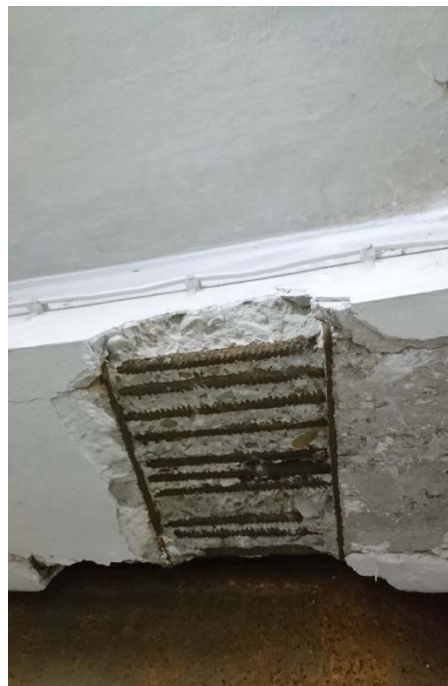
Fot. 6.9 Zbrojenie belki B-14.
