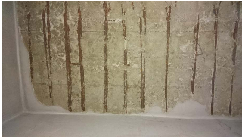
Fot. 6.4 Zbrojenie płyty Pł-2.
