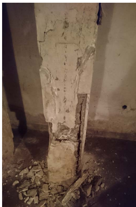
Fot. 6.7 Zbrojenie słupa S-1.
