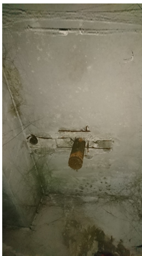
Fot. 7.4 Braki fragmentów betonu w okolicy przejścia rurowego.
