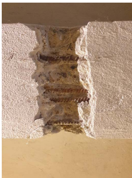
Fot. 6.1 Zbrojenie belki Bl-2.
