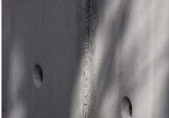
Fot. 5. Przesunięcie płaszczyzny- połączenie pionowe.
