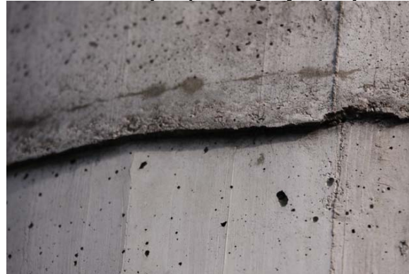
Fot. 6. Przesunięcie płaszczyzny – połączenie poziome.
