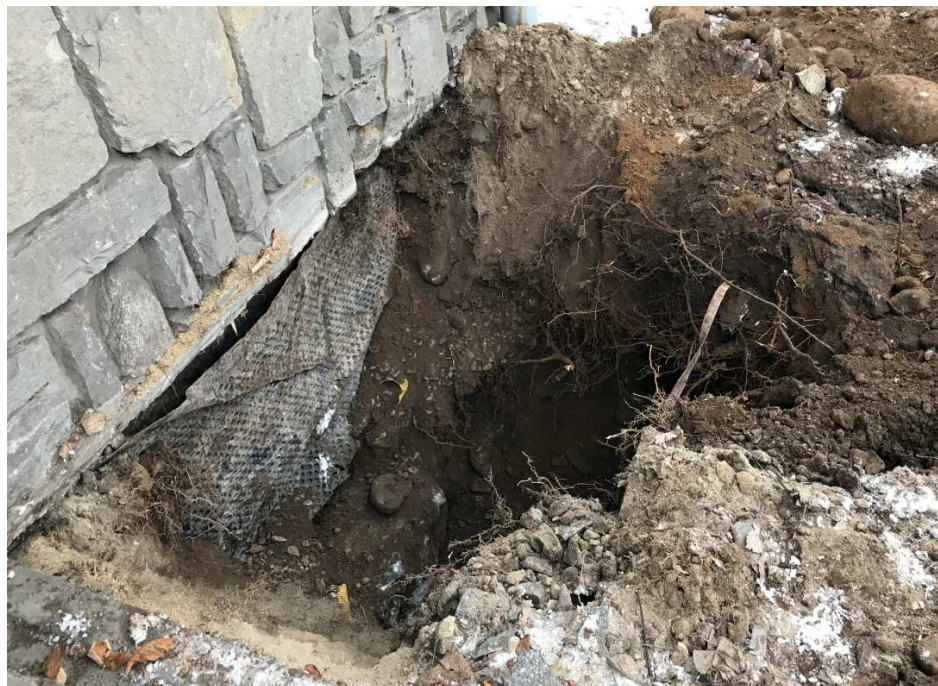
Rys. 5 Odkrywka fundamentu nr 2 (część murowana budynku)
