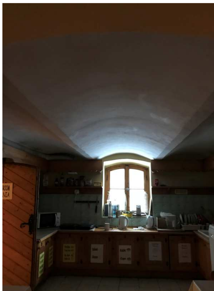
Rys. 12 Strop łukowy nad piwnicą
