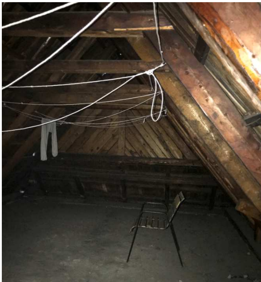
Rys. 14 Więźba dachowa – więźar jętkowy
