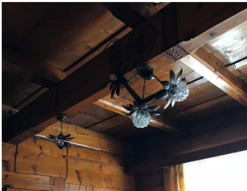
Rys. 6 Istniejący sosręb na poziomie stropu parteru
