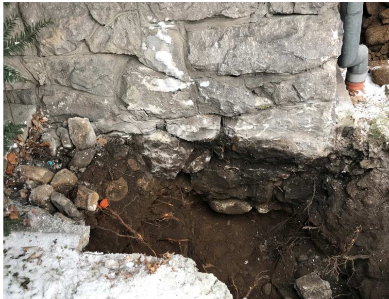
Rys. 4 Odkrywka fundamentu nr 1 (część drewniana budynku)
