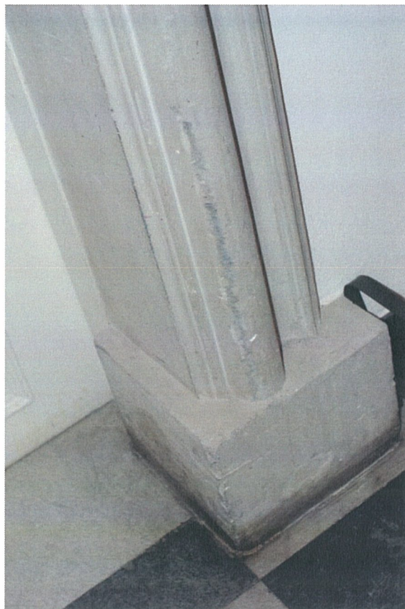
Fot.7. Obrazienie kamienne – widoczne otarcia i uszkodzenia mechaniczne
