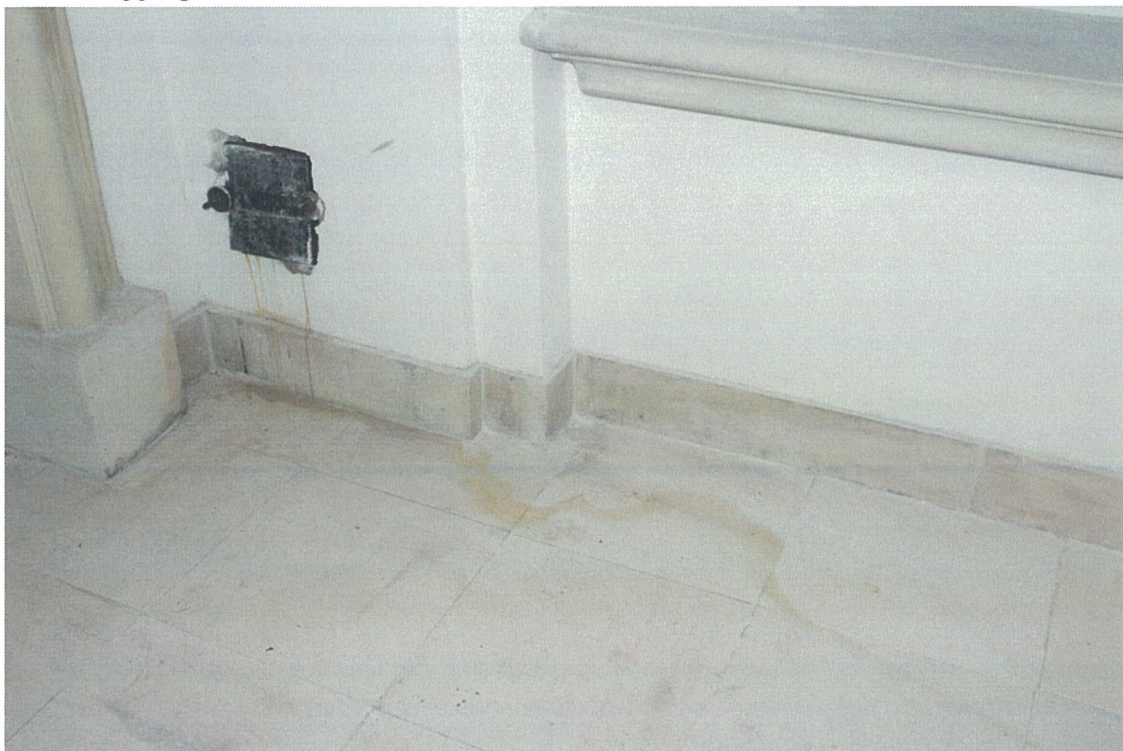
Fot.7. Widoczne ślady zalania z rury spustowej na loggii południowo-wschodniej.
