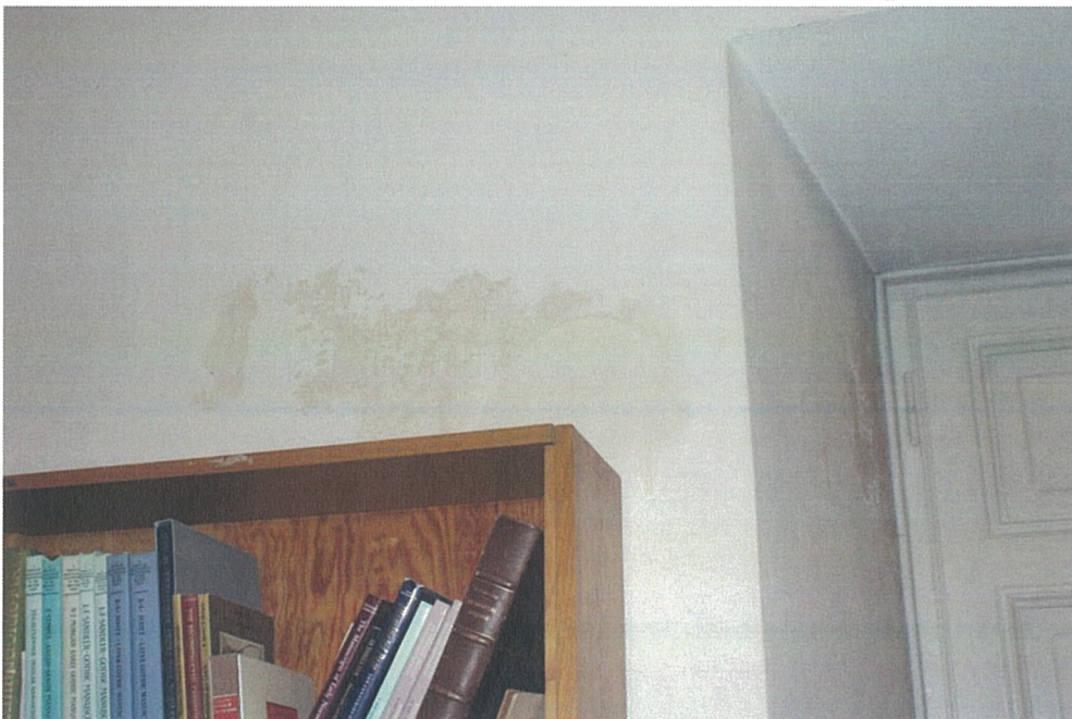
Fot.5. Pomieszczenie nr 30 – widoczne ślady zalania na ścianie południowej.
