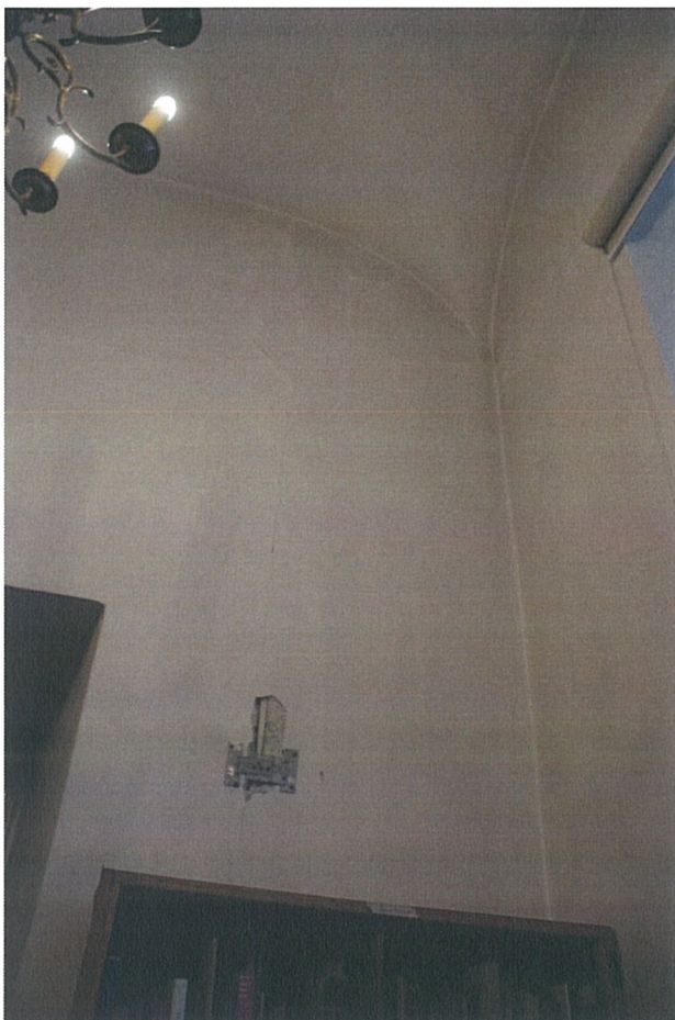
Fot.4. Zbliżenie – widoczne spękania i zabrudzenia w narożniku południowo-zachodnim.
