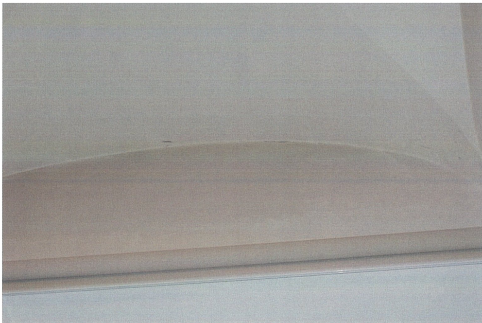
Fot.3. Pomieszczenie nr 30 – zbliżenie. Widoczne spękanie nad otworem okiennym.
