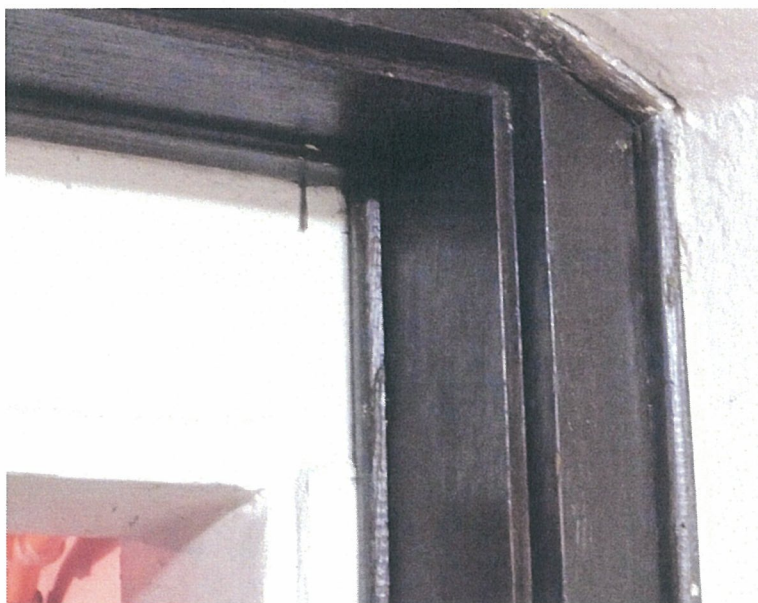
Przykład osadzenia nowych drzwi w starym mniejszym otworze w piwnicy
