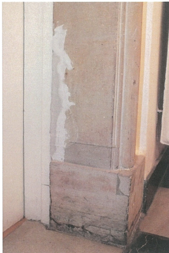
Liczne flekowania i zatarcia zaprawą w kamieniarce
