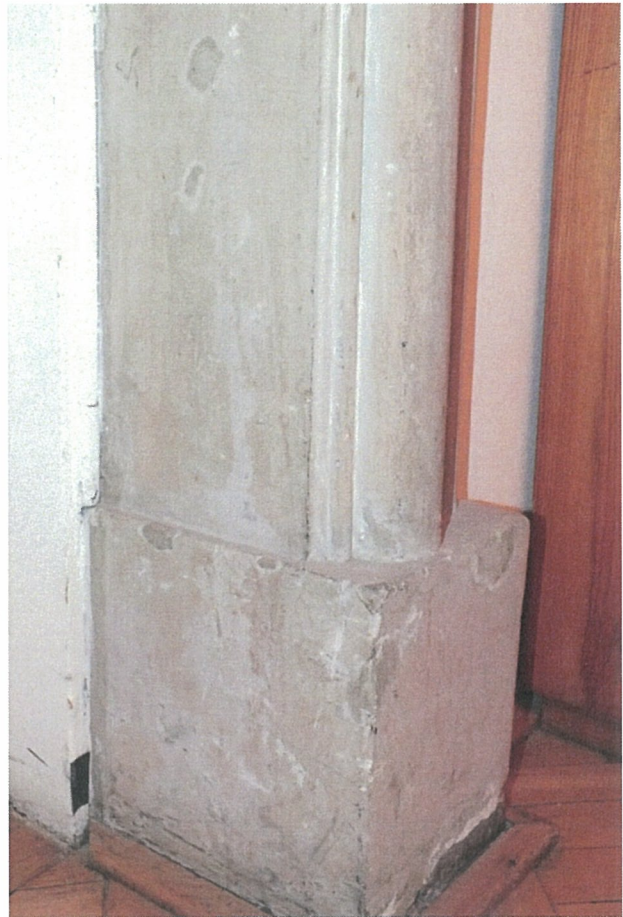
Inny przykład stanu zniszczenia obramienia kamiennego
