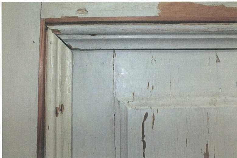
Stan zniszczenia drzwi, lub ich nie skończenia w magazynie na I piętrze
