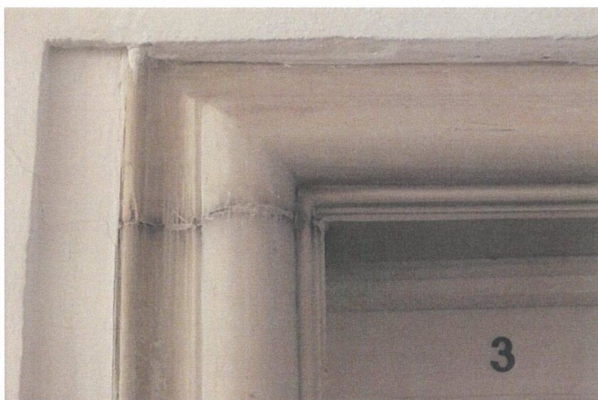
Nietypowy montaż obramienia drzwi ( drzwi nr 3)
