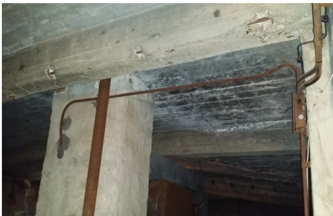
Fot. 3 – widoczne ubytki w otulinie zbrojenia głównego oraz montażowego.
