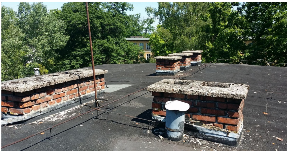
Fot. 1 – widoczne ubytki w spoinie kominów, ubytki w obróbkach blacharskich, nieodpowiedni san wywietrzaków wentylacyjnych.
