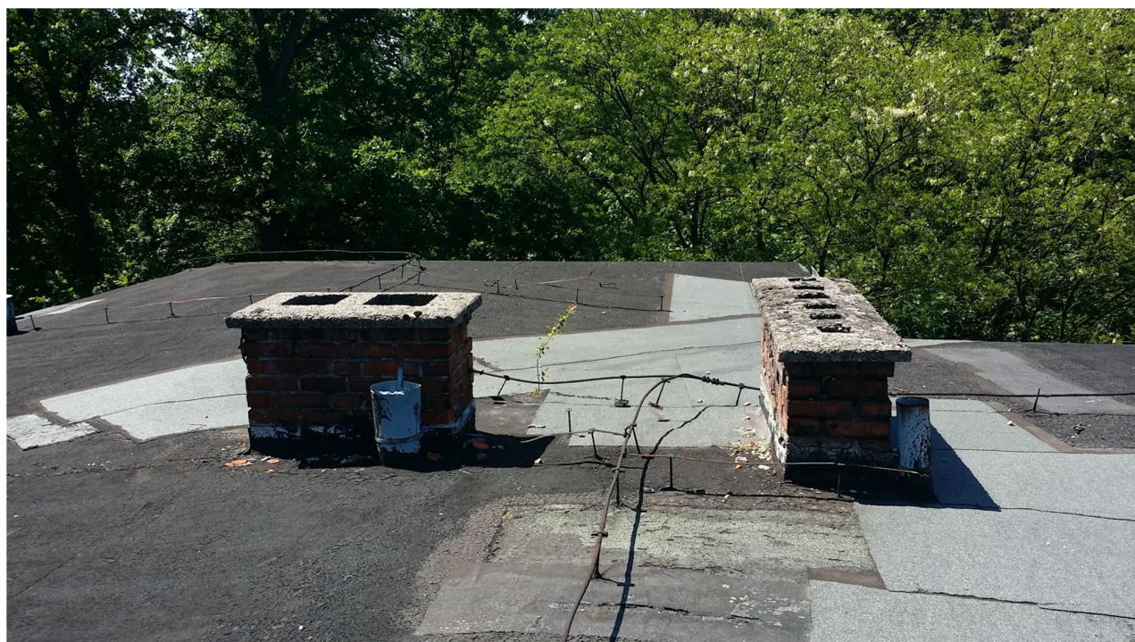
Fot. 2 – widoczne ubytki w spoinie kominów, ubytki w obróbkach blacharskich, nieodpowiedni san wywietrzaków wentylacyjnych. Widoczne porosty roślinnością na łączeniach spoinowania warstw papy.
