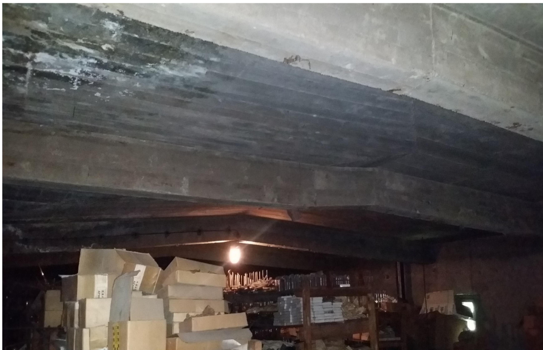
Fot. 3 – widoczne zacieki i wykwyty solne z zalewania konstrukcji dachu.
