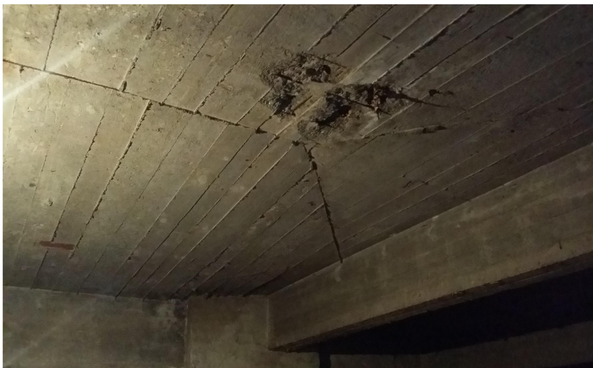
Fot. 3 – widoczne ubytki w otulinie zbrojenia głównego oraz montażowego.
