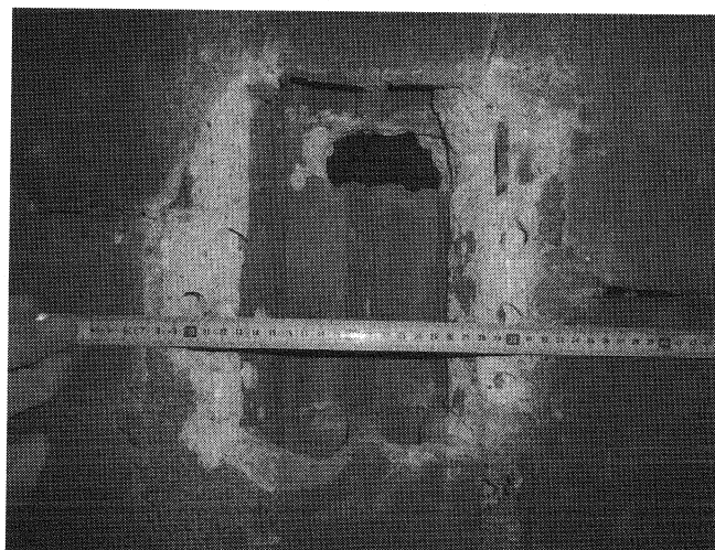
Fot. 6 Odkrywka płyty stropodachowej – pomiar rozstawu prętów zbrojenia dolnego płyty
