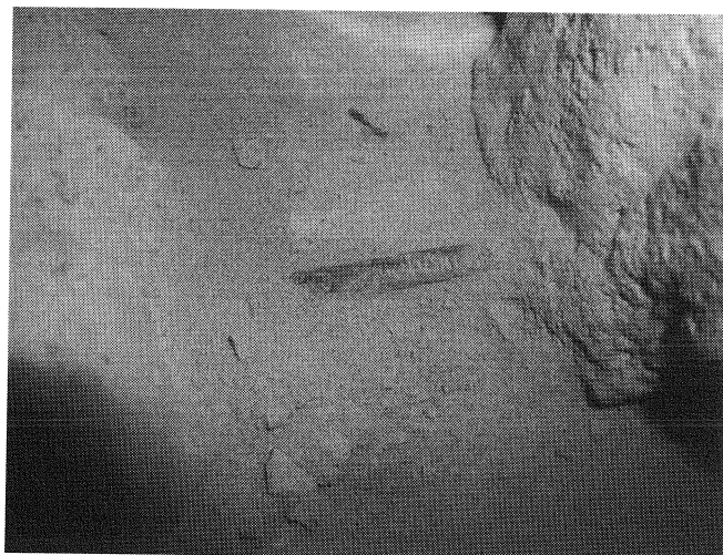
Fot. 8 Odkrywka zbrojenia dolnego płyty stropowej Kleina
