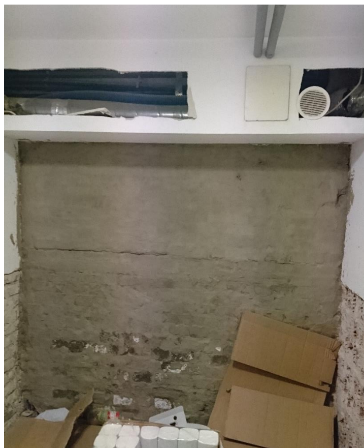
Fot. nr 8. Pomieszczenie nr 011 – widoczna zabudowa z płyt g-k do uzupełnienia i ściana do tynkowania
