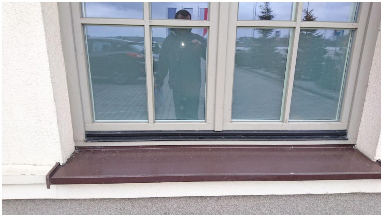
Fot. nr 11. We wszystkich oknach odnawianych należy stosować listwy odcinające słupek środkowy od ramy jak na powyższym zdjęciu.
