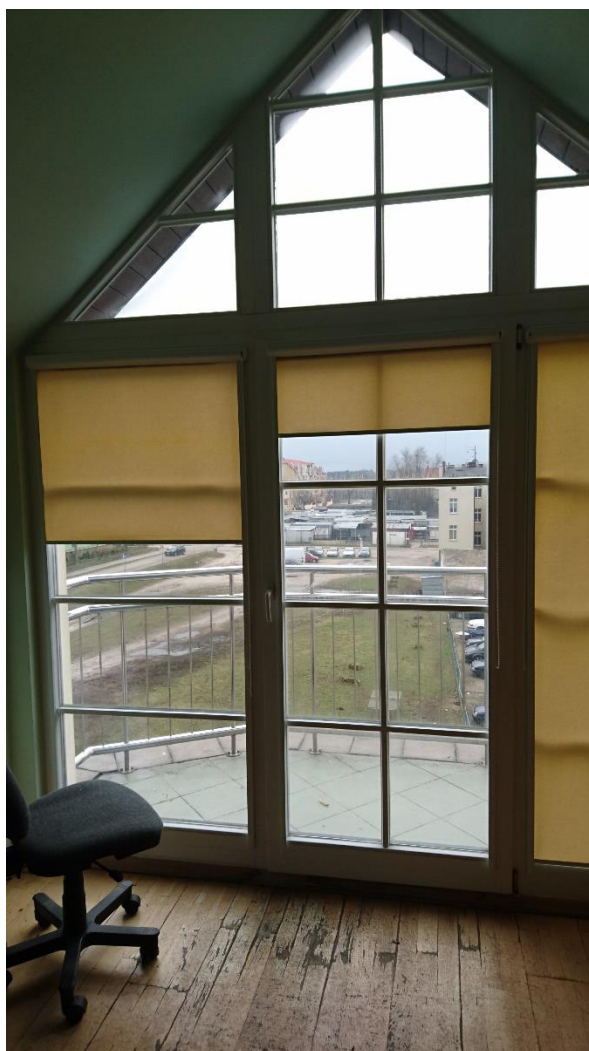
Fot. nr 12. Widok okna w pom nr 406 – w całości do wymiany.
