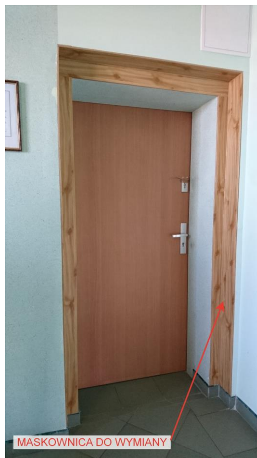
Drzwi D4/D7 – maskownica do wymiany
