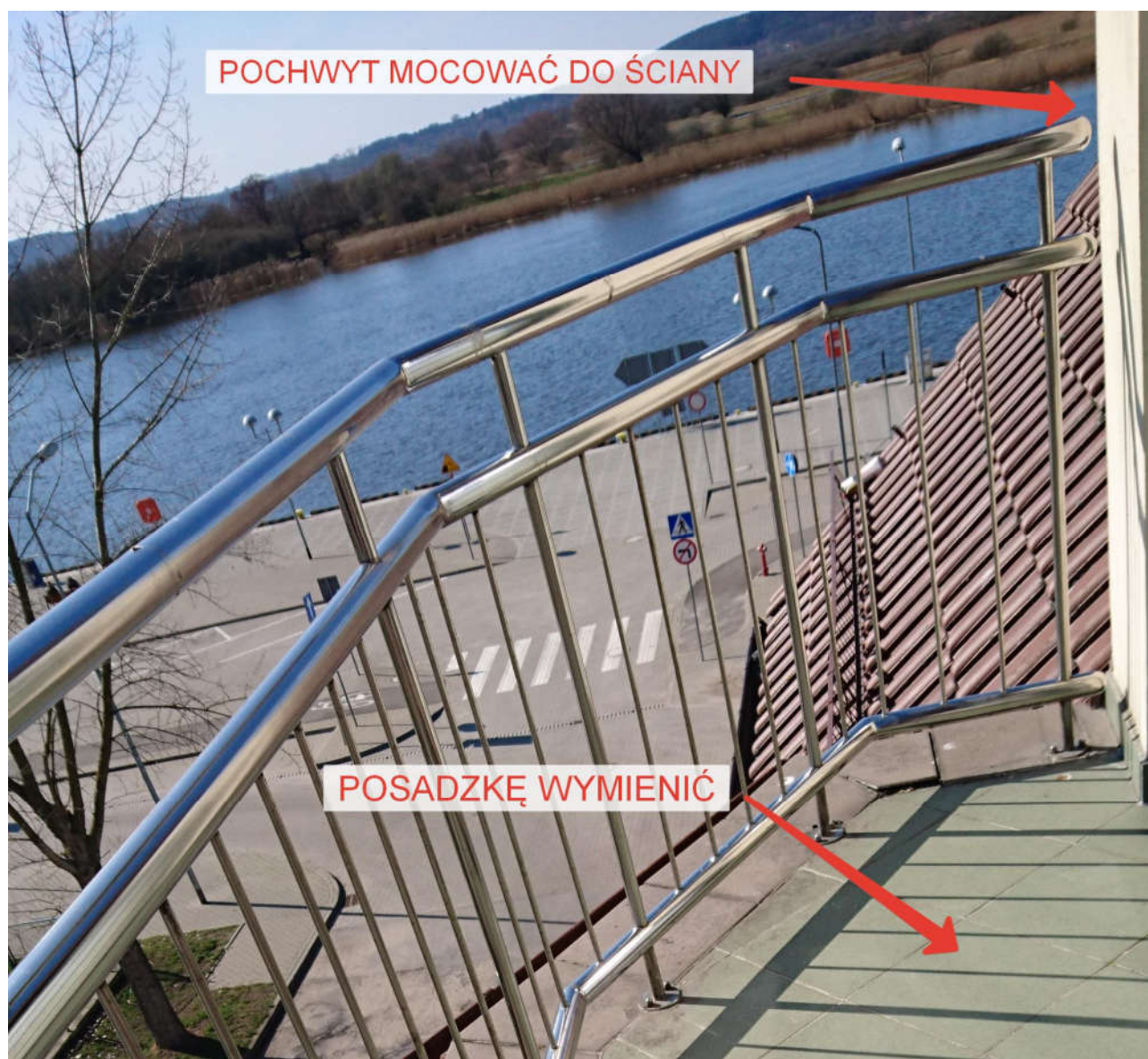
Fot. nr 15. Widok barierki na tarasie – pochwyt mocować do ściany.
