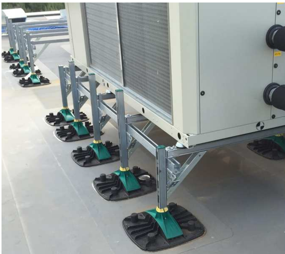
Rysunek 3. Widok systemu oparcia agregatów lub innych urządzeń wymagających wyniesienia
