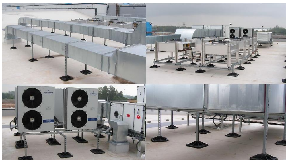
Rysunek 4. Widok systemu oparcia kanałów, instalacji lub innych urządzeń
