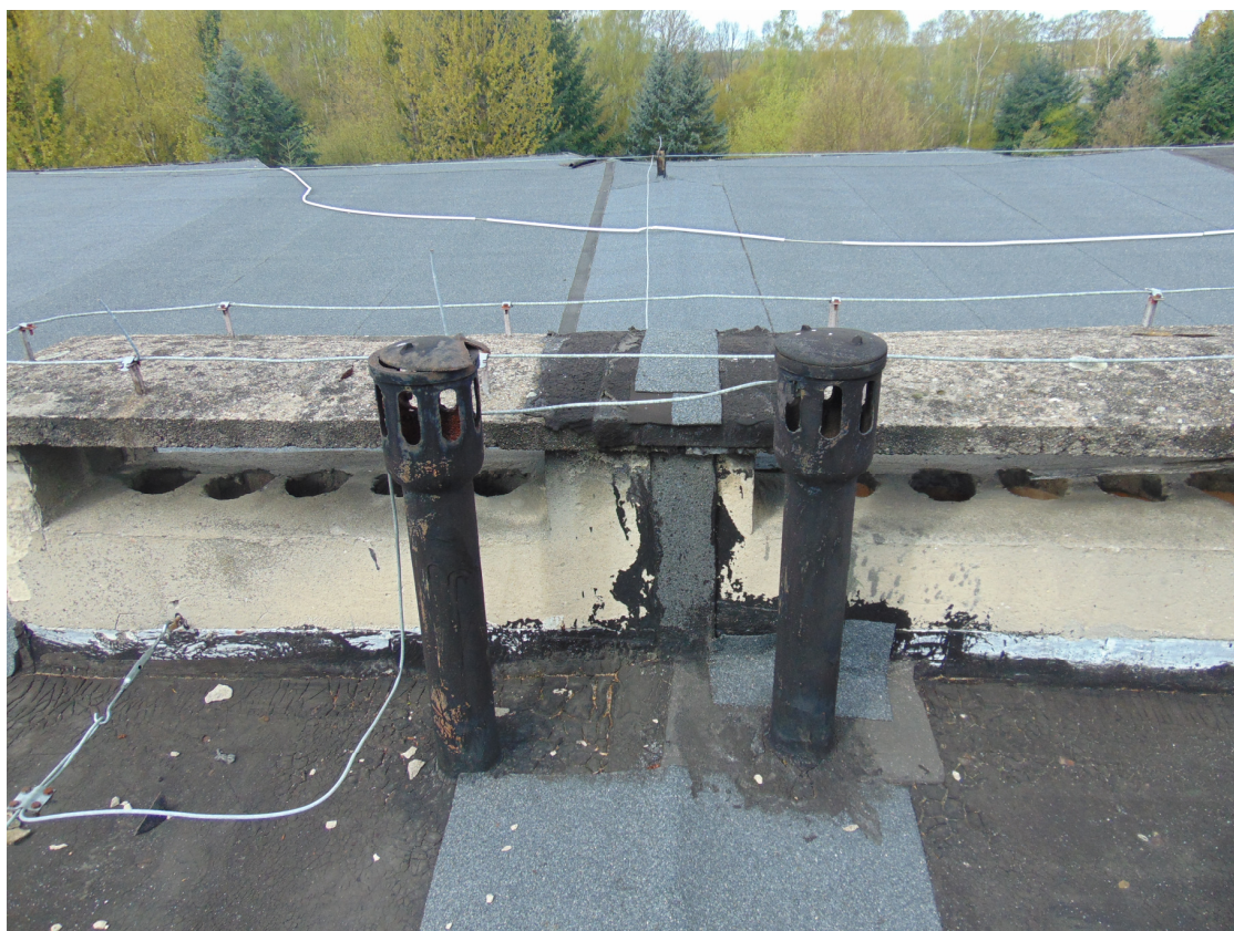
Zdjęcie nr 5 – widok dylatacji połaci dachowej i dylatacji komina
