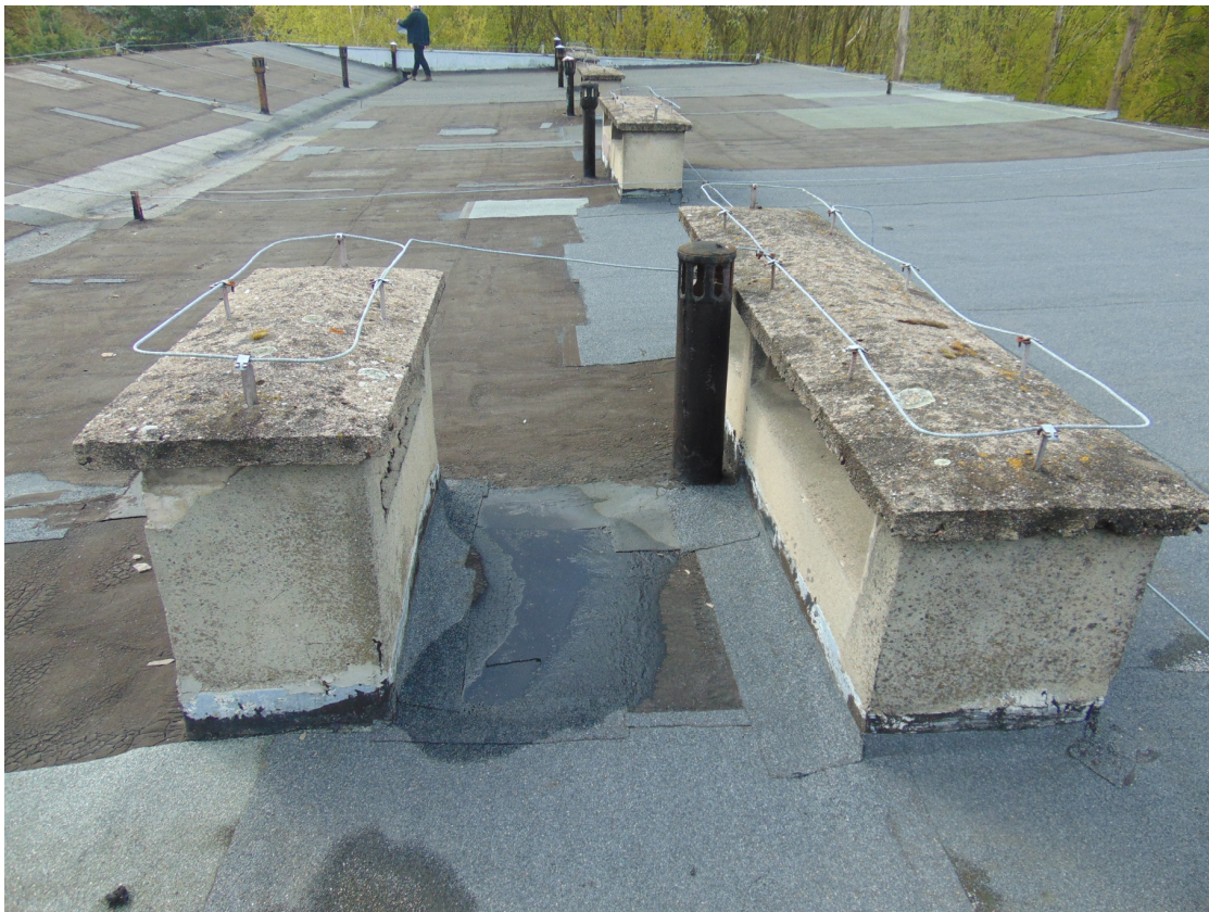
Zdjęcie nr 6 – Zastoje wody - brak odpowiednio wyprofilowanych przeciwspadków
