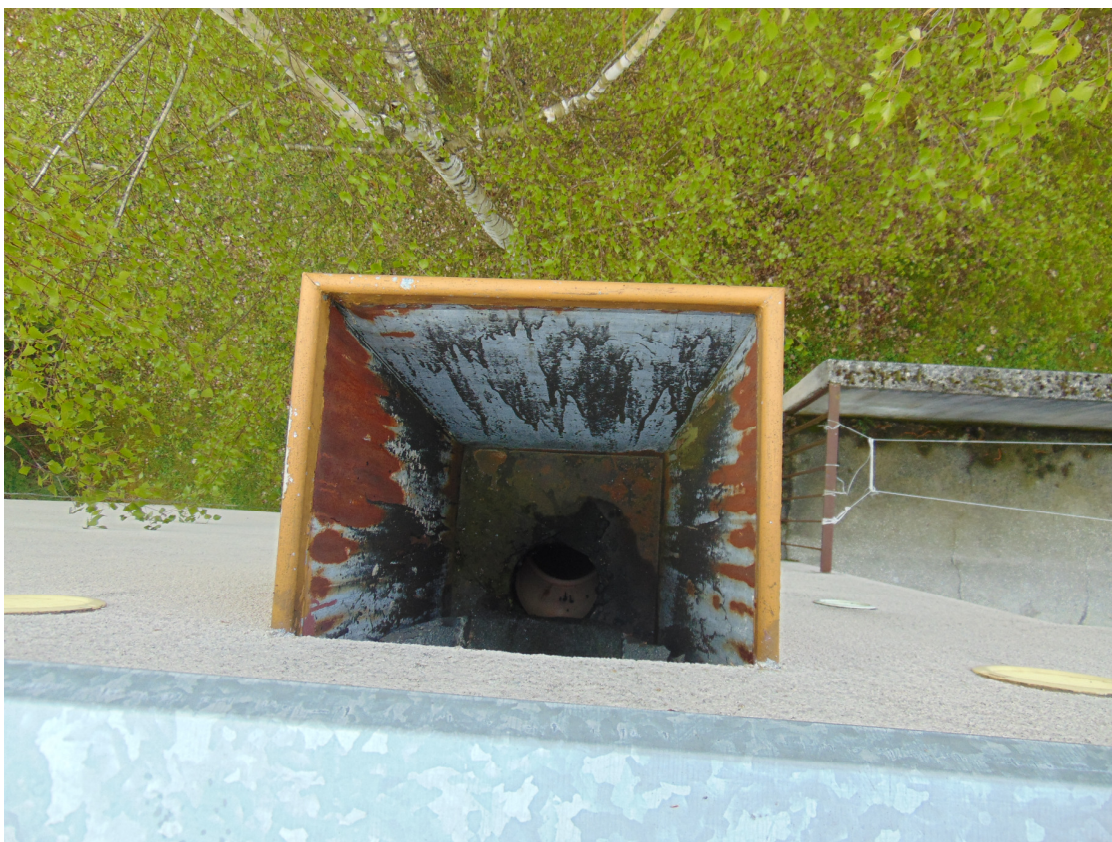
Zdjęcie nr 13 – mocno skorodowany jeden z trzech zbiorników zlewowych dachu budynku wysokiego
