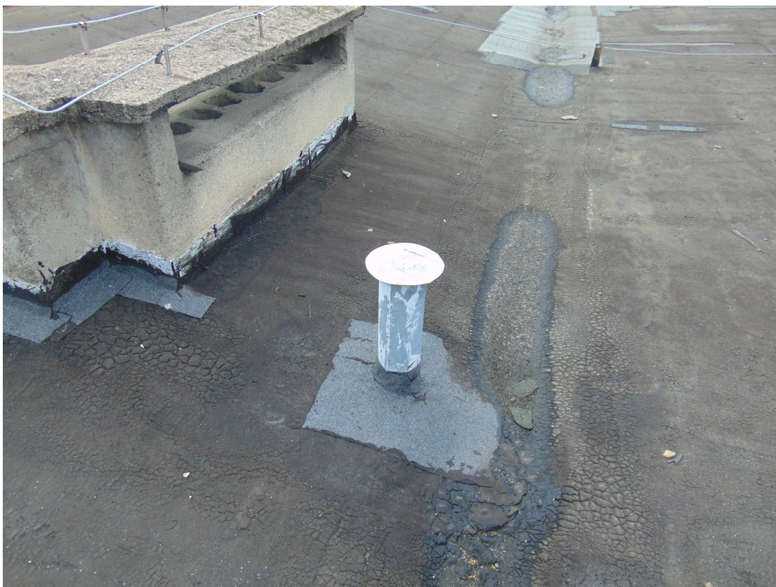
Zdjęcie nr 7 – widok prowizorycznego kominka wywiewnego kanalizacji sanitarnej
