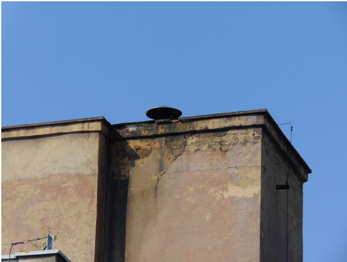
Zdjęcie nr 11 – widok głowicy komina kotłowni – widoczne uszkodzenia blacharki, tynku oraz spękania
