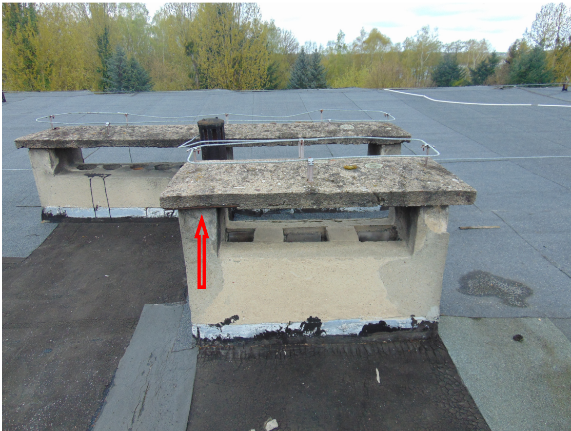
Zdjęcie nr 10 – widok jednej z 15 uszkodzonych czap – widoczne zbrojenie – strzałka
