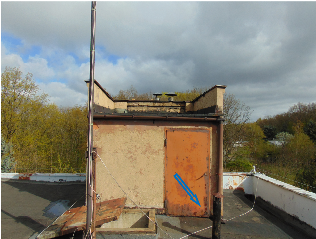
Zdjęcie nr 12 – uszkodzenia drzwi stalowych spowodowane korozją - strzałka
