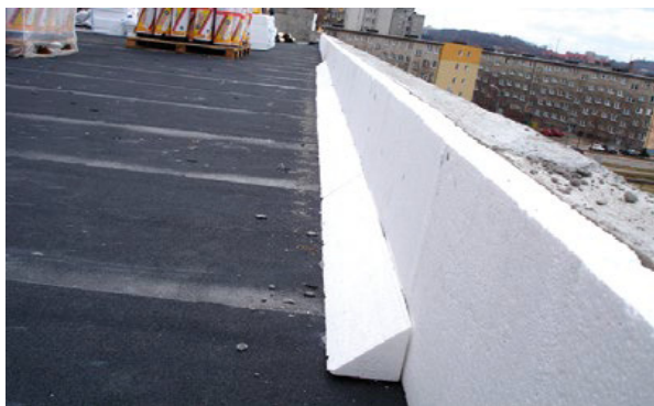
Styk powierzchni pionowej z poziomą
