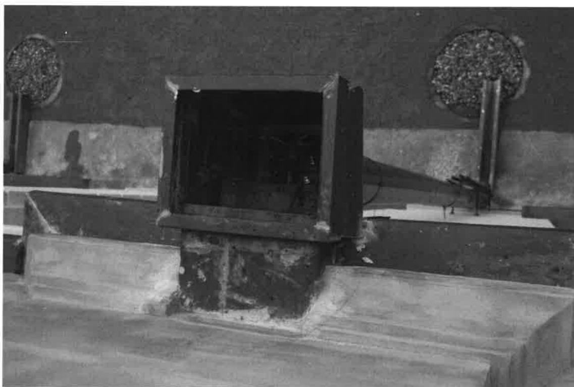
Fot. Kosz zbierający wodę z tarasu do rury spustowej
