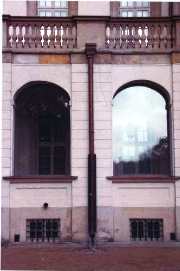
Fot. Rura spustowa z koszem odprowadzająca wodę
