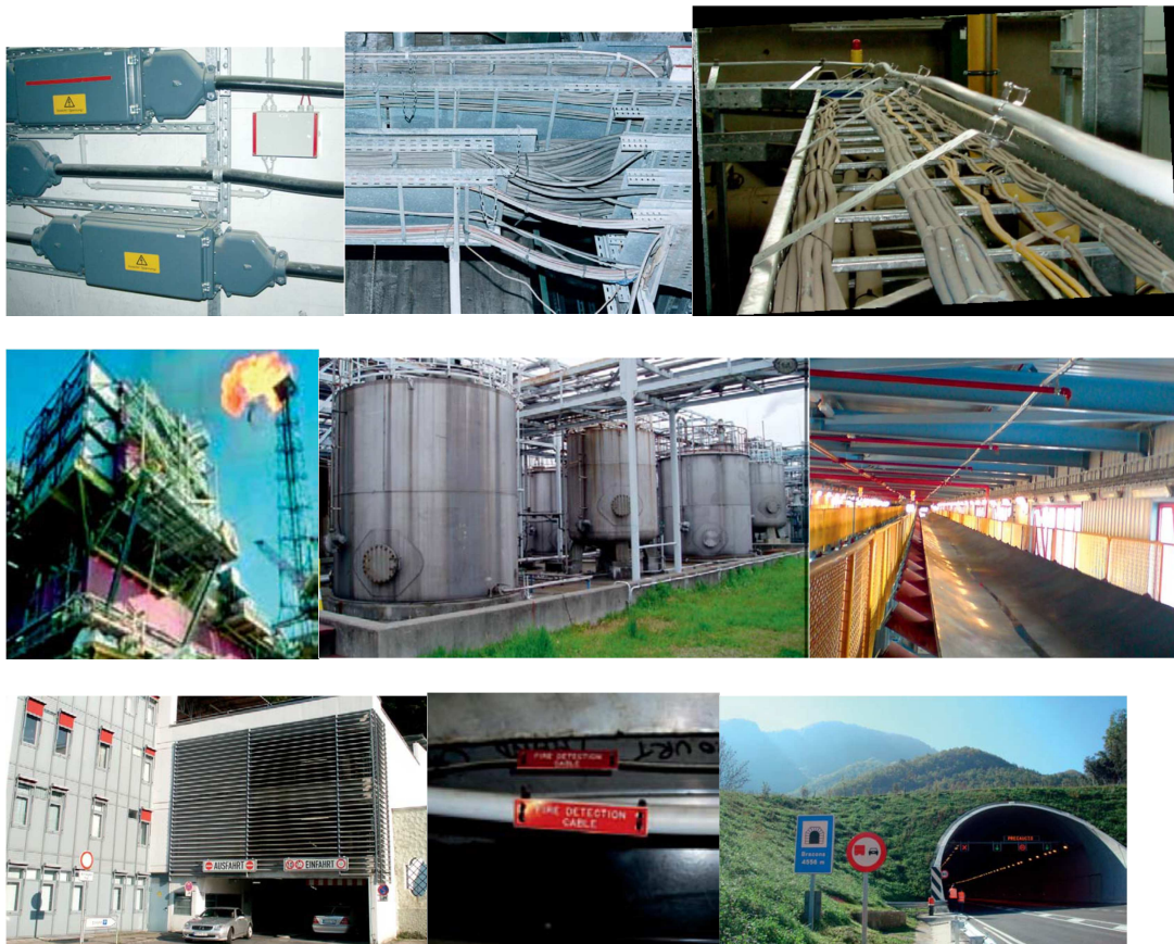
Zdj.1 Typowe zastosowania liniowej czujki ciepła
