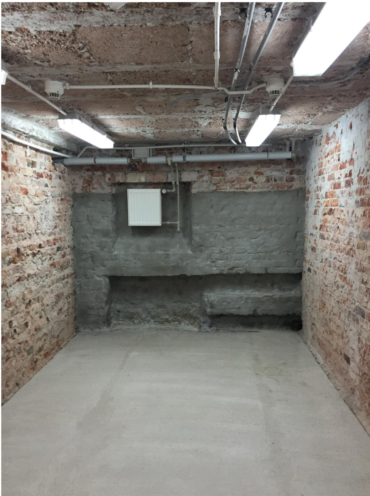
Fotografia 8. Cella po osuszaniu ze zdjętym tynkiem.
