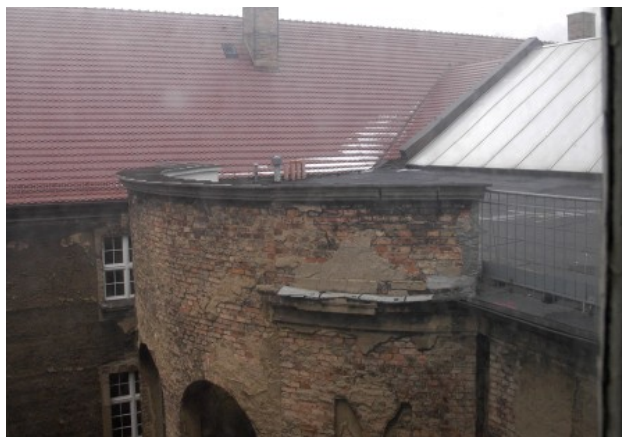
FOT.5 Widok ściany dziedzińca wewnętrznego – zniszczone tynki.
