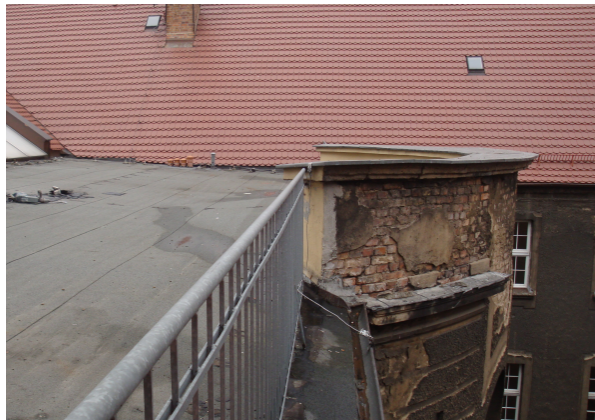
FOT.4 Widok ściany dziedzińca wewnętrznego – zniszczone tynki.
