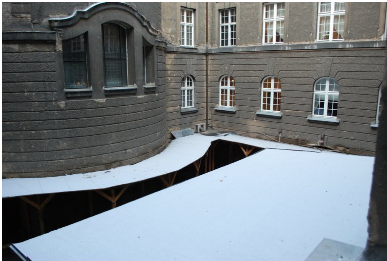
Fot. 4 Widok na elewację wschodnią dziedzińca wschodniego. Widoczne silne zabrudzenia oraz zniszczenia tynków i detalu architektonicznego.
