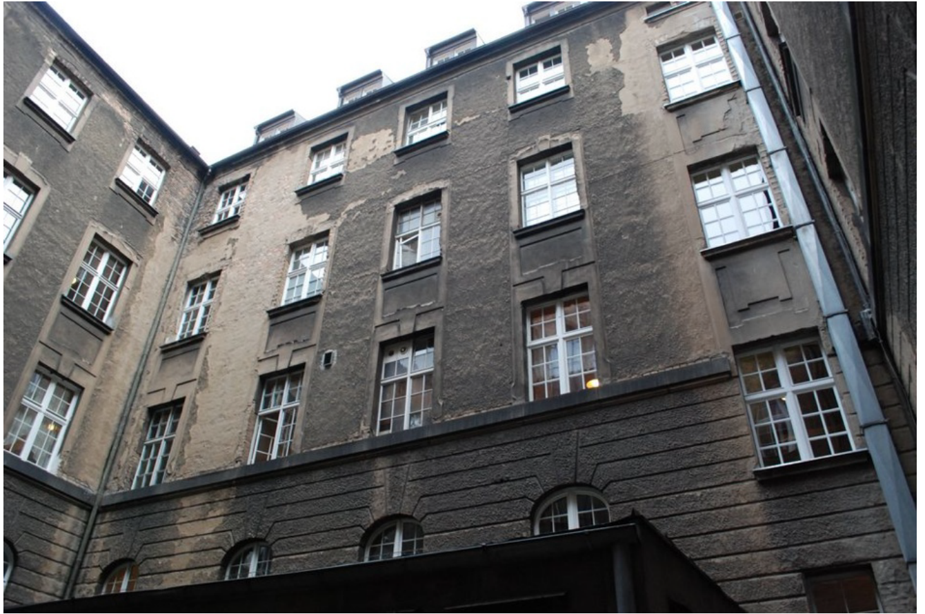
Fot. 3 Widok na elewację północną dziedzińca wschodniego. Widoczne silne zabrudzenia oraz zniszczenia tynków.
