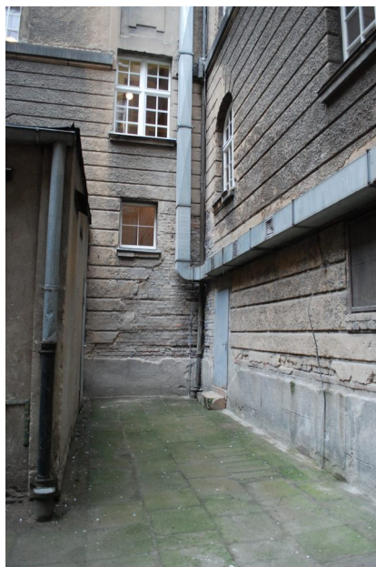
12. Widok na istniejące drzwi oraz kanał wentylacyjny przeznaczony do likwidacji, pierzeja południowa
