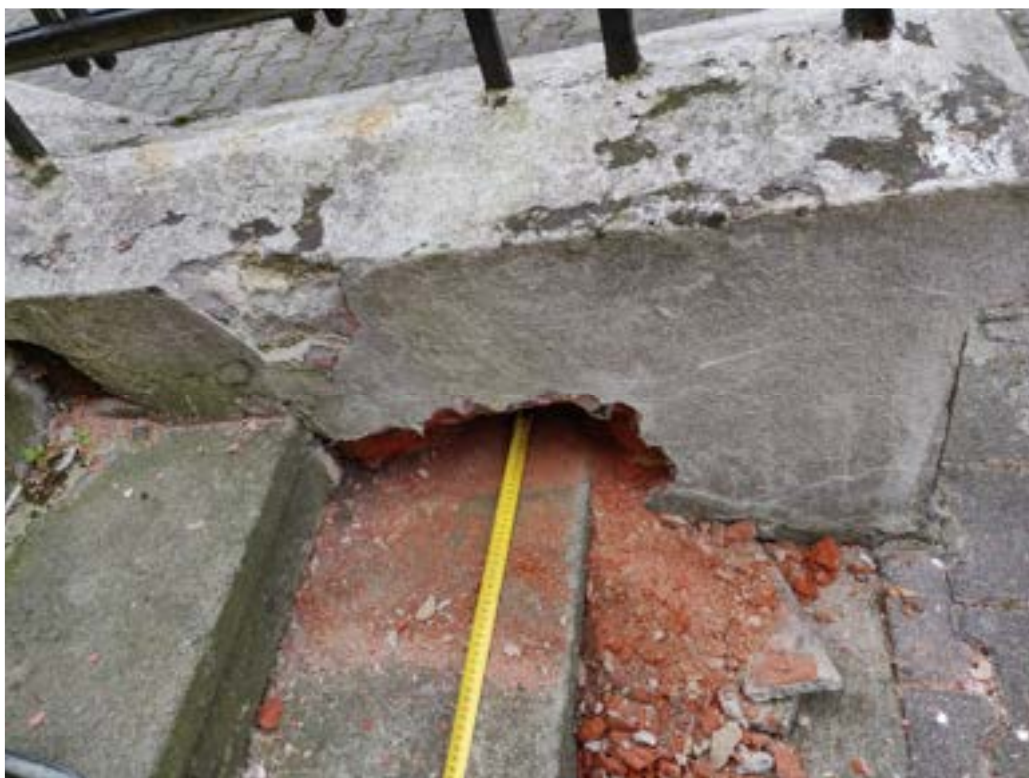
Fot. 23. Sposób osadzenia stopni granitowych w murkach bocznych schodów – w ½ cegły
