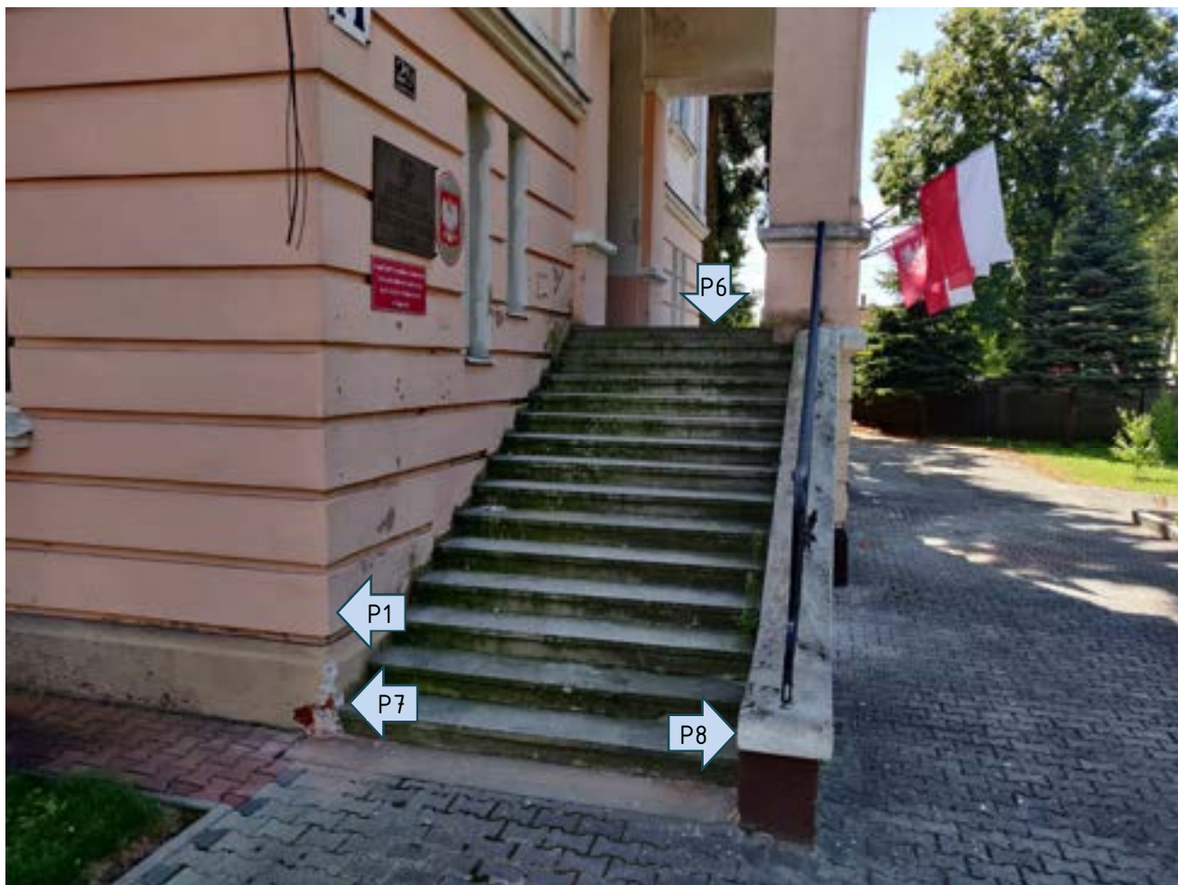
Fot. 41. Lokalizacja odkrywek na fragmentach elewacji zachodniej i północnej
