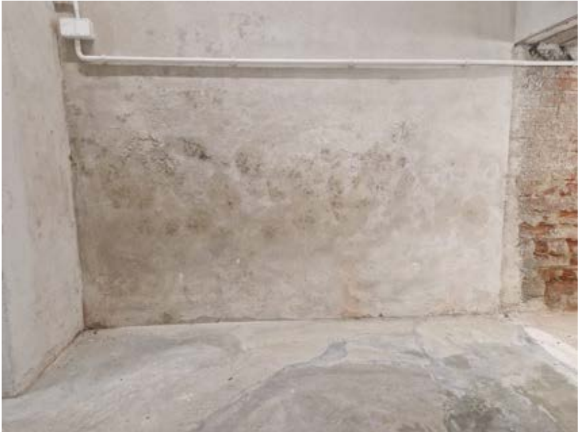
Fot. 16. Pomieszczenie w podpiwniczeniu fragmentu ryzalitu (pod spocznikiem schodów wewnętrznych) – silne zawilgocenia i ztuszczania tynków
