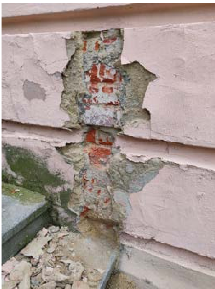
Fot. 24. Sposób osadzenia stopni granitowych w murze ryzalitu – na sztywno; boniowanie elewacji jako forma pierwotnego ukształtowania elewacji ryzalitu; brak zinwentaryzowania izolacji przeciwwilgociowych na analizowanych poziomach
