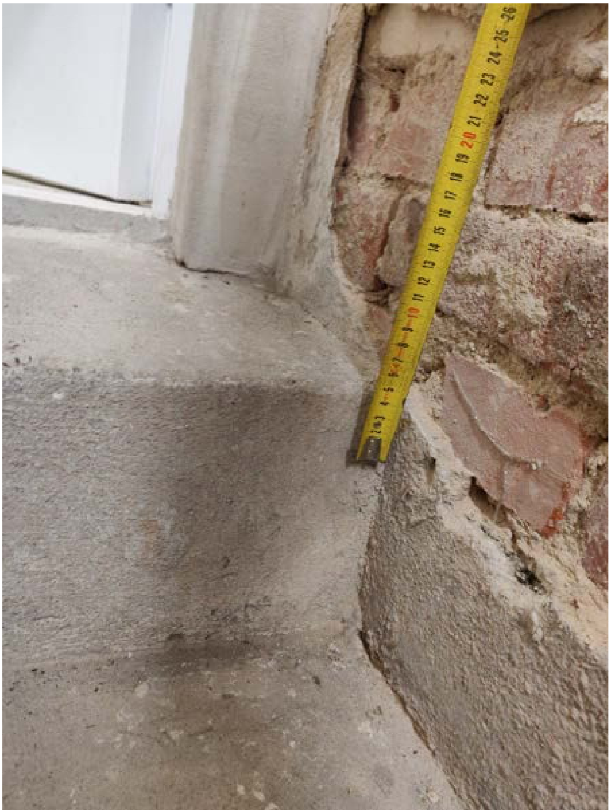
Fot. 36. Ściana wewnętrzna między częścią podpiwniczoną a pomieszczeniem świetlicowym na parterze, fragment widoczny od części podpiwniczonej ze schodów wewnętrznych – pod tynkiem w murze ceglany zinventoryzowano poziomą izolację przeciwwilgociową bitumiczną
