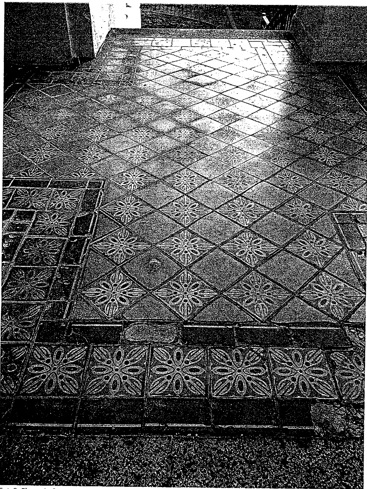
Fot. 2. Elewacja frontowa (zachodnia), fragment ryzalitu ze schodami wejściowymi – spocznik schodów z silnie zniszczonymi i odspojonymi okładzinami z płytek
