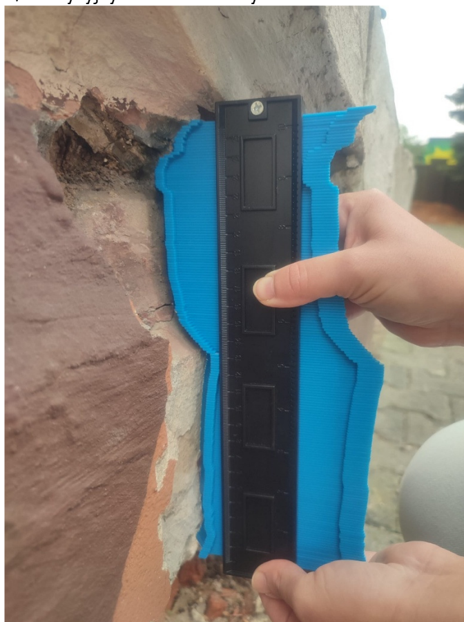
Fot. 2. Profilowanie pierwotnego cokotu murków bocznych schodów zewnętrznych, które należy odtworzyć wg szablonu do zinwentaryzowania na etapie prac
