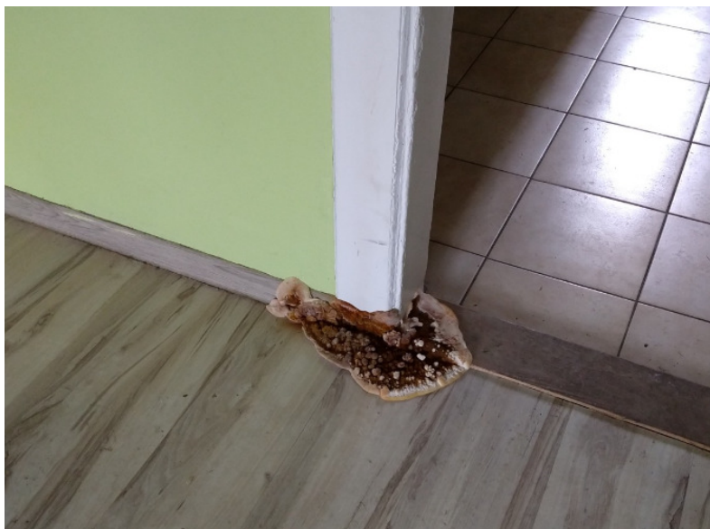
Fot.4 – powstałe zagrybienie na posadzce na gruncie
