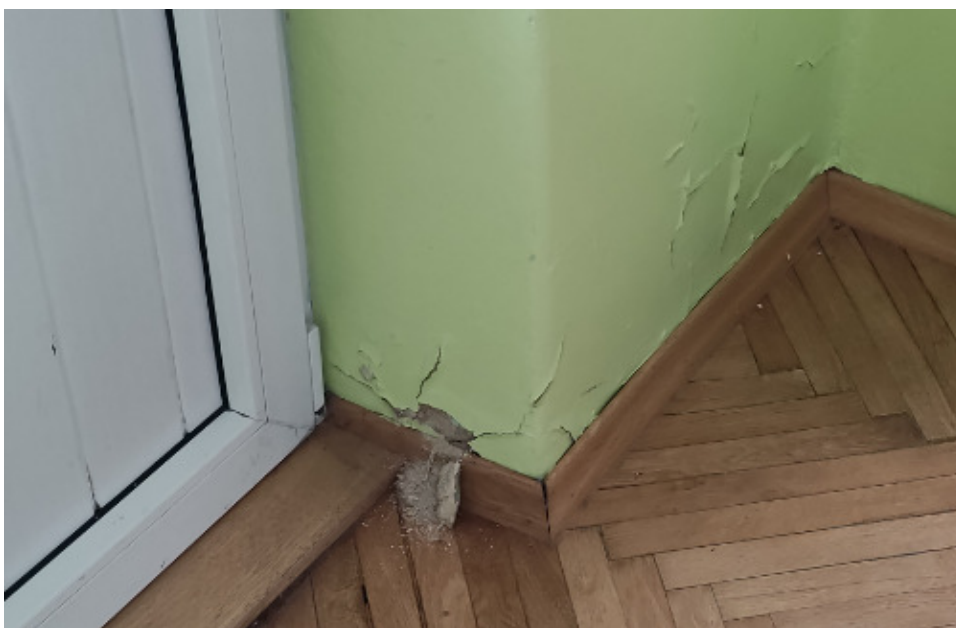
Fot.9 –zawilgocenia i odparzenia przy balkonie
