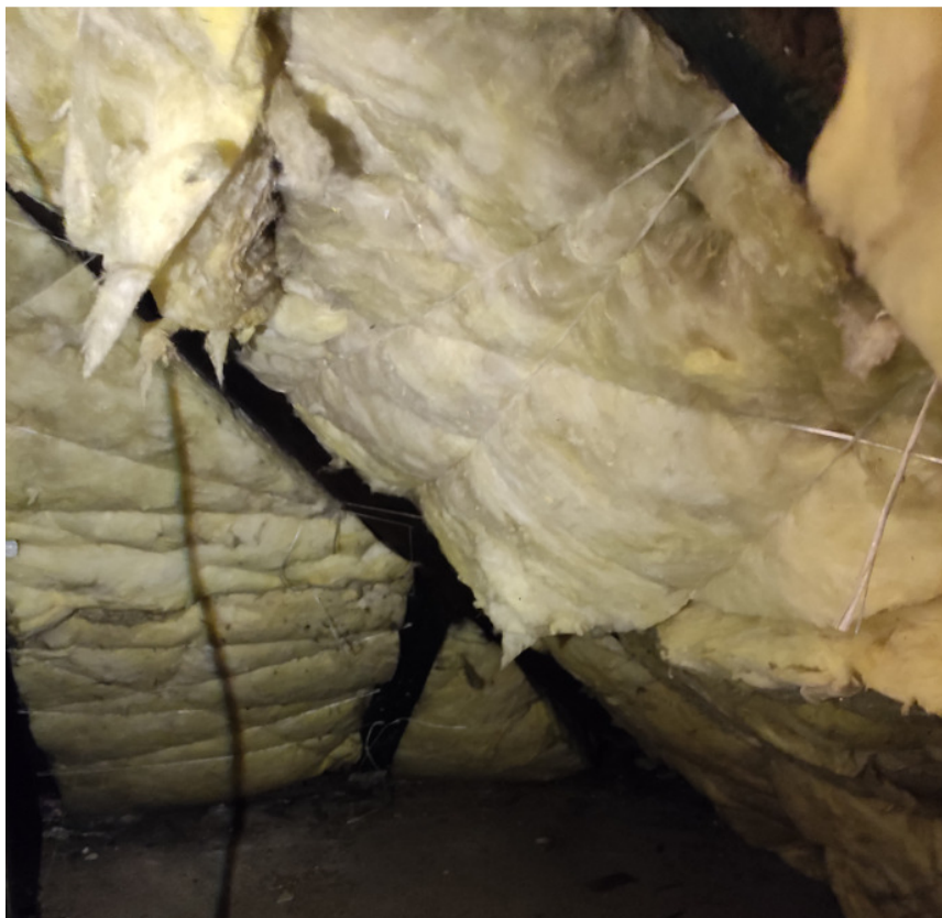
Fot.21 –docieplenie połaci dachu
