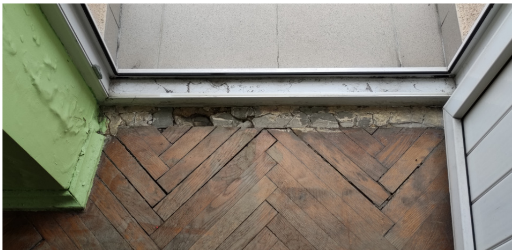
Fot.10 –niewłaściwe zaizolowanie elementów przy balkonie
