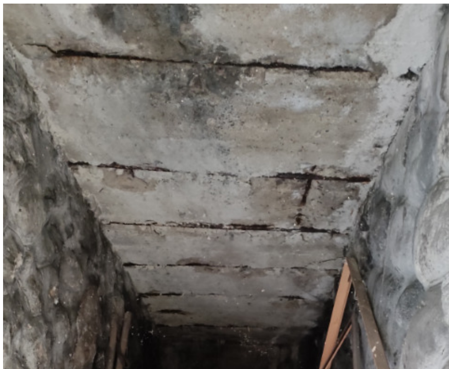
Fot.16 – ubytki betonu i korozja zbrojenia
