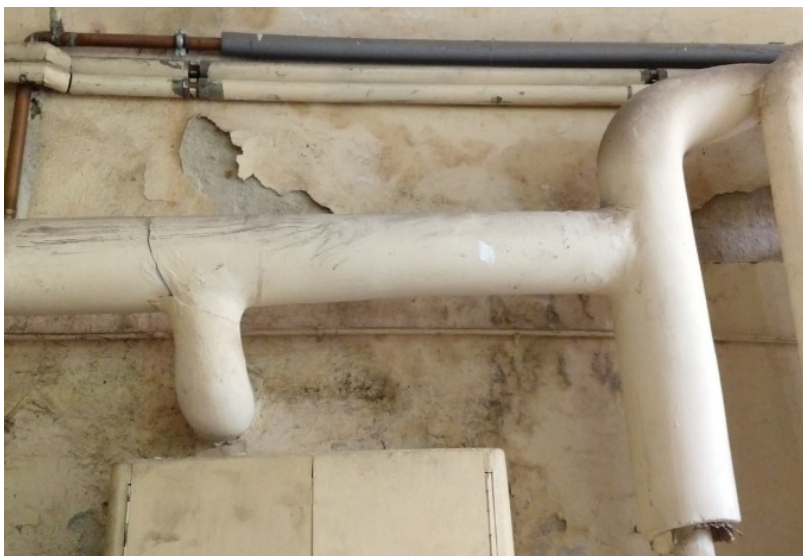
Fot.5 – powstałe zawilgocenie i odparzenia tynku w jednym z pomieszczeń
