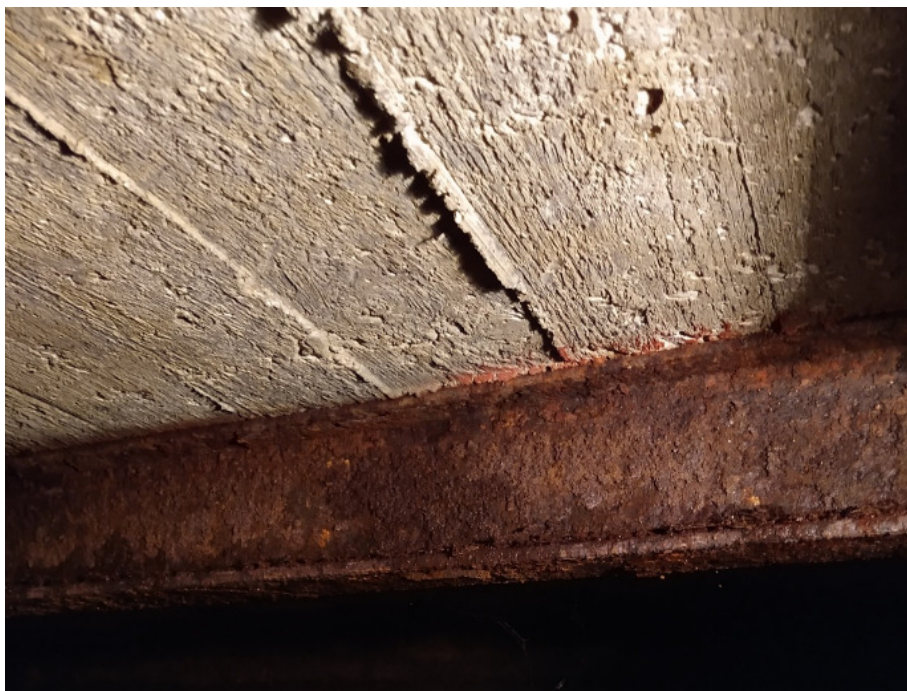
Fot.15 –skorodowane belki stropowe płyty nad składem węgla
