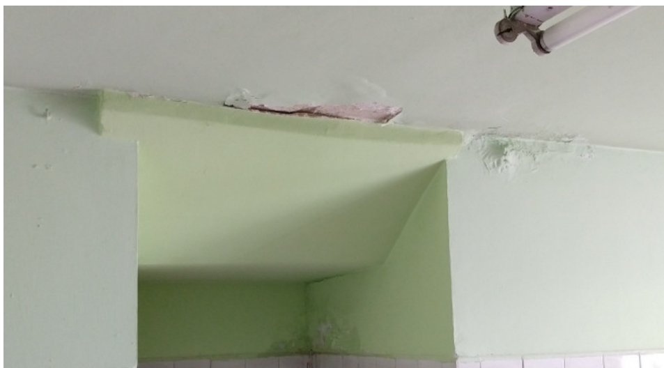
Fot.13 –zawilgocenia powstałe przy stropie
