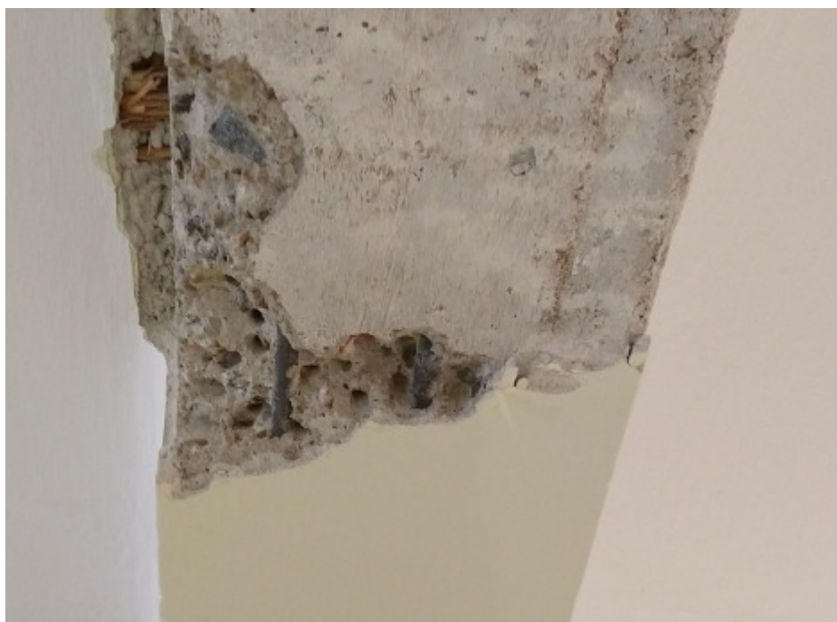
Fot.17 – odkrywka belki stropowej
