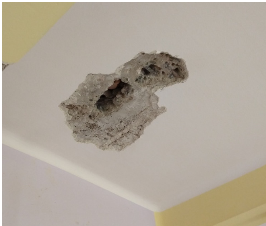
Fot.18 –odkrywka stropu
