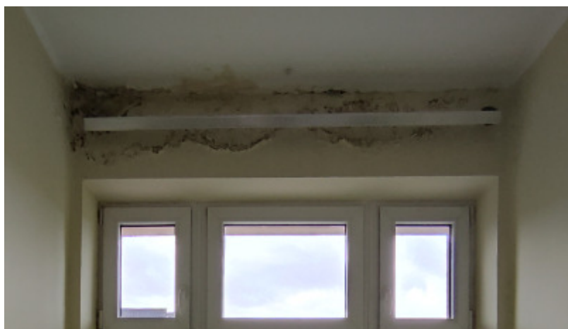
Fot.11 – zawilgocenia i odparzenia przy balkonie wyższej kondygnacji
