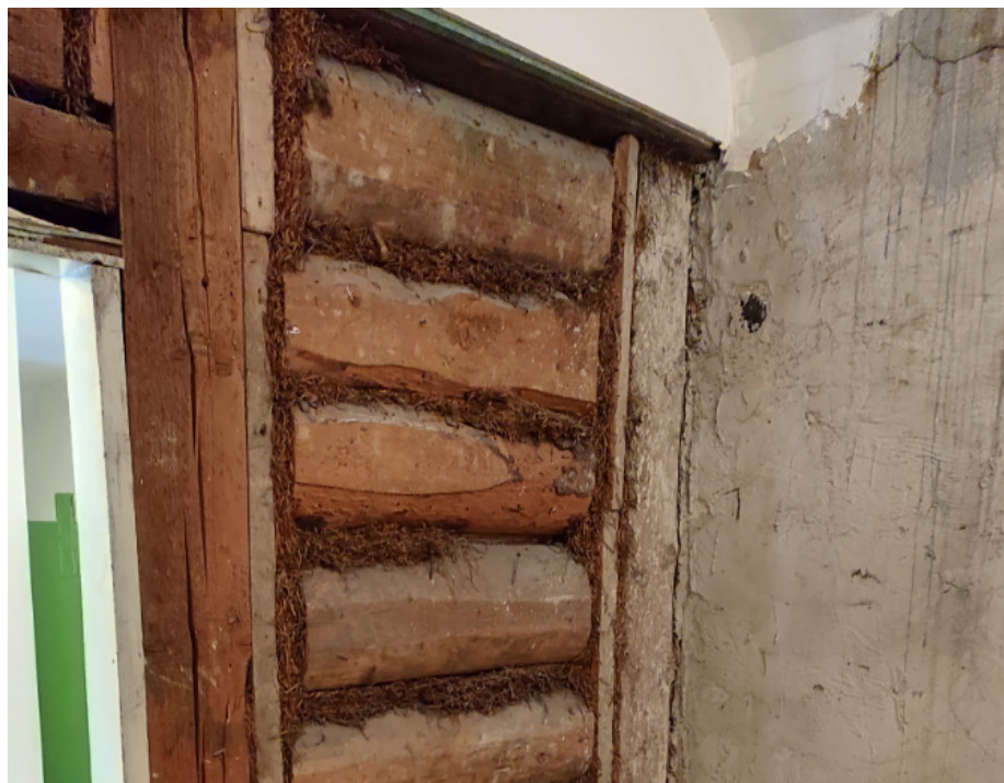
Fot.8 –ściany konstrukcyjne poddasza
