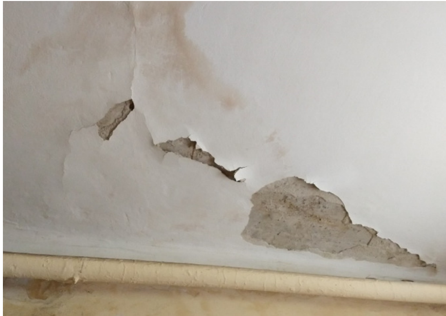
Fot.14 –zawilgocenia , odparzenia tynku
