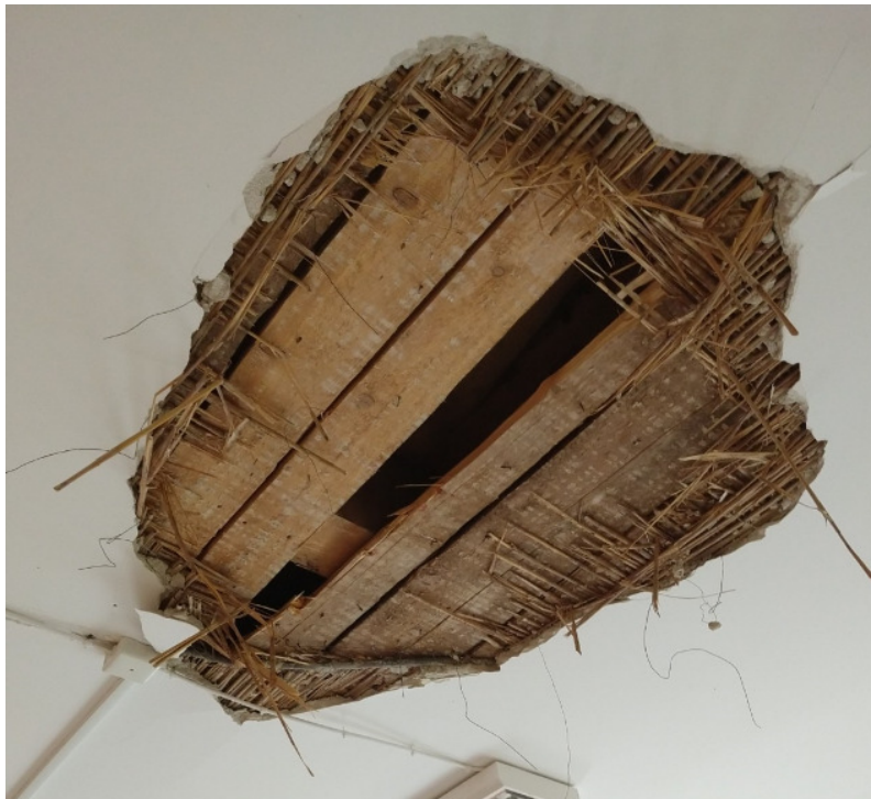
Fot.19—odkrywka stropu
