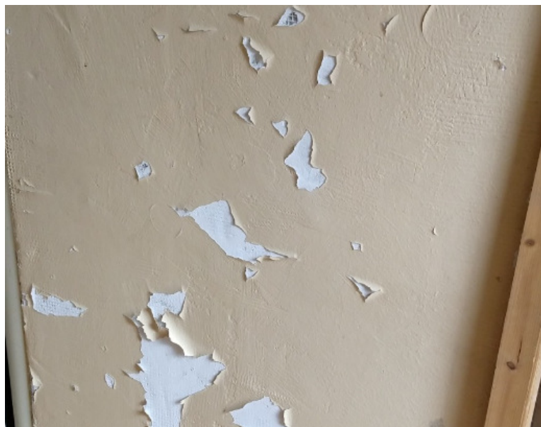
Fot.6 –odparzenia tynku w jednym z pomieszczeń
