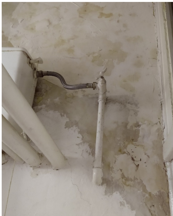
Fot.7 –silne zawilgocenia
