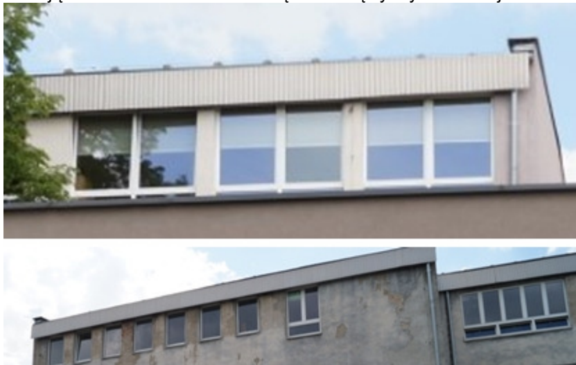
Fot. Osłona rynny dachowej
