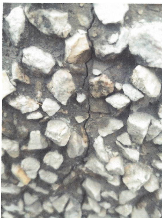
Fot. 4. Widoczne pęknięcia ściany osłonowej w jej warstwie zewnętrznej
