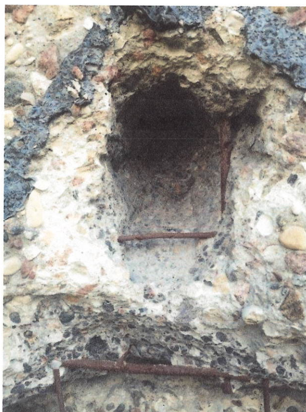
Fot. 8. Odkrywka potwierdzająca monolityczny charakter płyty elewacyjnej – z widocznymi korodującymi elementami zbrojenia bez otuliny.
