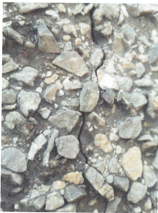
Fot 2. Widoczne pęknięcia ściany osłonowej w jej warstwie zewnętrznej
