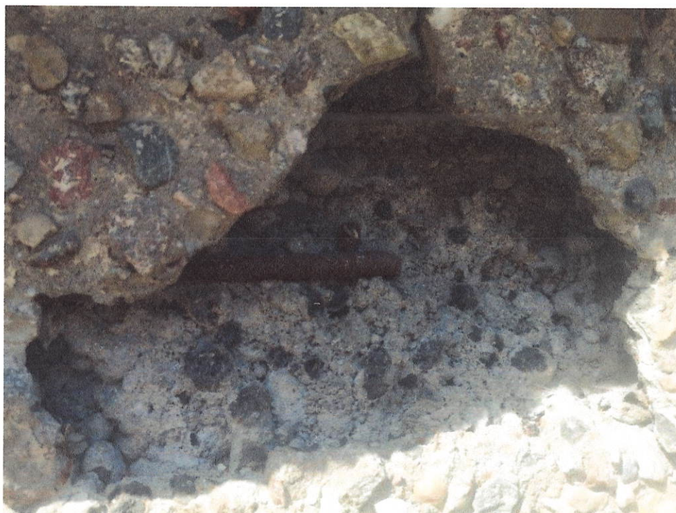
Fot. 6. Widoczne odsłonięte, korodujące zbrojenie na połączeniu warstwy zewnętrznej z monolitem ściany osłonowej – bez otuliny zbrojenia
