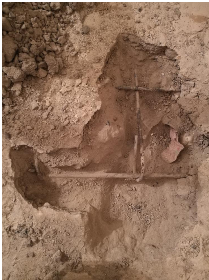
Zbrojenie górne żebra stropu skrzynkowego.
