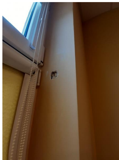
Fot. 5.9. Ubytek w ościeżu okiennym – pomieszczenie 308
