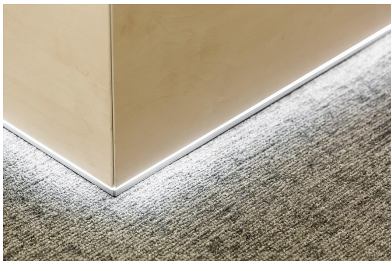
Rys: Oświetlenie LED wzdłuż całego frontu i z obu boków lady – sterowane jednym włącznikiem
