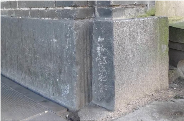
Fot. 35. Granitowe narożniki oraz lizeny z lastrico w pilastrach przejazdu.
