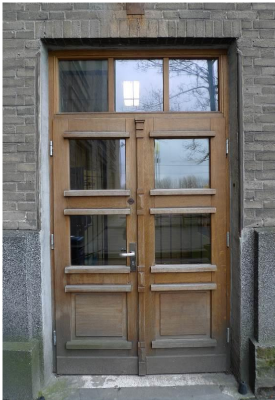
Fot. 69, 70. Historyczne, drewniane drzwi z wtórnym zastosowaniem współczesnego szkła zespolonego, stolarka osadzona w oryginalnym otworze z metalowymi okuciami, wejście od pn. do skrzydła zachodniego.
