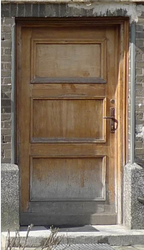
Fot. 59, 60, 61. Oryginalne otwory drzwiowe z metalowymi okuciami i kamiennymi stopniami, historyczna drewniana stolarka drzwiowa (fot. 59, 61), wtórne kraty, nieestetyczny, nietrwały współczesny daszek z poliwęglanu; elew. A/E8 (fot. 60), elew. A/E11 (fot. 59, 60).
