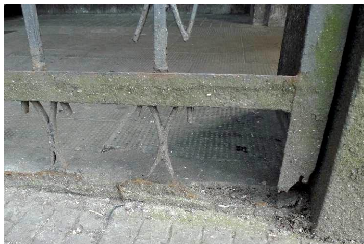
Fot. 32. Przerdzewiałe, pokryte glonami dolne elementy kraty przejazdu bramnego, wsch. arkada w elew. pn.
