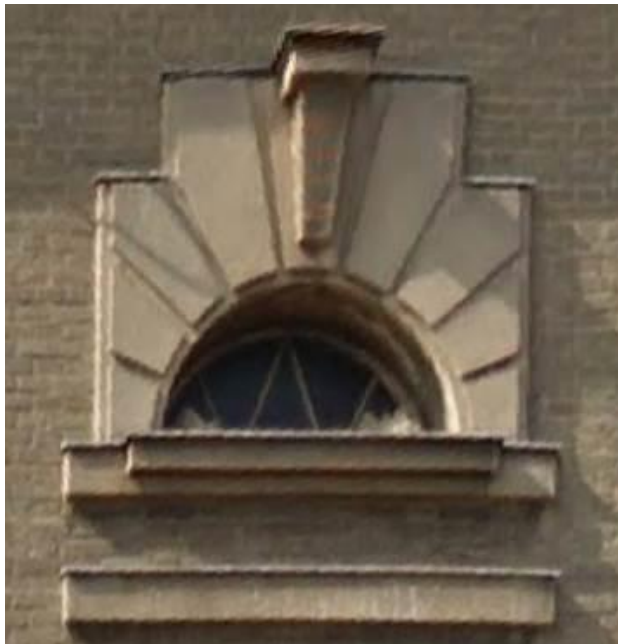
Fot. 16. Rustykalna schodkowa opaska półokrągłych okien, elew. A/E1.
