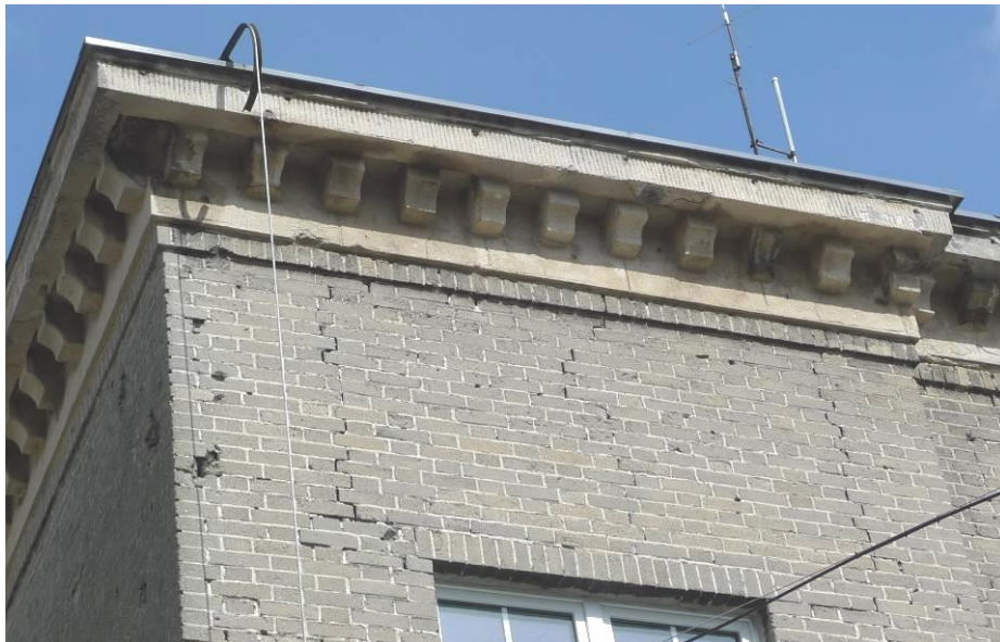
Fot. 50. Pęknięcia górnej północnej partii muru skrzydła zachodniego. Tylko wartwy okładziny?
