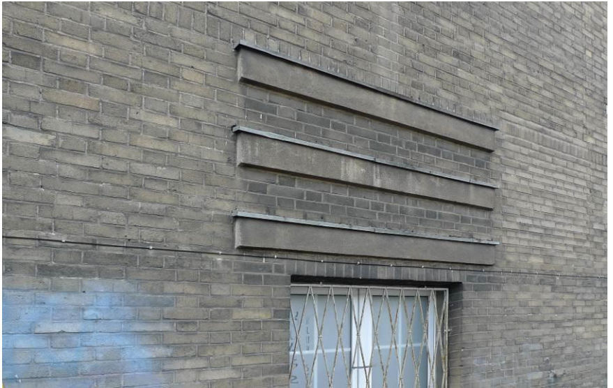
Fot. 22. Zabrudzona ścian, graffiti oraz zbędne opierzenie blacharskie na ozdobnych pasach ryzalitu elew. pn. gmachu głównego.
