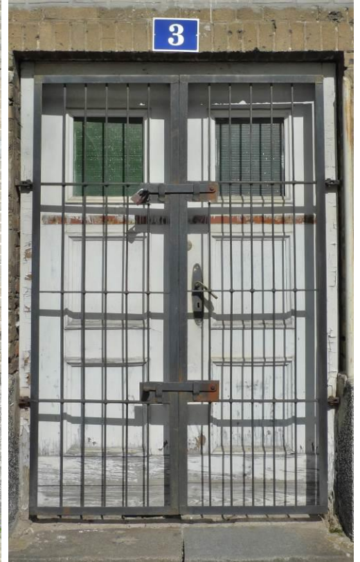
Fot. 59, 60, 61. Oryginalne otwory drzwiowe z metalowymi okuciami i kamiennymi stopniami, historyczna drewniana stolarka drzwiowa (fot. 59, 61), wtórne kraty, nieestetyczny, nietrwały współczesny daszek z poliwęglanu; elew. A/E8 (fot. 60), elew. A/E11 (fot. 59, 60).
