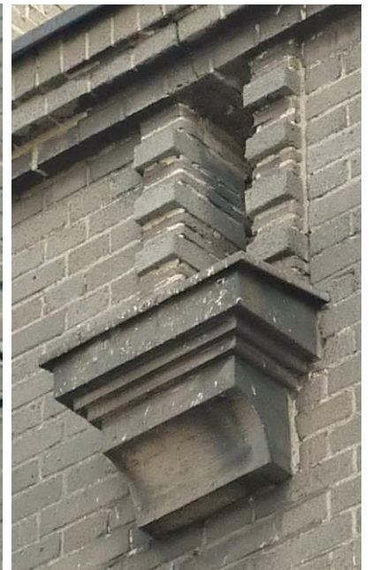
Fot. 18. Opaska szczelinowego otworu w attyce przejazdu elew. A/E14.
