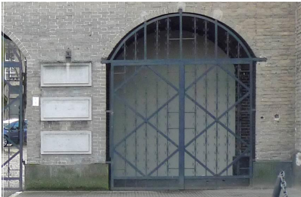
Fot. 27, 28. Zachodnia arkada przejazdu bramnego E z oryginalną kratą zamontowaną w dość prowizoryczny sposób, widok od północy i od południa.
