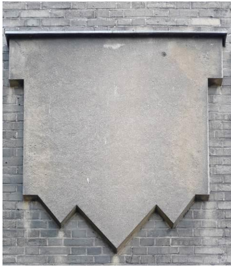
Fot. 15 a. Detal z tynku w kształcie dużego proporca, elew. pn. skrzydła zachodniego A/E3.
