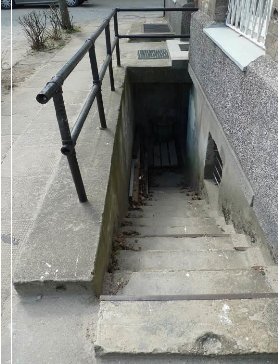
Fot. 53. Zawilgocone partie muru zejście do kondygnacji podziemnej przy wsch. ścianie skrzydła południowego.
