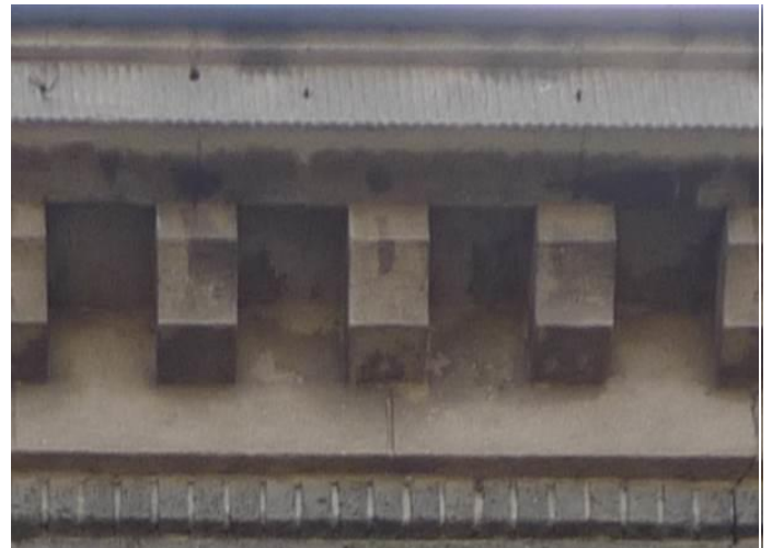
Fot. 20. Gzyms wieńczący z ryflowanym górnym pasem i ząbkowaniem.
