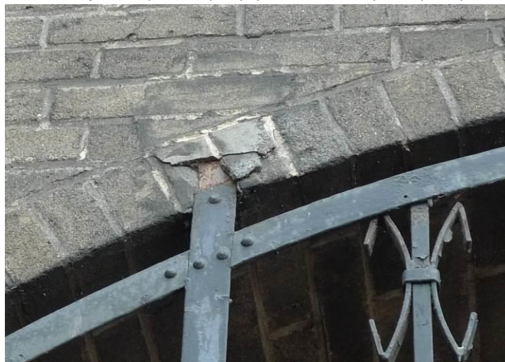
Fot. 29, 30. Uszkodzenia kitów zabezpieczających miejsca podcięcia cegieł w celu zamontowania (wtórnego ?) oryginalnych krat.; elew. pn. przejazdu między budynkami A i B, wsch. arkada.
