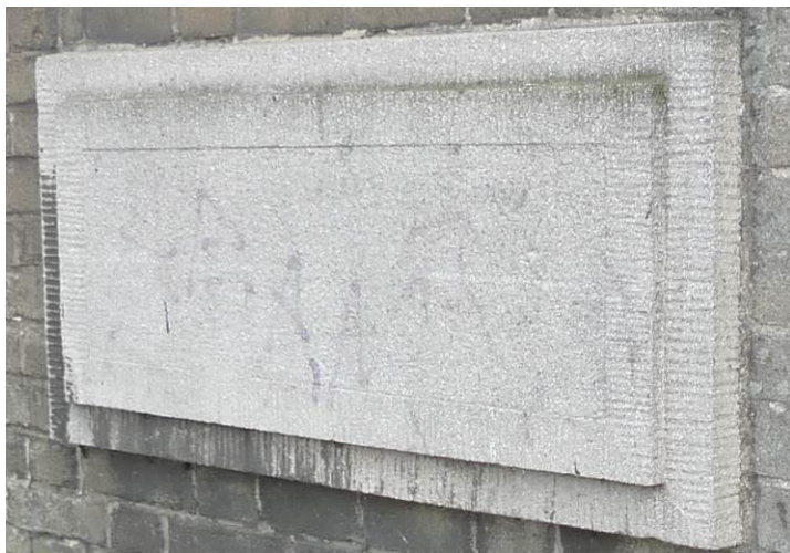
Fot. 19. Kaseton z lastrico na filarze przejazdu bramnego, elew. pn..
