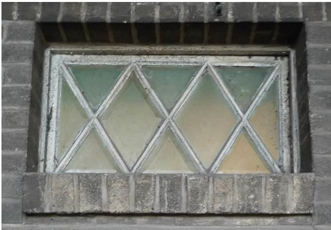
Fot. 78, 79. Oryginalne okno z diagonalnymi szprosami tworzącymi rąby, zastosowano szlifowane pryzmatycznie szkło, pn. ściana skrzydła zachodniego pod przejazdem bramnym, widok od zewnątrz – fot. 78. i od środka – fot. 79.
