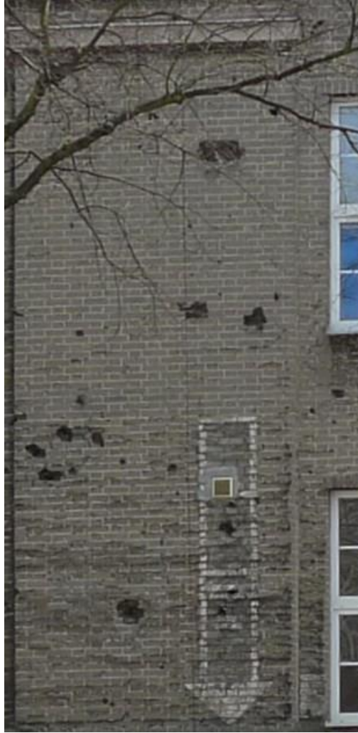
Fot. 47. Duże ubytki w murze po pociskach oraz malowane strzałki na elew. zach. skrzydła zach.
