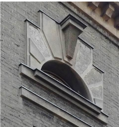
Fot. 24. Uszkodzone bonie (ich braki) wokół półkolistego okna ryzalitu pn. ściany budynku A1.
