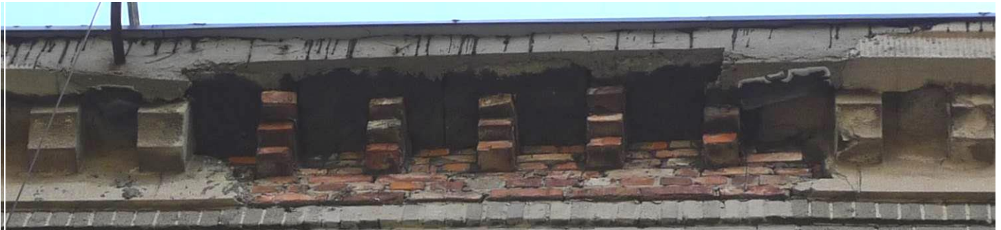
Fot. 41. Środkowa partia uszkodzonego gzymsu wieńczącego skrzydło zachodnie, elew. zachodnia..
