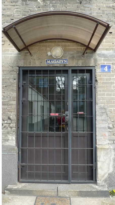
Fot. 59, 60, 61. Oryginalne otwory drzwiowe z metalowymi okuciami i kamiennymi stopniami, historyczna drewniana stolarka drzwiowa (fot. 59, 61), wtórne kraty, nieestetyczny, nietrwały współczesny daszek z poliwęglanu; elew. A/E8 (fot. 60), elew. A/E11 (fot. 59, 60).
