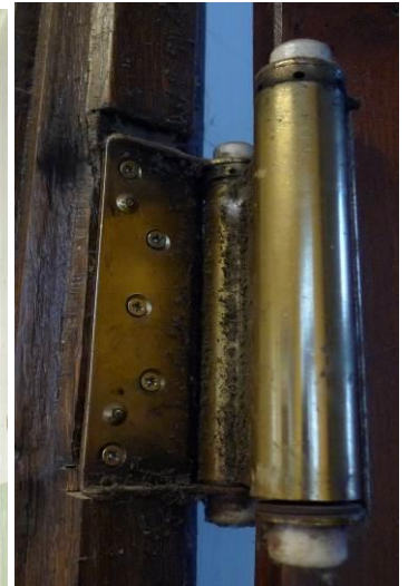
Fot. 67. Zawias wahadłowy drzwi z fot. 65.
