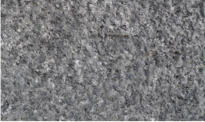
Fot. 33. Granitowe narożniki arkad przejazdu bramnego, wykończone groszkowaniem.
