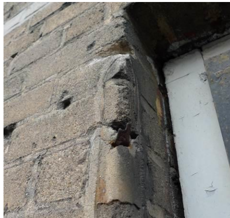
Fot. 76. Odcisk w zaprawie, ślad brakującego okucia drzwiowego, elew. A/E11.
