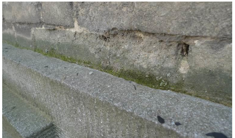
Fot. 43. Porosty w partii muru stykającego się z cokołem – spadek w kierunku lica muru (szkodliwe)
