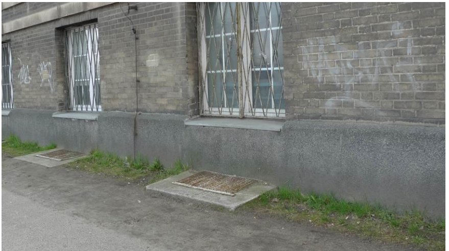
Fot. 23. Grunt stykający się z cokołem z lastrico, graffiti na ścianie elew. pn. gmachu głównego. Oryginalne kraty w oknach.
