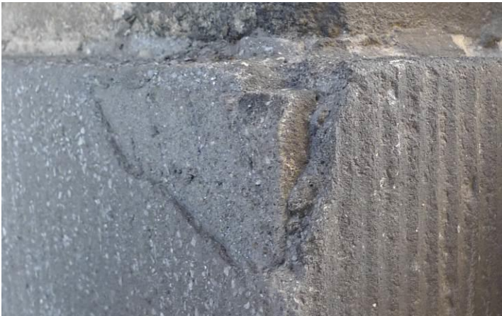
Fot. 36. Uszkodzenia narożników lizen z lastrico, powierzchnia ryflowana..
