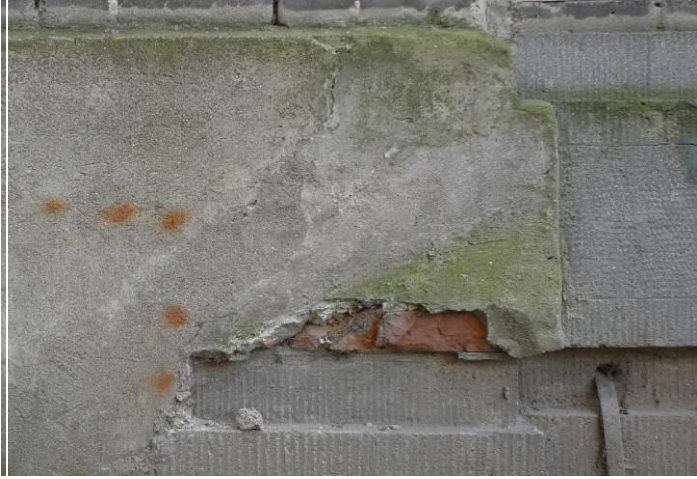
Fot. 39. Narzucona warstwa betonu na oryginalne ryflowane lastrico, wsch. pilaster elew. zach. skrzydła zachodniego.
