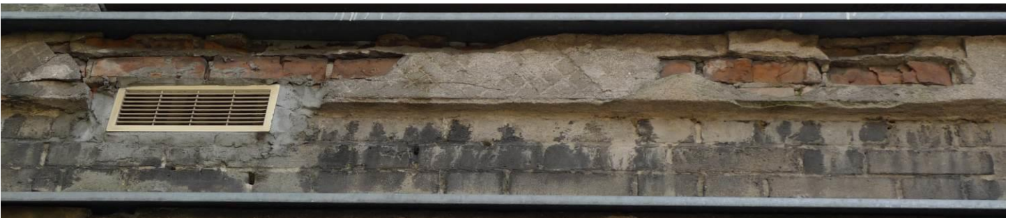
Fot. 38. Partie muru pozbawione tynku, zachowane fragmenty obrzutki z nacięciami ułatwiającymi nałożenie warstwy wykończeniowej. Nieestetyczna kratka wentylacyjna zaburzająca kompozycję. Wschodnia partia elewacji zach.. skrzydła zachodniego.
