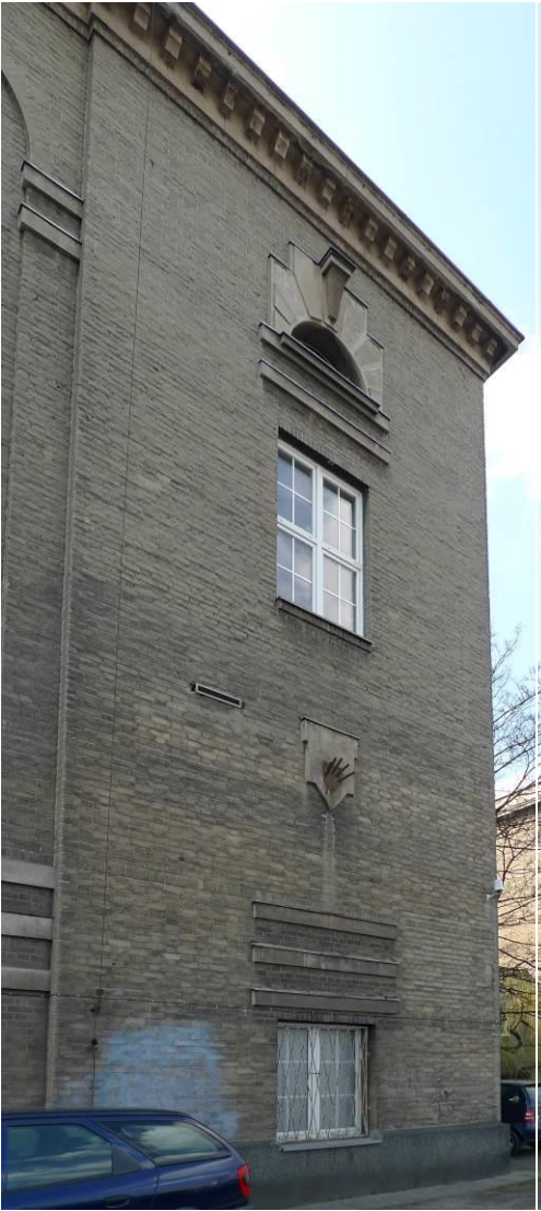
Fot. 21. Zawilgocona partia cokołu ściany zachodniej gmachu głównego.
