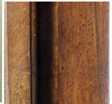
Fot. 68. Otwory po insektach w drzwiach z fot. 65.
