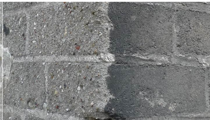
Fot. 44. Różnice w stopniu zachowania cegły okładzinowej, pd-zach. narożnik skrzydła zachodniego.
