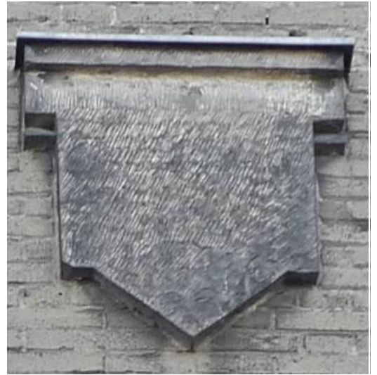
Fot. 15 b. Detal proporca z opracowaną fakturą tynku, elew. pn. gmachu głównego A/E1.
