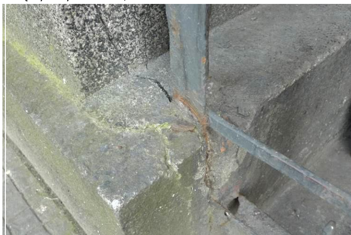
Fot. 31. Małostabilny, nieestetyczny, wtórny? sposób montażu kraty, Przejazdu bramnego, wsch. arkada w elew. pn.
