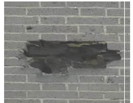
Fot. 49. Duże ubytki w murze po pociskach, czwarta lizena od zach., elew. zach. skrzydła zach..
