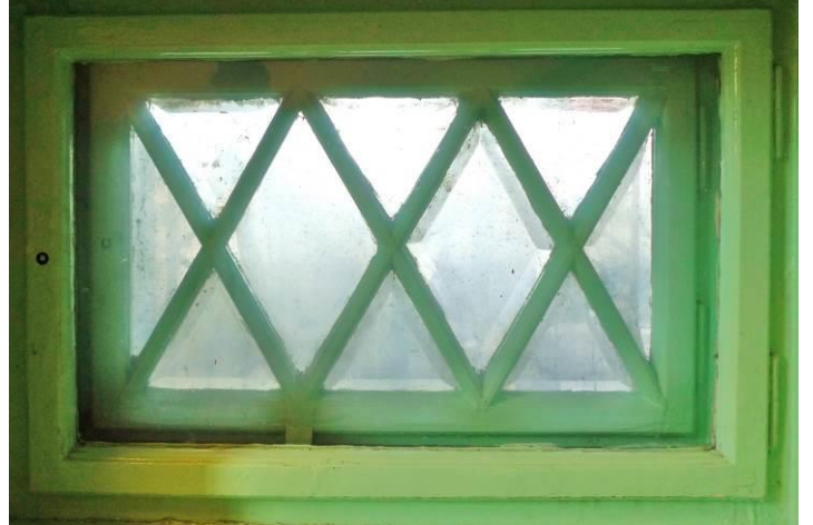
Fot. 78, 79. Oryginalne okno z diagonalnymi szprosami tworzącymi rąby, zastosowano szlifowane pryzmatycznie szkło, pn. ściana skrzydła zachodniego pod przejazdem bramnym, widok od zewnątrz – fot. 78. i od środka – fot. 79.
