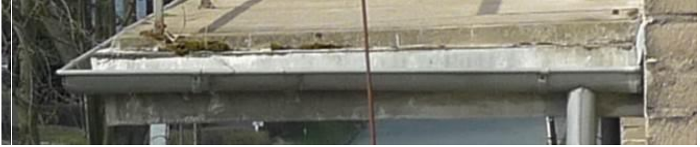
Fot. 52. Mchy porastające styk płyty balkonu z okapem, zacieki na podsufitce-nieprawidłowe zamontowanie obróbki blacharskiej, pd.ściana budynku A3.
