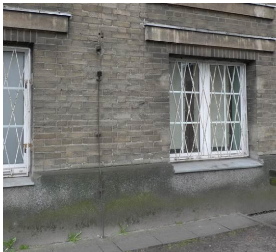
Fot. 25. Zawilgocony cokół z lastrico, płyty chodnikowe wzdłuż zacienionej zach. ściany budynku A1.
