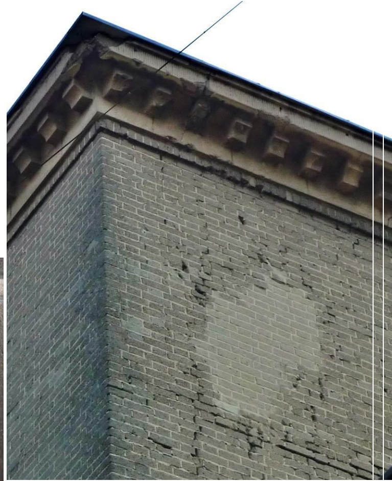
Fot. 37. Wypełniony zaprawą z wyrysowanymi spoinami ubytek muru powstały podczas wojny, uszkodzony gzyms, zach. ściana skrzydła zach.
