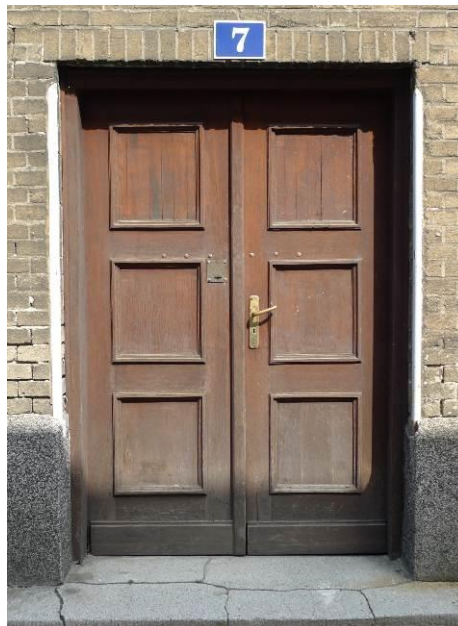
Fot. 57. Historyczna, drewniana stolarka drzwiowa w oryginalnym otworze okiennym (metalowe okucia otworu, pęknięty granitowy stopień), elew. A/E7.
