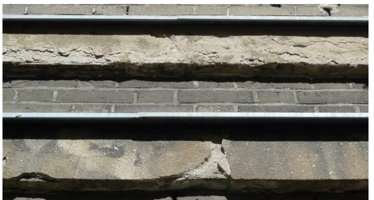
Fot. 45. Ubytki w oryginalnym tynku z miką fryzu skrzydła południowego, elew. pd..
