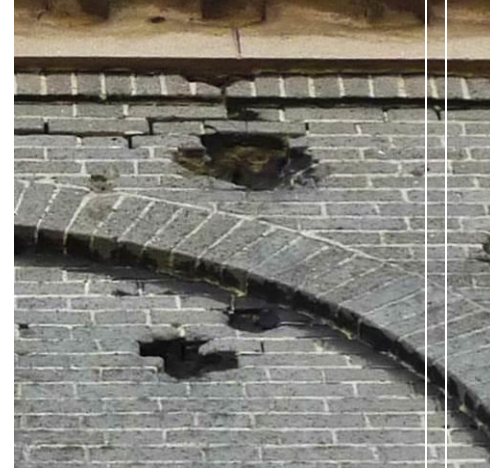
Fot. 48. Duże ubytki w murze po pociskach, pole arkady między trzecią i czwartą lizeną od zach. elew. zach. skrzydła zach.
