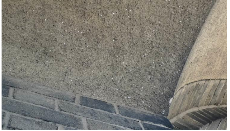
Fot. 34. Oryginalny tynk z miką ,podniebienie sklepienia przejazdu.
