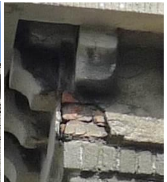
Fot. 51. Ubytki tynku belkowania pn-zach. narożnika skrzydła zachodniego, elew. zachodnia.
