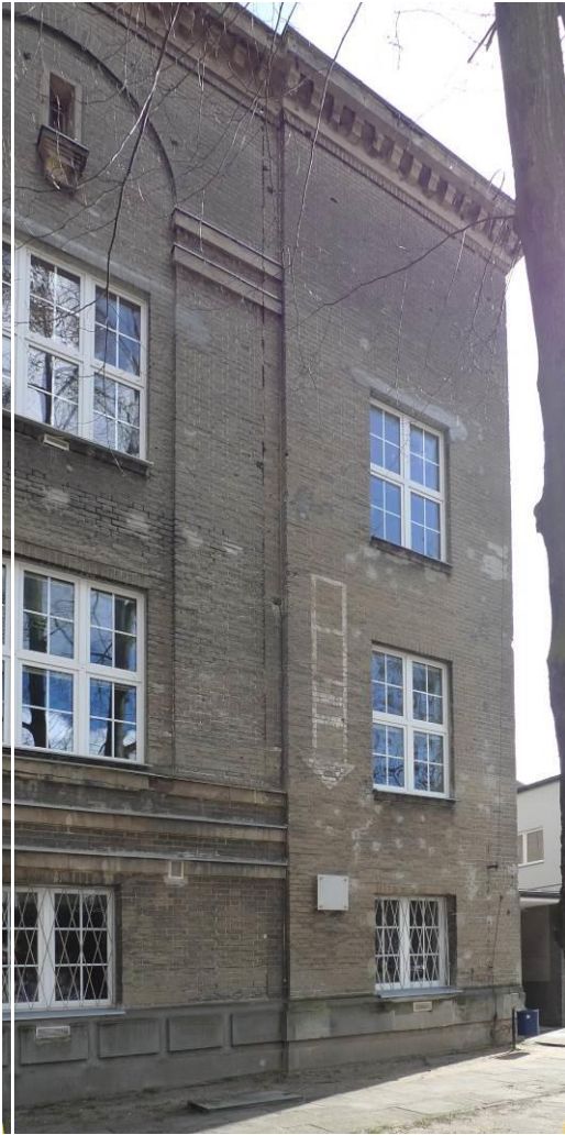
Fot. 46. Szczelina/brak przewiązania muru pfn. partii skrzydła zach., elew. zach.
