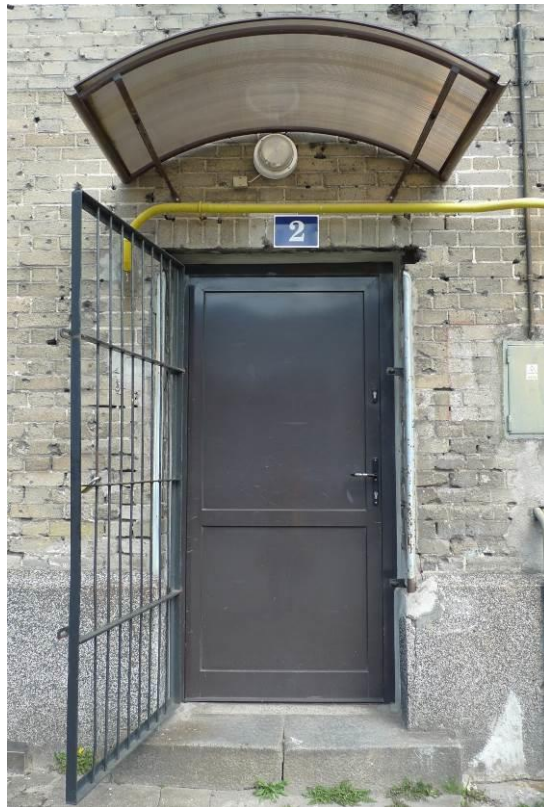
Fot. 63, 64. Oryginalne otwory drzwiowe z metalowymi okuciami i granitowymi stopniami, plastikowa, współczesna – fot. 61, drewniana, historyczna – fot. 62 stolarka drzwiowa, wtórne kraty, nieestetyczny, nietrwały, współczesny daszek z poliwęglanu; elew. pd. gmachu głównego
