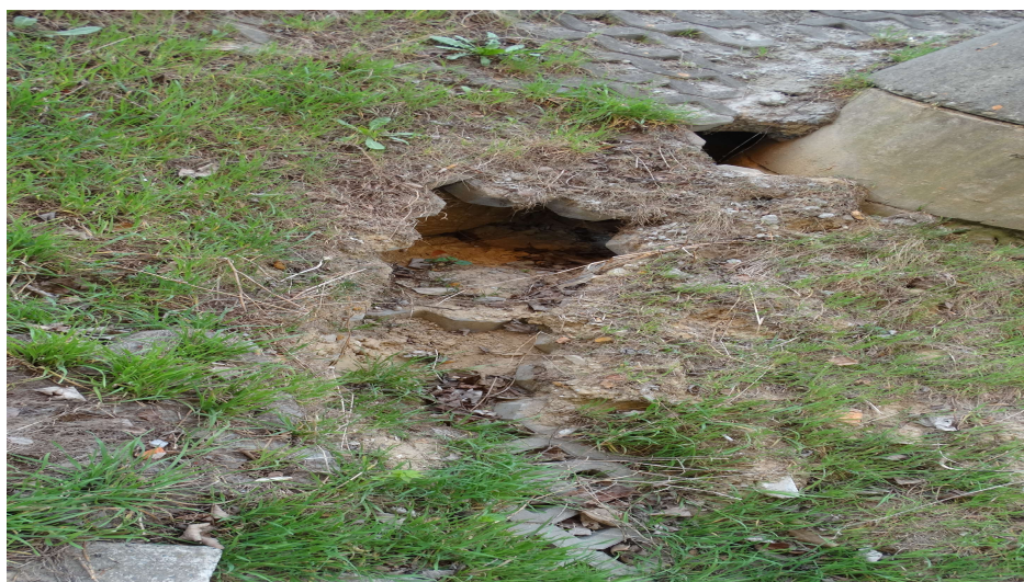
Wymycia erozyjne w skarpie
