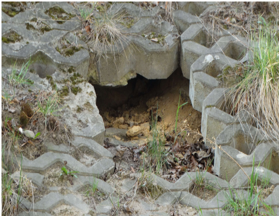
Wymycia erozyjne w skarpie
