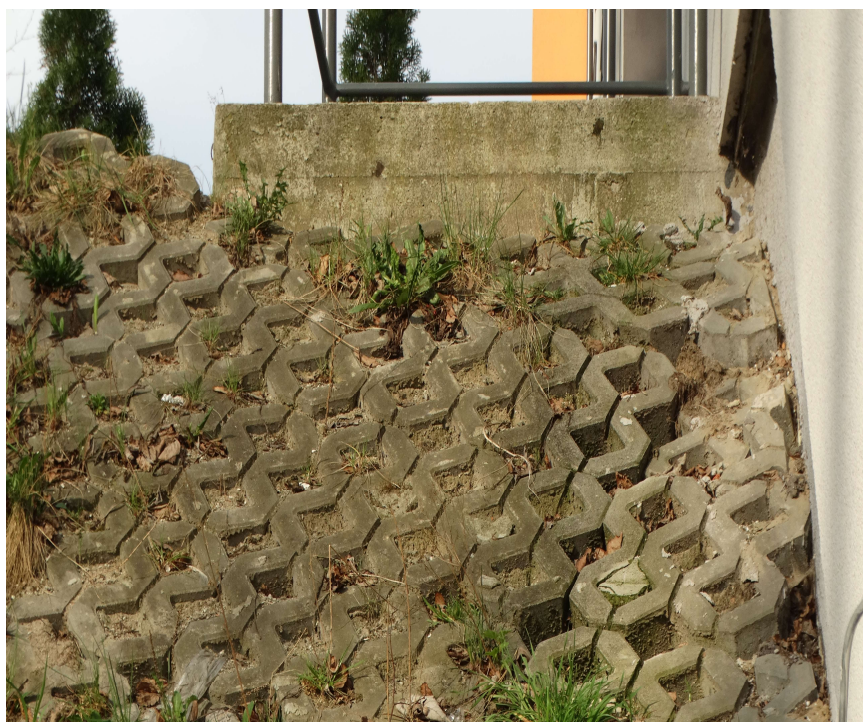
Wymycia erozyjne w skarpie
