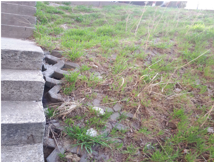
Wymycia erozyjne w skarpie
