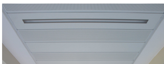
Sufit kasetonowy (dwa typy) z oświetleniem
