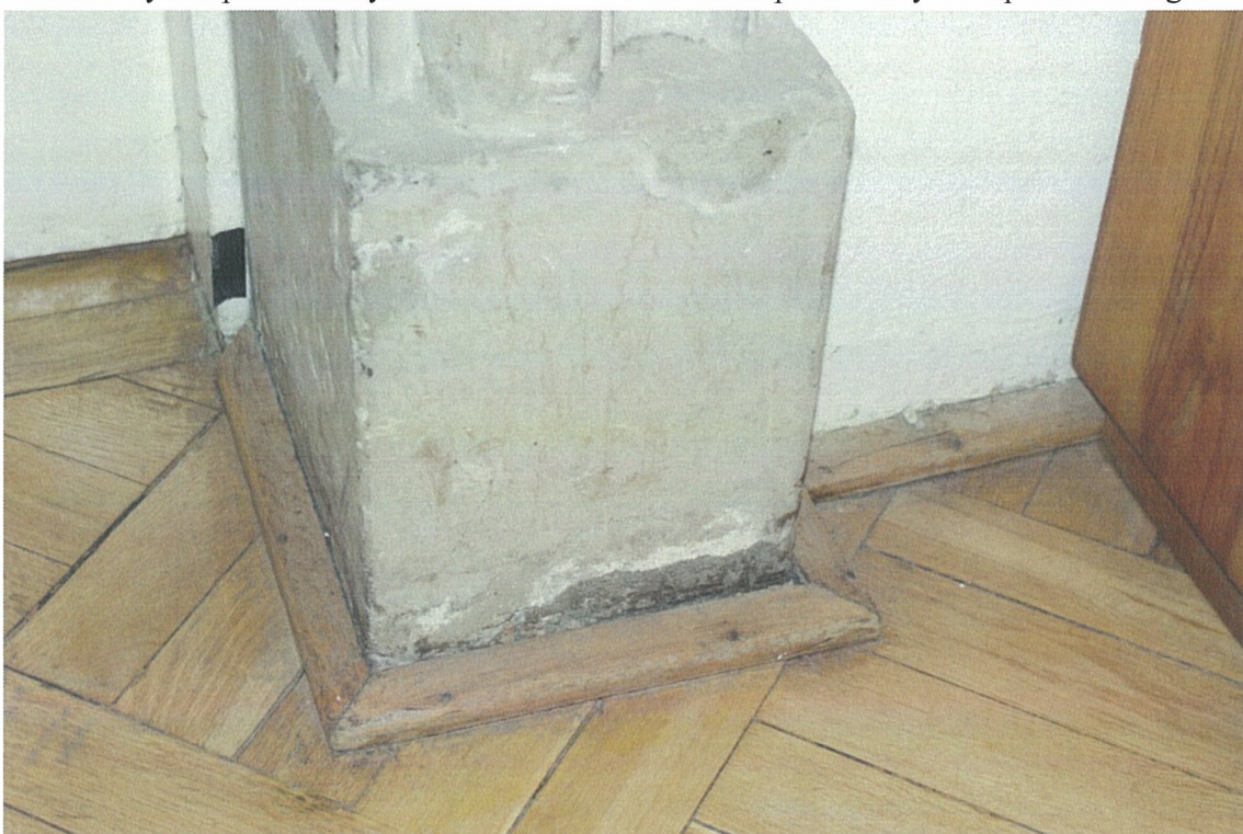
Fot.8. Korytarz południowy - widoczne uszkodzenia kostki obramienia drzwiowego.
