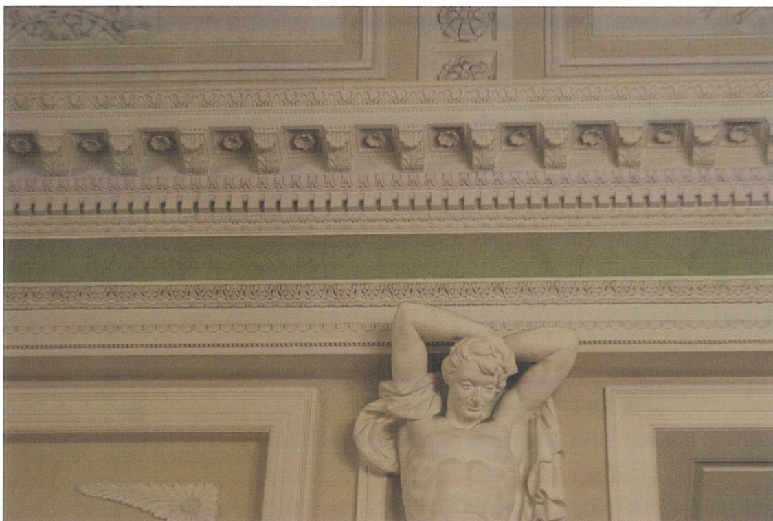
Fot.12. Stiukowy fryz – widoczne pęknięcia na skutek skurczu materiału.
