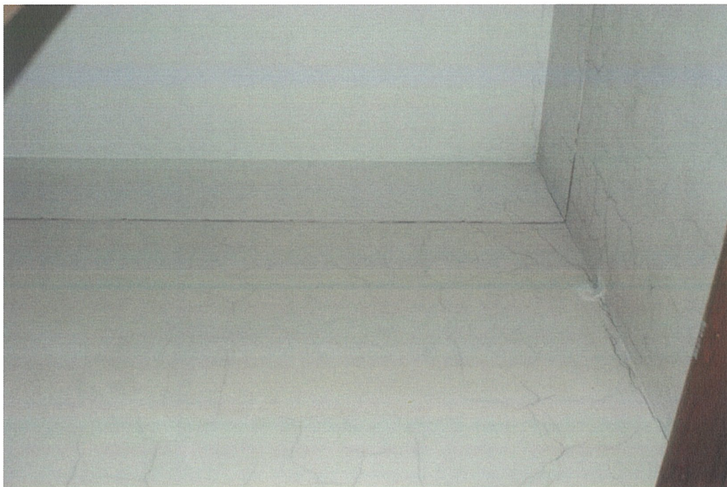
Fot.3. Pomieszczenie 122 – widoczne silne spękania i klwizowanie wypraw.
