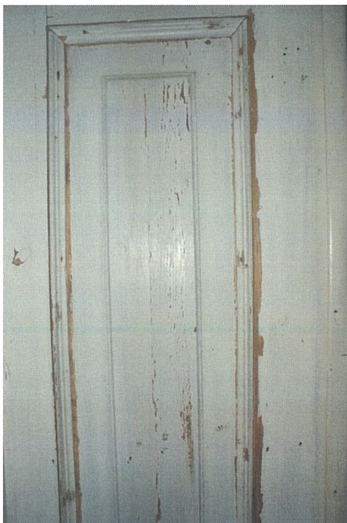
Fot.5,6. Stolarka drzwiowa – zbliżenie. Widoczne złuszczenia powłok malarskich.
