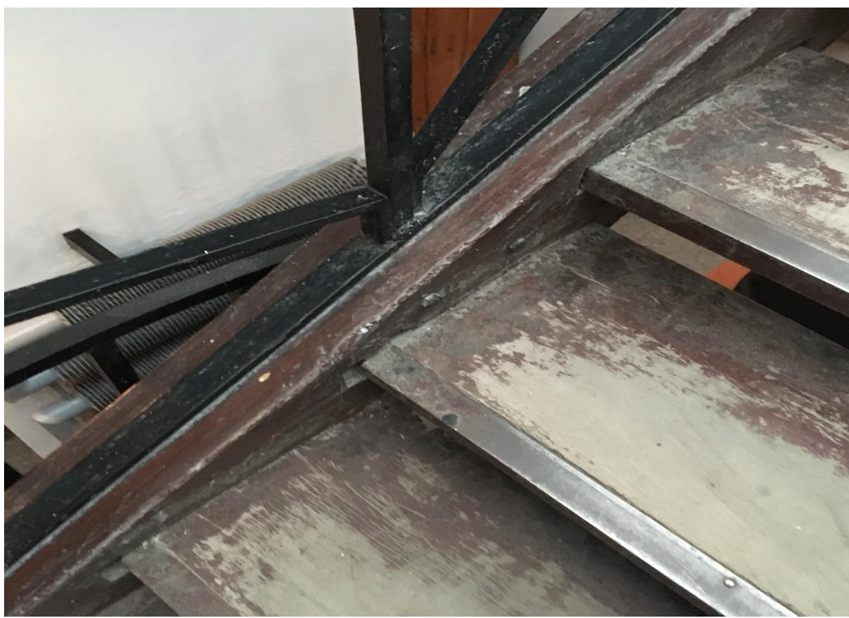
Fot. nr. 7 i 8, Muzeum Politechniki Krakowskiej, dawny areszt austriacki – wewnątrz. Stan przed konserwacją. Zbliżenie na część schodów. Widoczne zniszczenia drewna.
