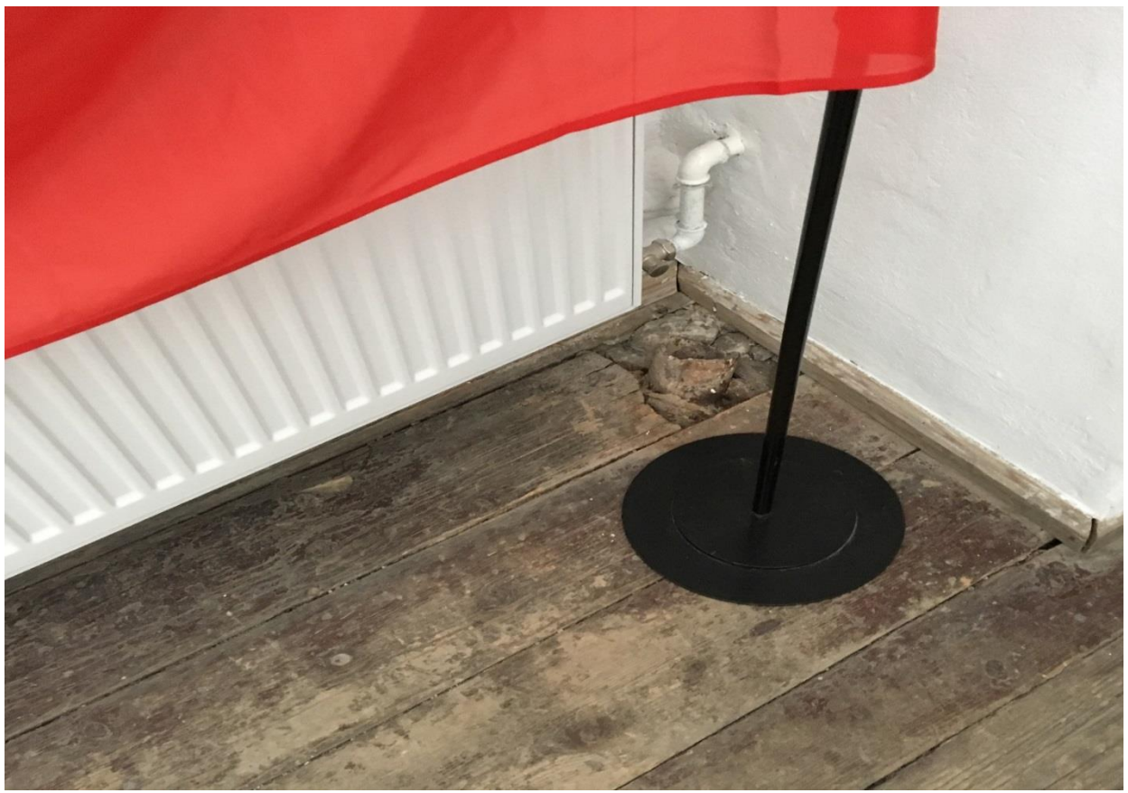
Fot. nr. 13 i 14, Muzeum Politechniki Krakowskiej, dawny areszt austriacki – wewnątrz. Stan przed konserwacją. Zbliżenie na część podłogi. Widoczne ubytki drewna.
