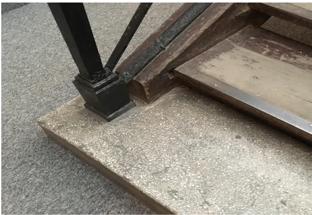
Fot. nr. 9 i 10, Muzeum Politechniki Krakowskiej, dawny areszt austriacki – wewnątrz. Stan przed konserwacją. Zbliżenie na część schodów. Widoczne ziszczenia drewna.
