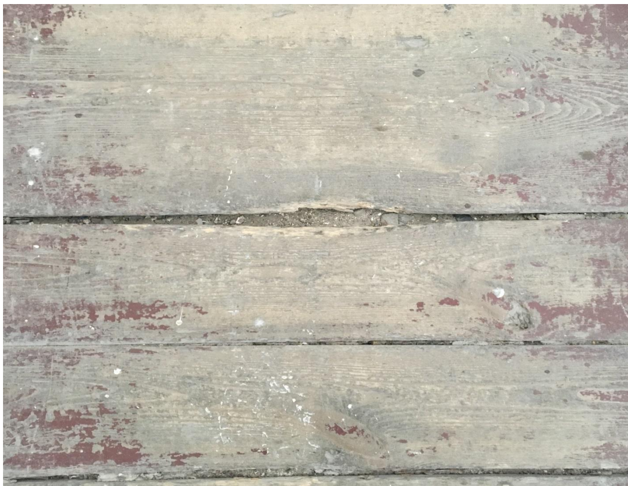
- widoczka destrukcja desek podłogowych spacerniaka
