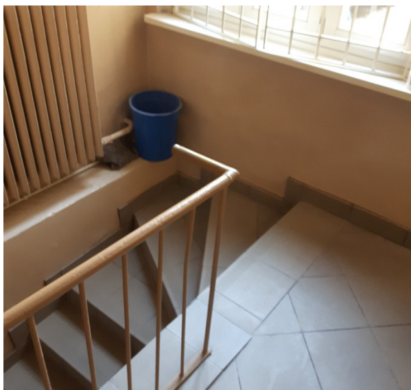
Fot. 1. Istniejąca balustrada stalowa prętowa przy zejściu do kotłowni w kondygnacji piwnicy
