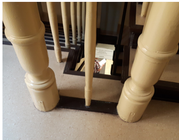
Fot. 2. i Fot. 3. Istniejąca balustrada drewniana klatki schodowej KS1 ze słupkami toczonymi drewnianymi, z mocowaniem wkrętami poprzez płaskowniki stalowe
