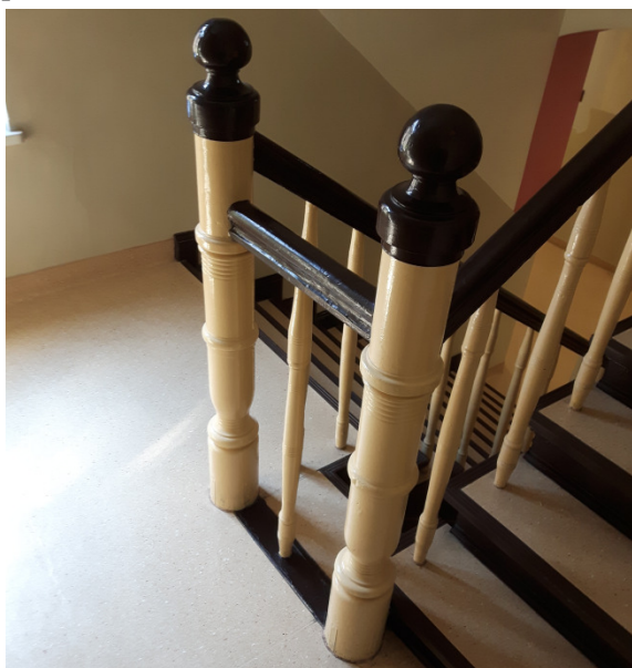
Fot. 2. i Fot. 3. Istniejąca balustrada drewniana klatki schodowej KS1 ze słupkami toczonymi drewnianymi, z mocowaniem wkrętami poprzez płaskowniki stalowe
