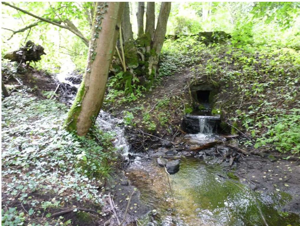
Fot. 2. Widok na zdekapitalizowaną zastawkę i przerwany groble stawu – zbiornik 3
