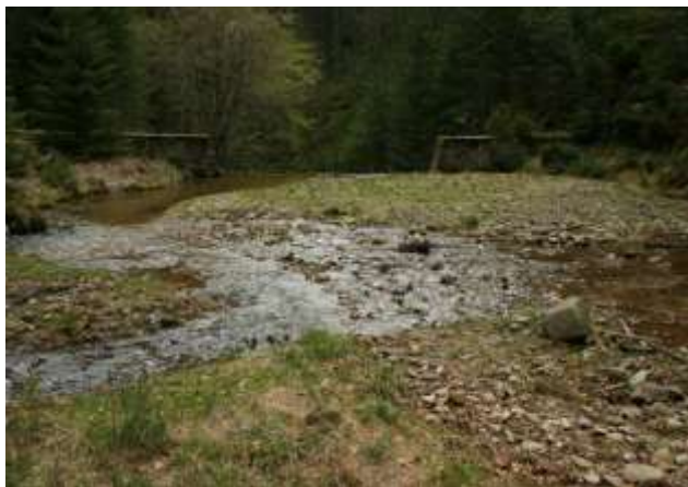
Rumosz różnych frakcji zalegający w czaszy różnych zapór – Nadleśnictwo Łądek Zdrój. Źródło: Archiwum CKPŚ.
