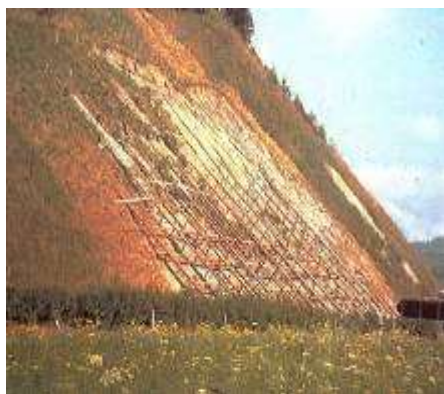
Drewniane rusztowanie na skarpie wzmocnione nasadzeniami wierzbowymi (Begemann i Schiechl 1999)
