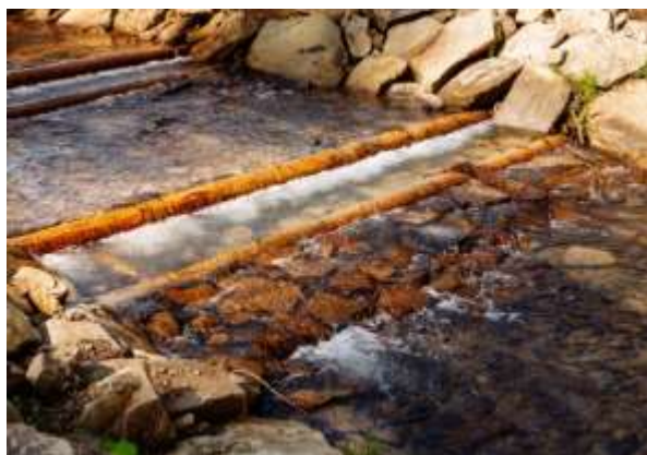
Gurt zabezpieczający próg – gurt zabezpieczony narzutem kamiennym. – rozwiązanie podobne do rys na rycinie a) Źródło: Archiwum CKPŚ
