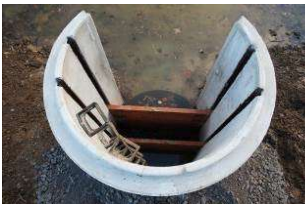
Studnia piętrząco-spustowa w trakcie budowy, widoczne kłamry zejściowe (fot. N-ctwo Lwówek Śląski i Szklarska Poręba)
