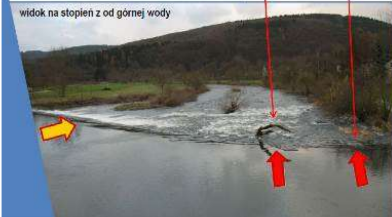
Bystrze dwuspadowe na stopniu poniżej mostu (Jelonek 2008)
