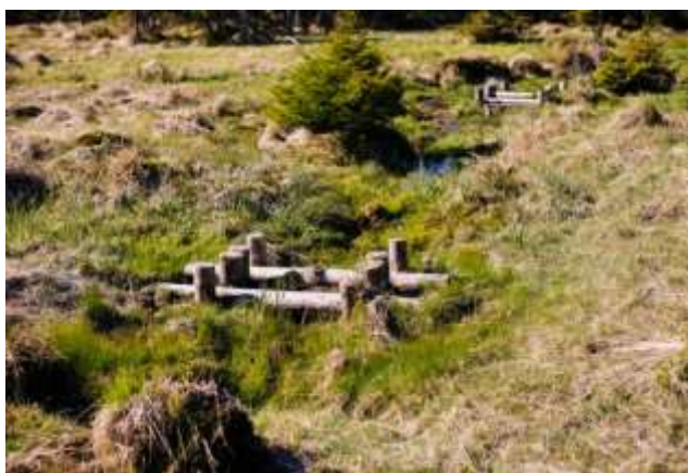
Zarastający rów odwadniający dzięki zastosowaniu przytamań ziemno-drewnianych – Nadleśnictwo Szklarska Poręba. Źródło: Archiwum CKPŚ
