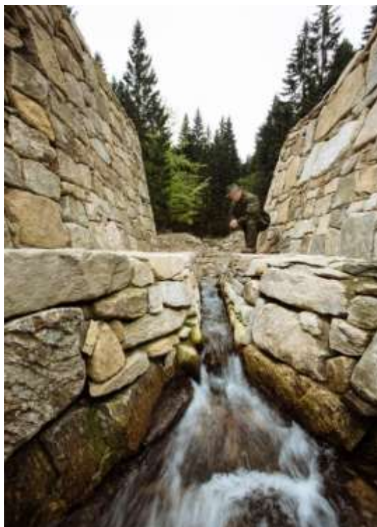
Widok na zaporę czołową dawnego zbiornika na cieku do spławu drewna przerobionego na zbiornik przeciwpowodziowy – Nadleśnictwo Międzyzlesie. Źródło: Archiwum CKPŚ. (rys. na górze)
