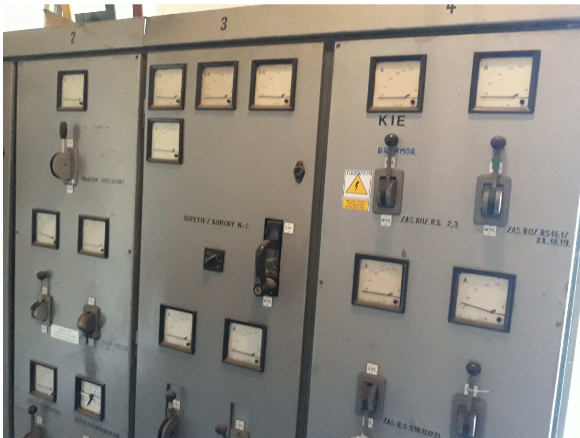
Fot.2 – widok elewacji istniejącej rozdzielnicy RG (pole nr 3 przeznaczone do zabudowy WG)
