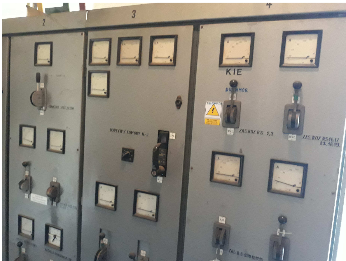
Fot.2 – widok elewacji istniejącej rozdzielni RG (pole nr 3 przeznaczone do zabudowy WG)
