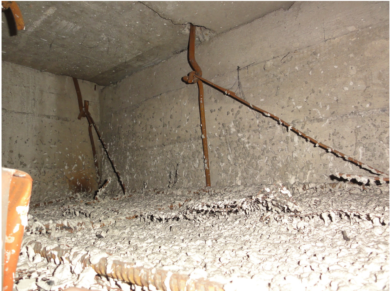
Fot.4. Widok konstrukcji sufitu podwieszanego i stropu międzypiętrowego żelbetowego z widocznymi płytami prefabrykowanymi i belką żelbetową.
