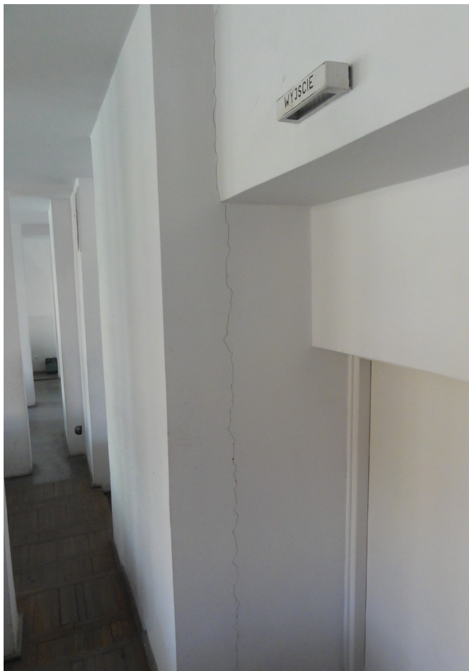
Fot.3. Widok zarysowania na styku ściany wypełniającej szkielet żelbetowy i ściany budynku głównego w miejscu przechodzącej dylatacji w sali nr 3.
