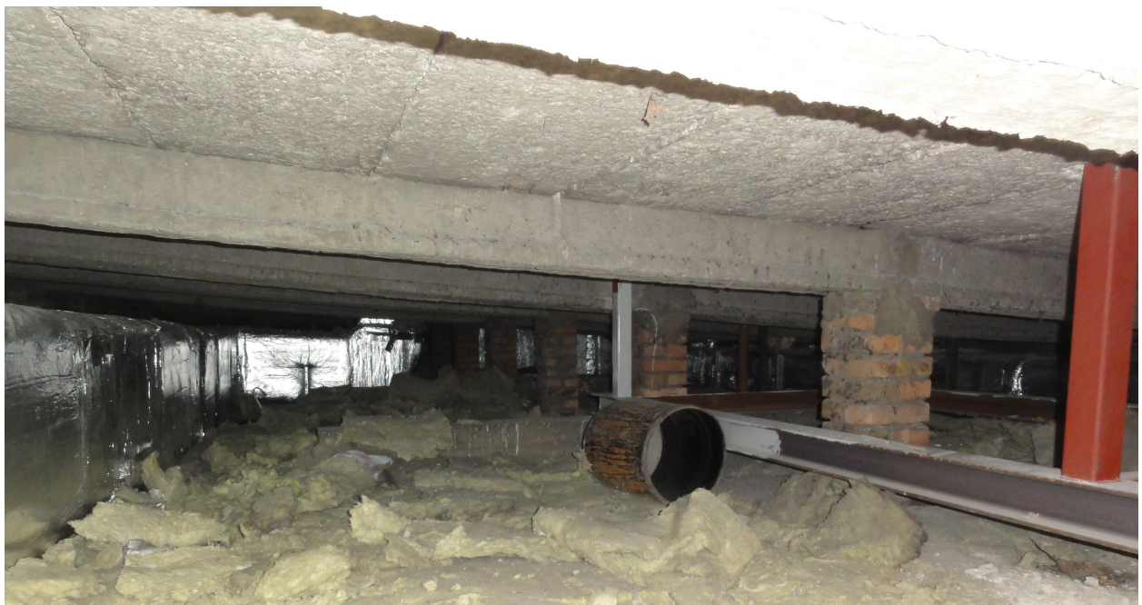
Fot.5. Widok konstrukcji stropodachu wentylowanego z widocznymi płytami i belkami DZ.
