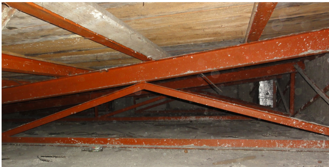
Fot.5. Widok konstrukcji stalowej podestu pod krzesła sali audytoryjnej nr 3
