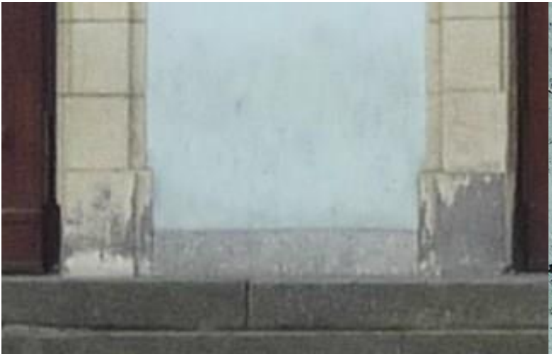
Fot. 32, 33. łuszcząca się na skutek wilgoci powłoka malarska w dolnych partiach ościeży drzwi głównych oraz portfenetr na tarasie – elew.pn. (B/E1).
