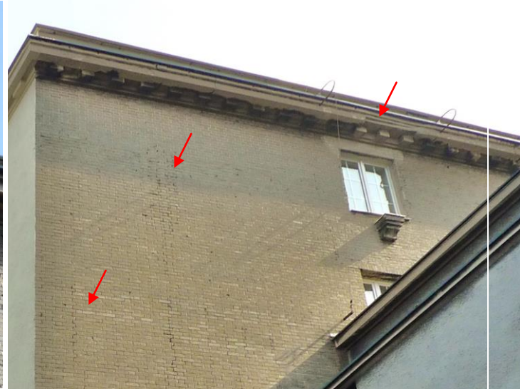
Fot. 18. Przemurowany fragment gzymsu nad oknem oraz jego nadproże, wypłukane spoiny w murze – elew. zach..
