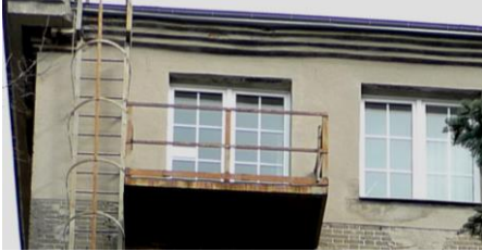
Fot. 22, 23. Nadbudowa piątej kondygnacji elew. pd.. Nieestetyczne opracowanie partii styku tynk i cegła; partia zach. i wsch.
