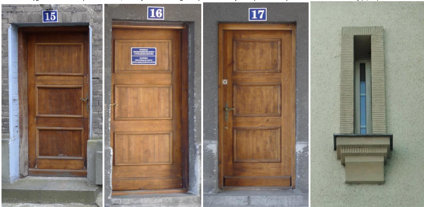
Fot. 39, 40, 41. Historyczne drzwi w oryginalnych otworach z granitowym stopniem, oraz oryginalnymi listwami narożnikowymi za przejazdem bramnym, elew. zach..
