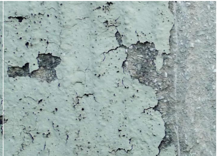
Fot. 32, 33. łuszcząca się na skutek wilgoci powłoka malarska w dolnych partiach ościeży drzwi głównych oraz portfenetr na tarasie – elew.pn. (B/E1).
