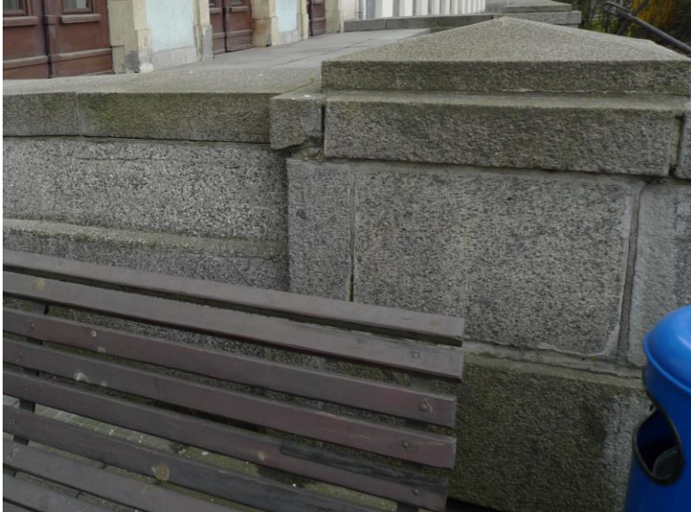
Fot. 30, 31. Balustrada schodów wejścia głównego z widocznymi śladami mikroflory i wypłukanymi spoinami – elew. pn.
