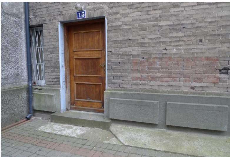
Fot. 34. Drzwi za przejazdem bramnym w elew. zach.. Oryginalne: granitowy stopień i cokół z lastrico porośnięte mikroflorą; cementowa opaska wokół budynku; ubytki w cegle i spoinach muru; pozostałości graffiti/wtórnego napisu informacyjnego; oryginalne listwy metalowe ościeży .
