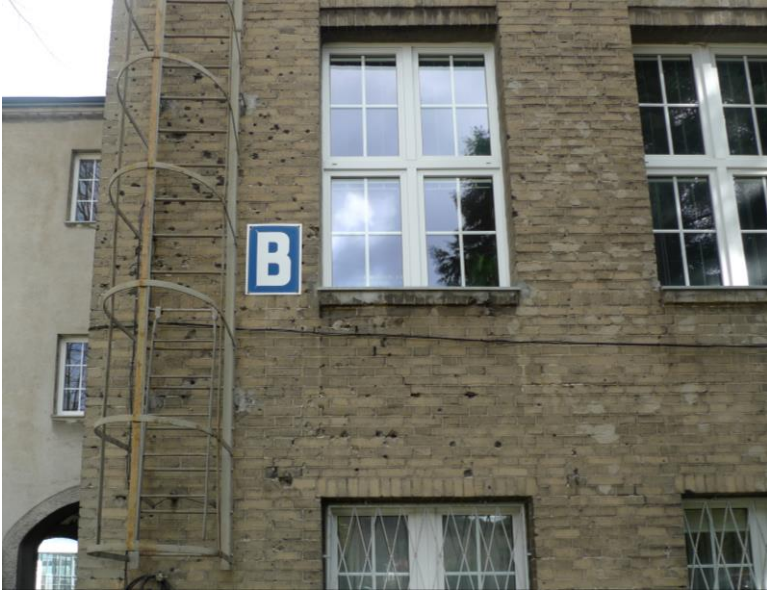
Fot. 24. Liczne drobne ubytki po pociskach w zach. partii elew. pd. (B/E3).
