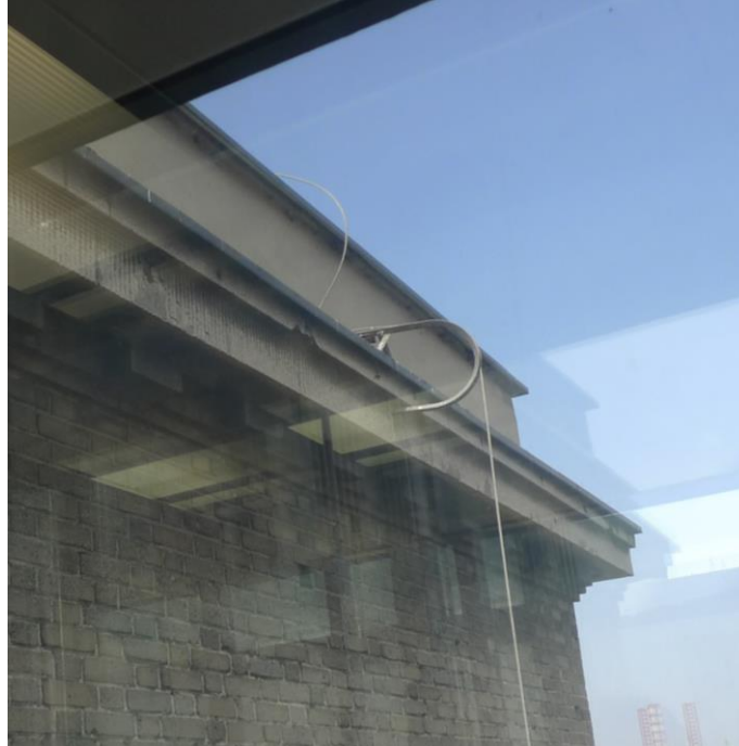
Fot. 20. Spoina między starym murem elew. wsch. a przemurowanym wejściem z szybu windowego na poziom ostatniej kondygnacji – widok z windy. Fot. 21. Pn. fragment gzymsu elew. wsch. z częściowo wypłukanym tynkiem – widok z windy.
