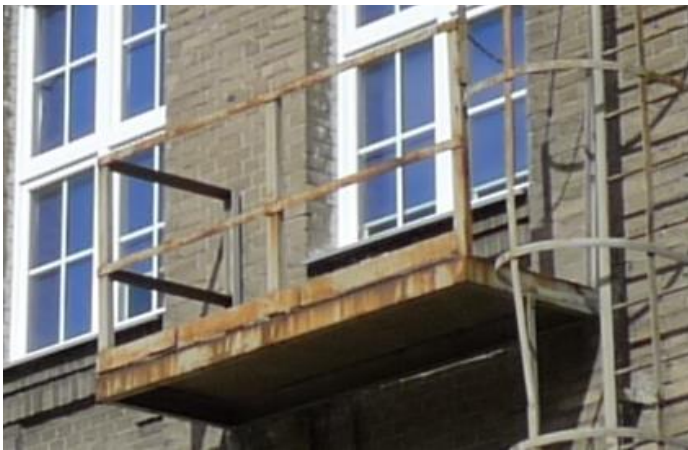
Fot. 26. Częściowo pokryty produktami korozji balkon – elew. pd.
