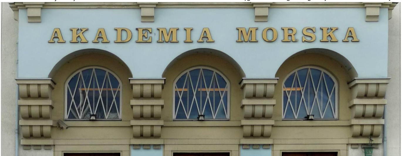
Fot. 12. Nadwieszne arkady nad wejściem głównym do budynku B. Oryginalne okna z diagonalnymi szprosami.
