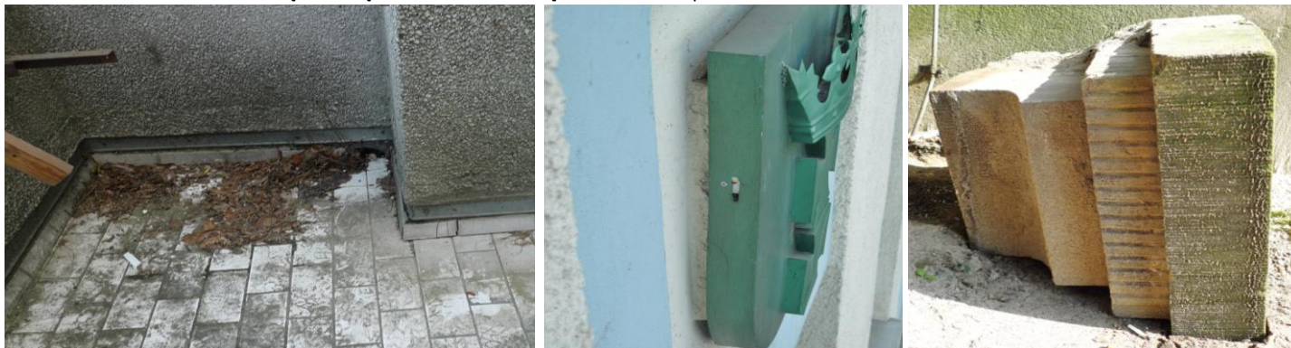
Fot. 43. Taras w elew. frontowej – źle wykonany spadek, zbyt wąskie światło otworu odprowadzenia wody, śmieci zatykające otwór.
