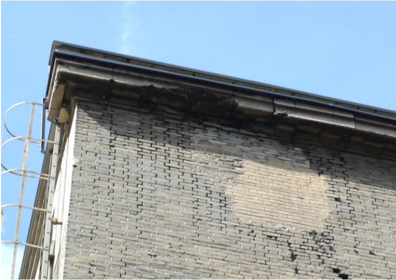
Fot. 17. Powojenne przemurowanie ściany w miejscu uszkodzenia jej przez pocisk w pd.-wsch. narożniku budynku. Ubytek w gzymsie do naprawy.
