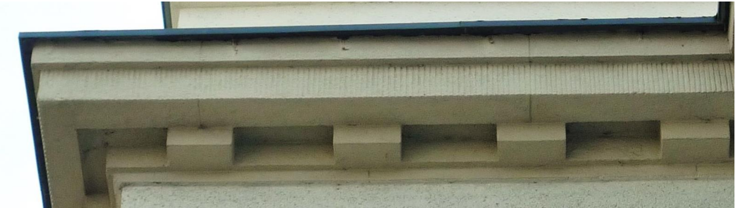
Fot. 19. Dobrze zachowany (pod warstwą wtórnej farby) gzyms w zach. partii części wschodniej elewacji północnej.
