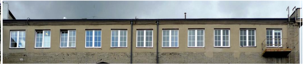
Fot. 22, 23. Nadbudowa piątej kondygnacji elew. pd.. Nieestetyczne opracowanie partii styku tynk i cegła; partia zach. i wsch.
