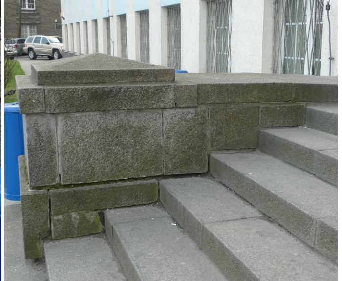
Fot. 30, 31. Balustrada schodów wejścia głównego z widocznymi śladami mikroflory i wypłukanymi spoinami – elew. pn.
