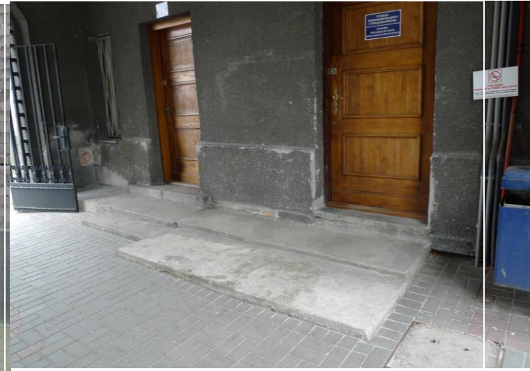
Fot. 34. Drzwi za przejazdem bramnym w elew. zach.. Oryginalne: granitowy stopień i cokół z lastrico porośnięte mikroflorą; cementowa opaska wokół budynku; ubytki w cegle i spoinach muru; pozostałości graffiti/wtórnego napisu informacyjnego; oryginalne listwy metalowe ościeży .
