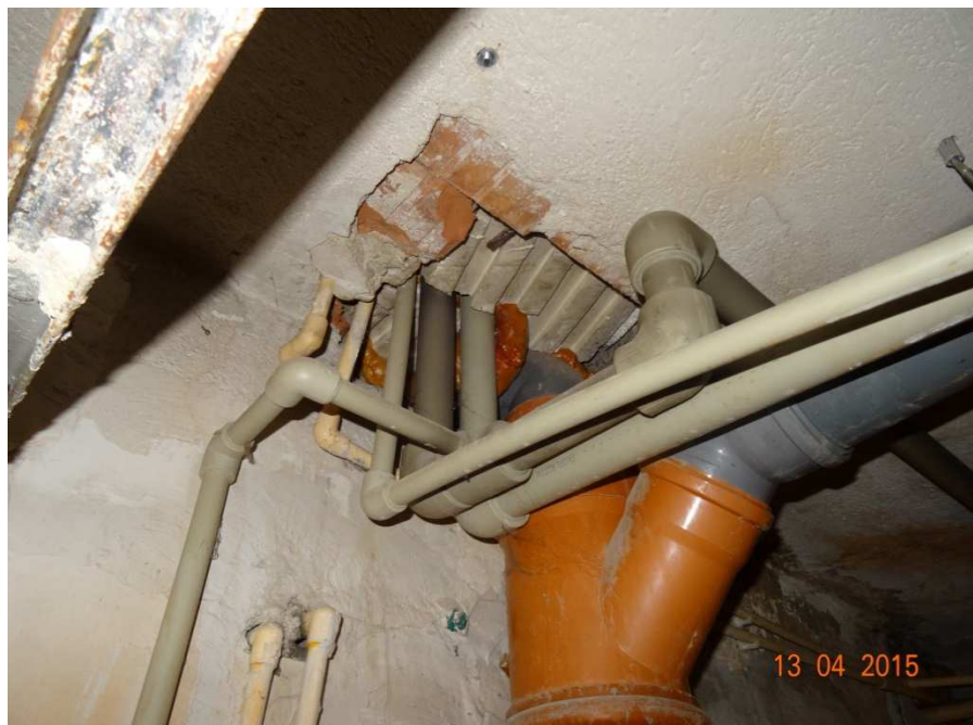
Zdj. nr 4 Zarejestrowany w wielu miejscach stan stropów w budynkach (łóżkowym, diagnostycznym i łącznikach)
