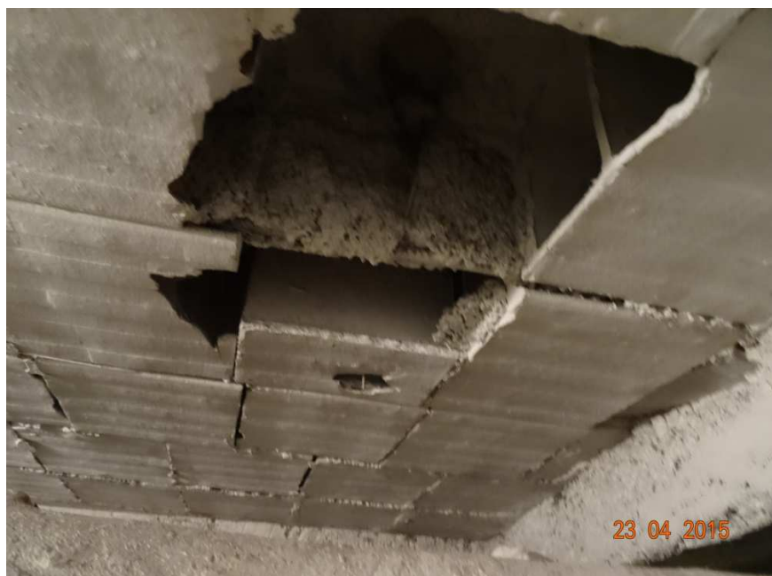
Zdj. nr 5 Zarejestrowany w wielu miejscach stan stropu gęsto-żebrowego w poziomie „-1” ROTUNDY. Pręty zbrojenia w wielu miejscach nie posiadają wymaganej zgodnie z wymaganiami EUROKODÓW nr EN 1992-1-2 EN 1996-1-2 otuliny. Wymagana otulina zbrojenia dla tych stropów o klasie REI120 od środka ciężkości „a” nie jest zachowana.
