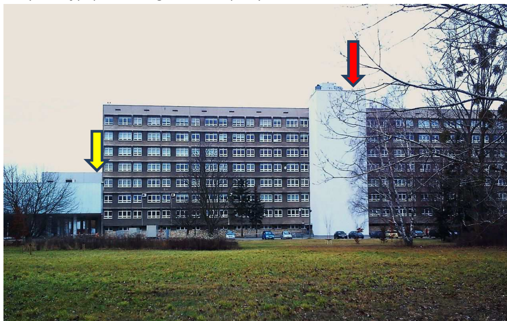
Zdj. nr 2 Widok na wschodnią elewację budynku od strony Alei Solidarności. Strzałką czerwoną zaznaczono dobudowaną klatkę schodową a żółtą blok operacyjny.
