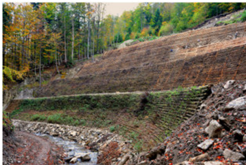
Kaszycę z pędami wierzby zabezpieczającą osuwisko pod drogą podcinaną przez ciek – pędy rozpoczęły wegetację jeszcze przed zakończeniem budowli. Nadleśnictwo Stuposiany. Źródło: Archiwum CKPS.
