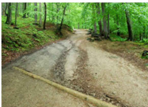
Wodospust z pojedynczego okrągłaka
