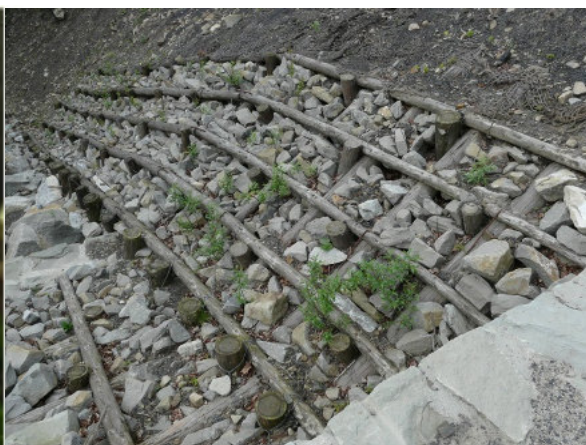
Kratownica ożywiona wierzbą poniżej brodu w Nadleśnictwie Bielsko na gruntach mineralnych szkieletowych podatnych. Źródło: Archiwum CKPŚ.
