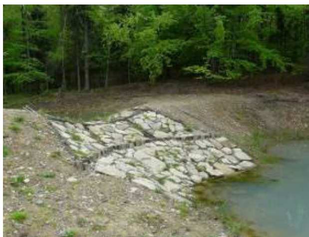
Przelewy górne w zbiornikach w N-ctwie Bielsko
