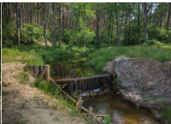
Widoczna erozja dna i skarp prowadząca do osłabienia konstrukcji. Źródło: Archiwum CKPŚ
