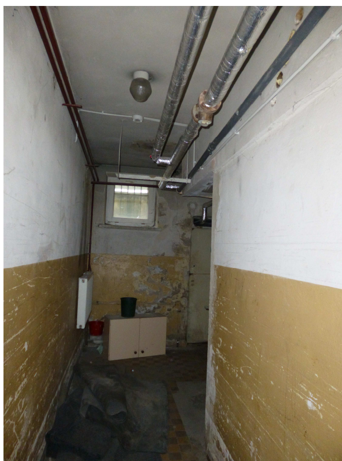
Fot. 3 – Zawilgocenia w piwnicy.
