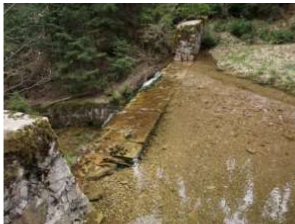
Rumosz różnych frakcji zalegający w czaszy różnych zapór – Nadleśnictwo Łądek Zdrój. Źródło: Archiwum CKPŚ.
