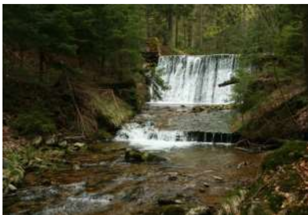
Całkowicie wypełniona zaporą na cieku z potencjałem siedliskowym dla ryb – Nadleśnictwo Łądek Zdrój. Źródło: Archiwum CKPŚ.
