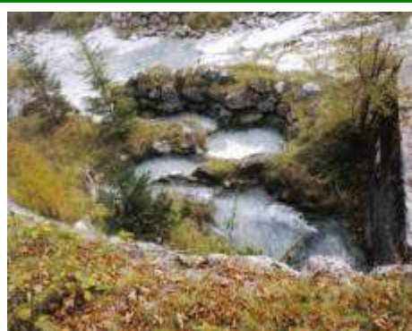
Przeplawka z połączonych akwenów (Żbikowski i Żelazo 1993, fot M. Jelonek 2008): 1 – zaporą/jaz 2 - akweny 3 - połączenia
