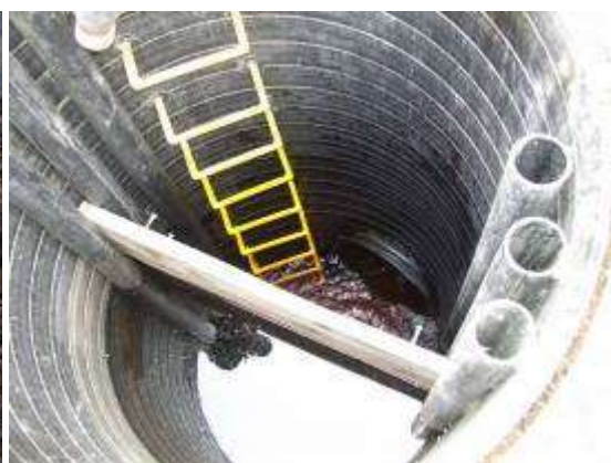
Studnia piętrząco-spustowa w trakcie budowy, widoczne kłamry zejściowe (fot. N-ctwo Lwówek Śląski i Szklarska Poręba)
