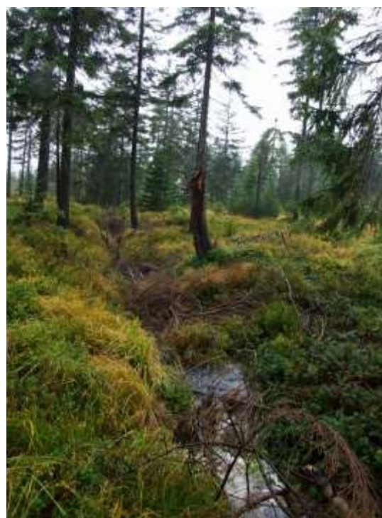
Sukcesywnie zasypany rumoszem drzewnym i zarastający rów odwadniający – N-ctwo Szklarska Poręba Fot. R.Bartosz
