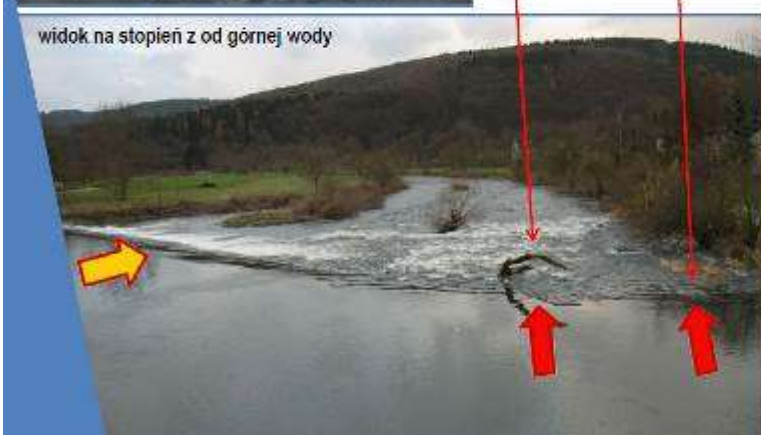
Bystrze dwuspadowe na stopniu poniżej mostu (Jelonek 2008)
