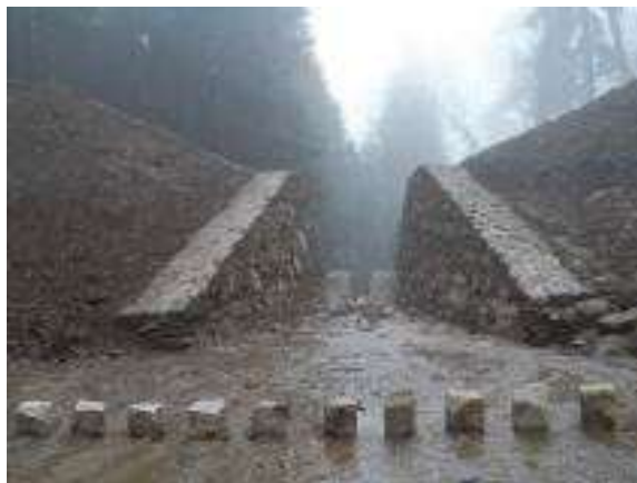
Suchy zbiornik w I-ctwie Jawornica z przelewem szczelinowym (przepławką) (fot. N-ctwo Międzylesie)
