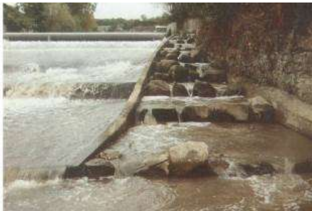
Przeławka kaskadowa przy budowli hydrotechnicznej. (Jelonek 2008)
