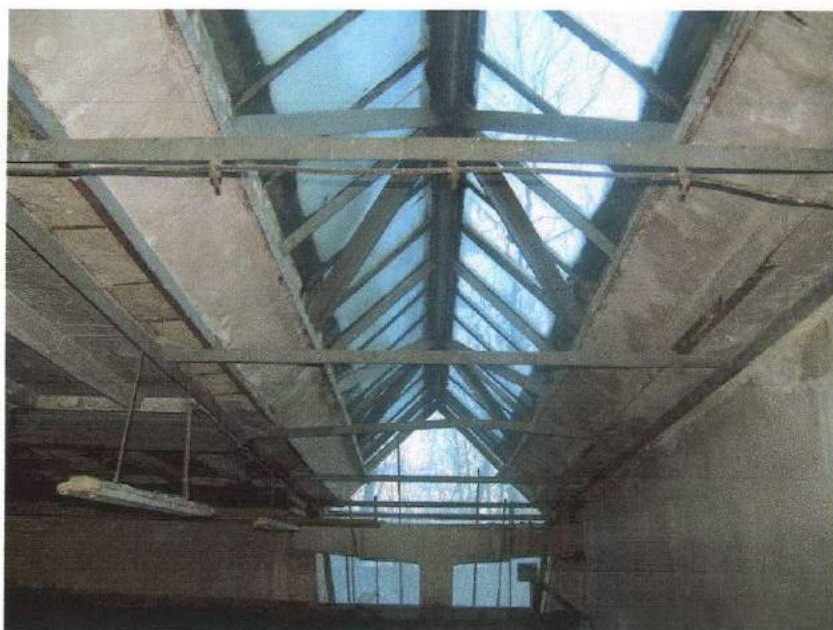
Fot. 8. Widok od spodu na rygiel ramy poprzecznej. Widoczne są opisywane wcześniej podwójny pas dolny, o przekroju zespolonym stalowo-żelbetowym, ze ściągami z kątowników oraz skratowanie dwupłaszczyznowe z kątowników. Jak w większości miejsc w budynku widoczne są tutaj również odkryte zbrojenie poprzeczne pasa dolnego, korozja elementów stalowych oraz zacieki powstałe przez nieszczelność pokrycia dachowego.
