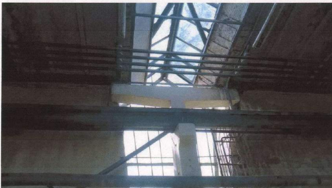
Fot. 5. Widok na górną część słupa skrajnego. Widoczny jest dolny, krótki wspornik, na którym opiera się belka podsuwnicowa, a powyżej dwustronny wspornik, na którym spoczywa rygiel ramy poprzecznej konstrukcji budynku. Na zdjęciu widać odkryte zbrojenie poprzeczne pasa dolnego rygla ramy. Jest to spowodowane nieszczelnością pokrycia dachowego/świetlika i co za tym idzie ingerencją czynników atmosferycznych.
