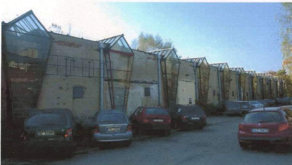
Fot. 1. Elewacja północna. Widoczne miejscowe uszkodzenia ściany osłonowej.
