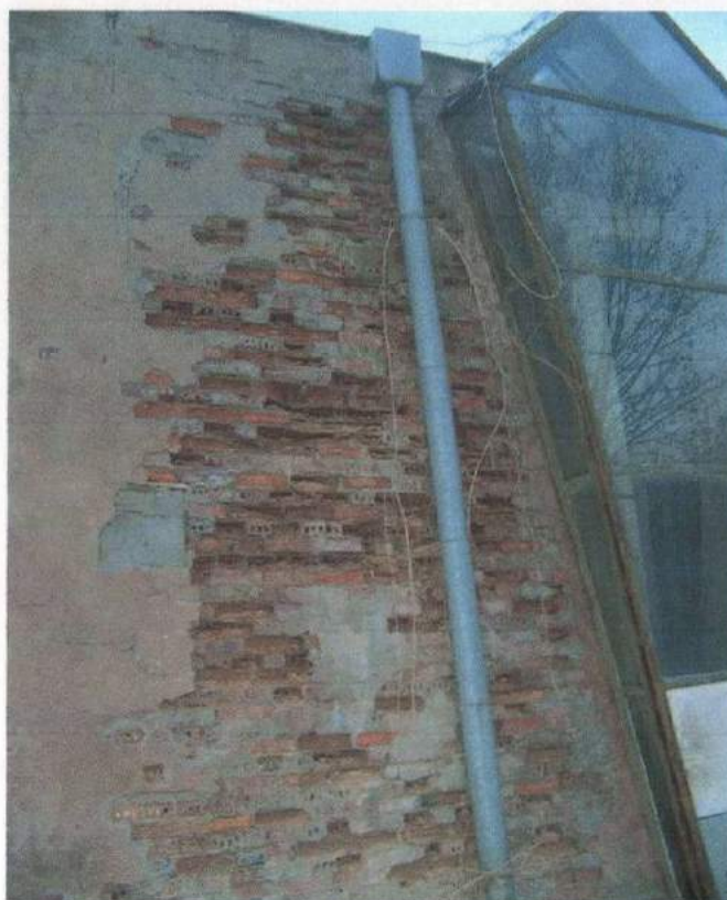
Fot. 3. Fragment elewacji południowej. Na zdjęciu widoczne znaczne ubytki materiału ściany. Lokalizacja ubytków przy rurze spustowej nie jest przypadkowa. Wyraźnie wskazuje to na nieszczelność rury odprowadzającej wodę z dachu.
