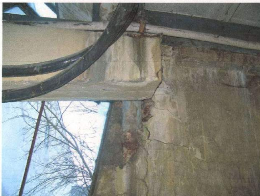
Fot. 9. Fragment wspornika pod oparcie rygla ramy poprzecznej. Widoczne zacieki i powierzchniowa korozja betonu. W tle nie mniej zdegradowana ściana zewnętrzna osłonowa z wpuszczoną rurą spustową. Wszystkie uszkodzenia elementów spowodowane czynnikami atmosferycznymi pośrednio przez nieszczelności
