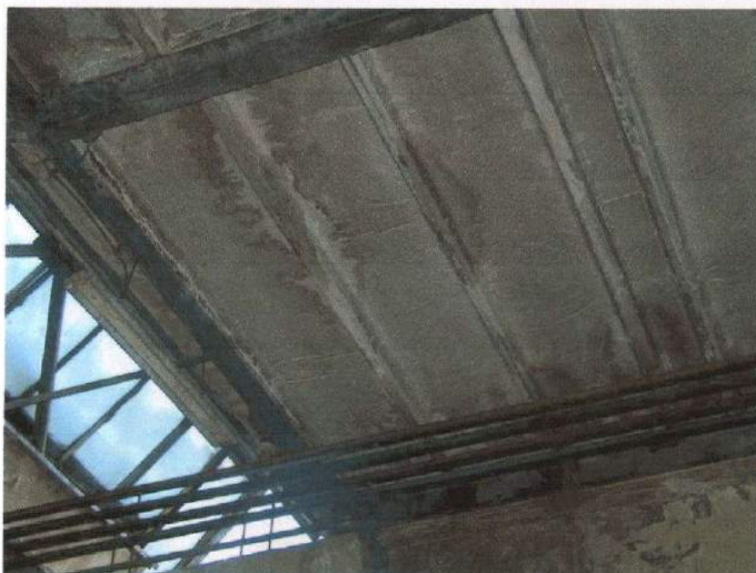
Fot. 7. Widok na spód pokrycia dachowego z płyt korytkowych. Charakterystyczne zacieki i wykwyty solne na spodzie płyt, wskazujące na nieszczelność pokrycia. Widoczne praktycznie w każdej części obiektu, powodują korozję betonu i stali konstrukcyjnej.
