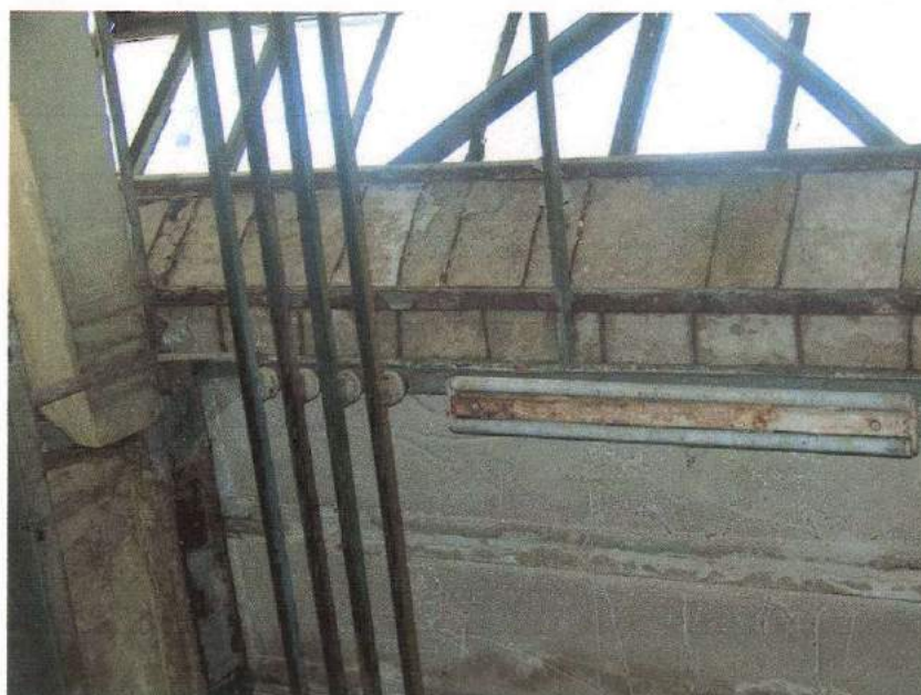
Fot. 6. Widok na fragment pasa dolnego rygla ramy poprzecznej. Dobrze widoczne odkryte zbrojenie poprzeczne pasa dolnego korozja stali oraz zacieki powstałe poprzez nieszczelności pokrycia dachowego i dostającą się wodę z opadów atmosferycznych do wnętrza obiektu. Z uwagi na brak odpowiedniej izolacji termicznej następowało cykliczne zamarzanie wody i odspajanie otuliny zbrojenia.
