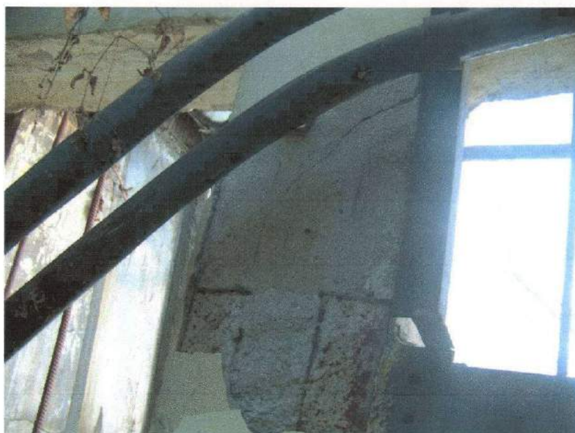
Fot. 10. Górna część słupa skrajnego w południowo - wschodnim narożniku. Uszkodzenie słupa – widoczna rysa ukośna, poprzez działanie sił poziomych od suwnicy, przekazywanych ryglem widocznym u dołu zdjęcia. Należy naprawić powyższy słup, a w przypadku wykrycia podobnej sytuacji w innym miejscu skonsultować się z projektantem celem uzgodnienia sposobu naprawy.
