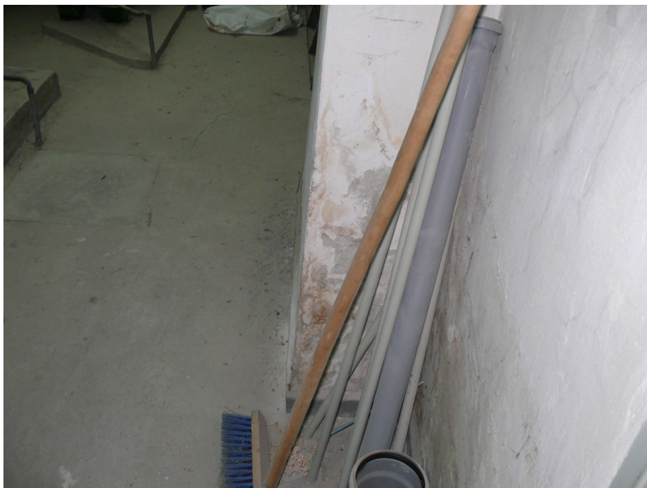
Zawilgocenie ścian piwnic
