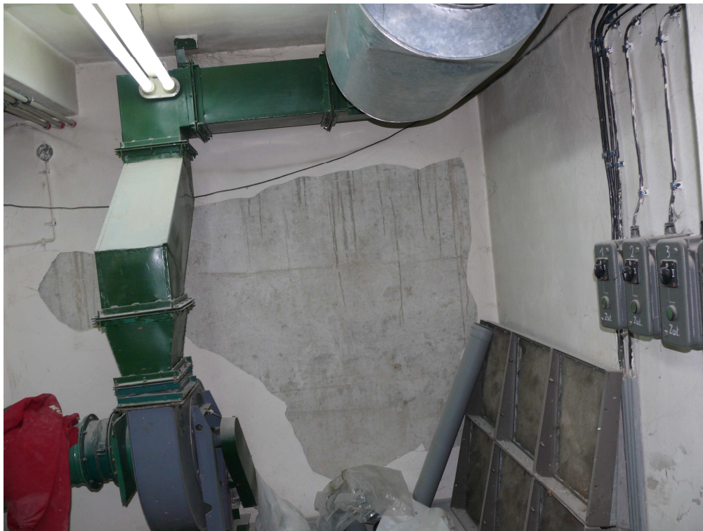
Ubytki tynków /piwnica/
