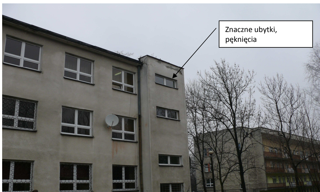
Uszkodzenia elewacji
