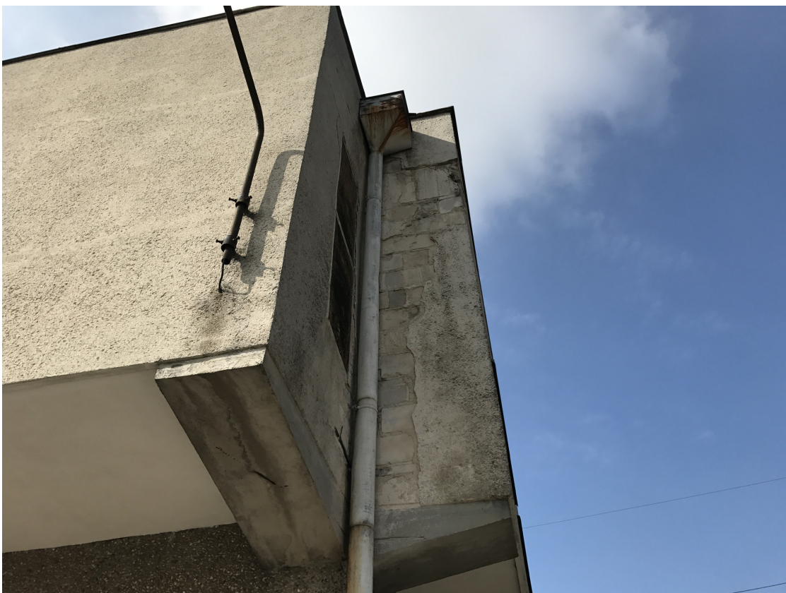
Zdjęcie nr 11 – uszkodzenia tynku spowodowane nieszczelnością układu odprowadzającego wody opadowe
