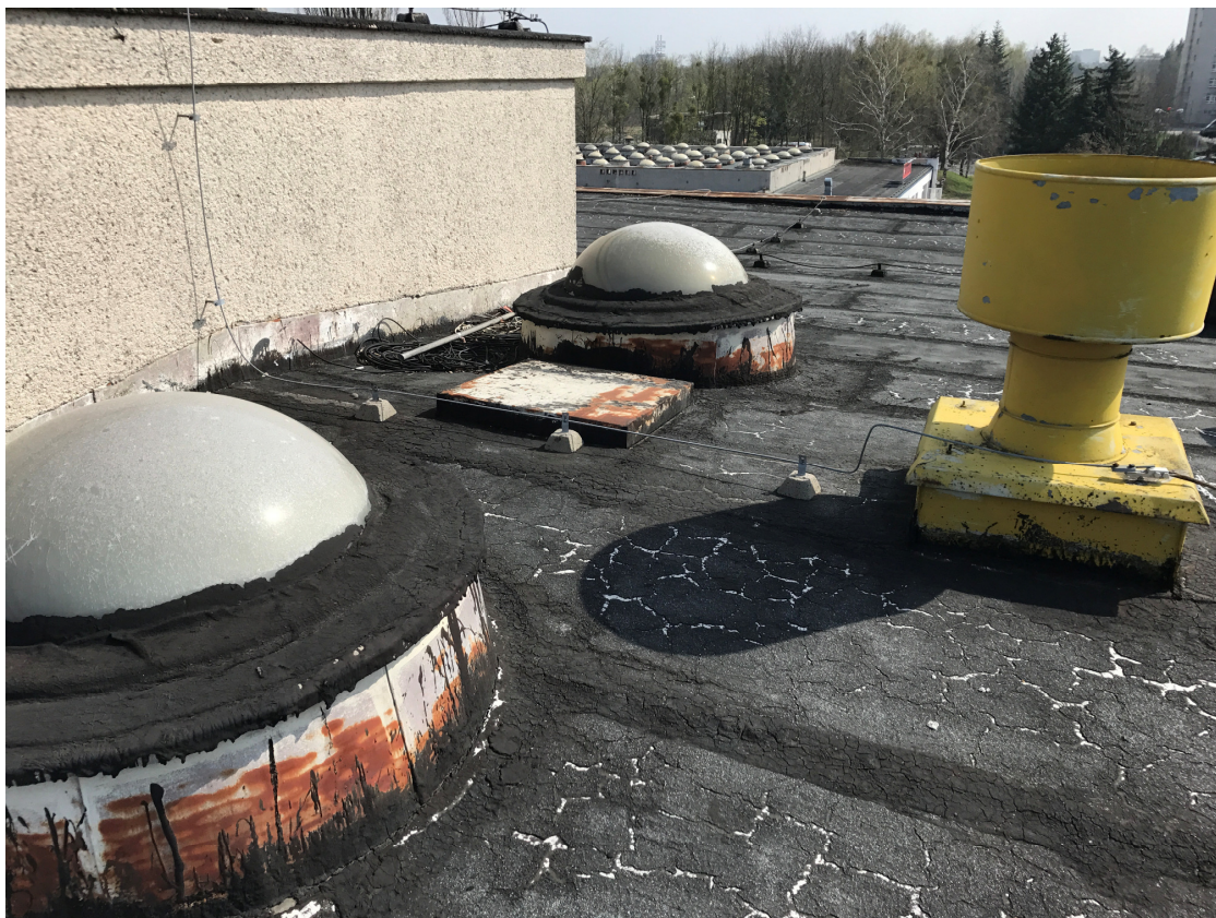
Zdjęcie nr 8 – jeden z siedmiu wylazów na dach z przestrzeni stropodachu
