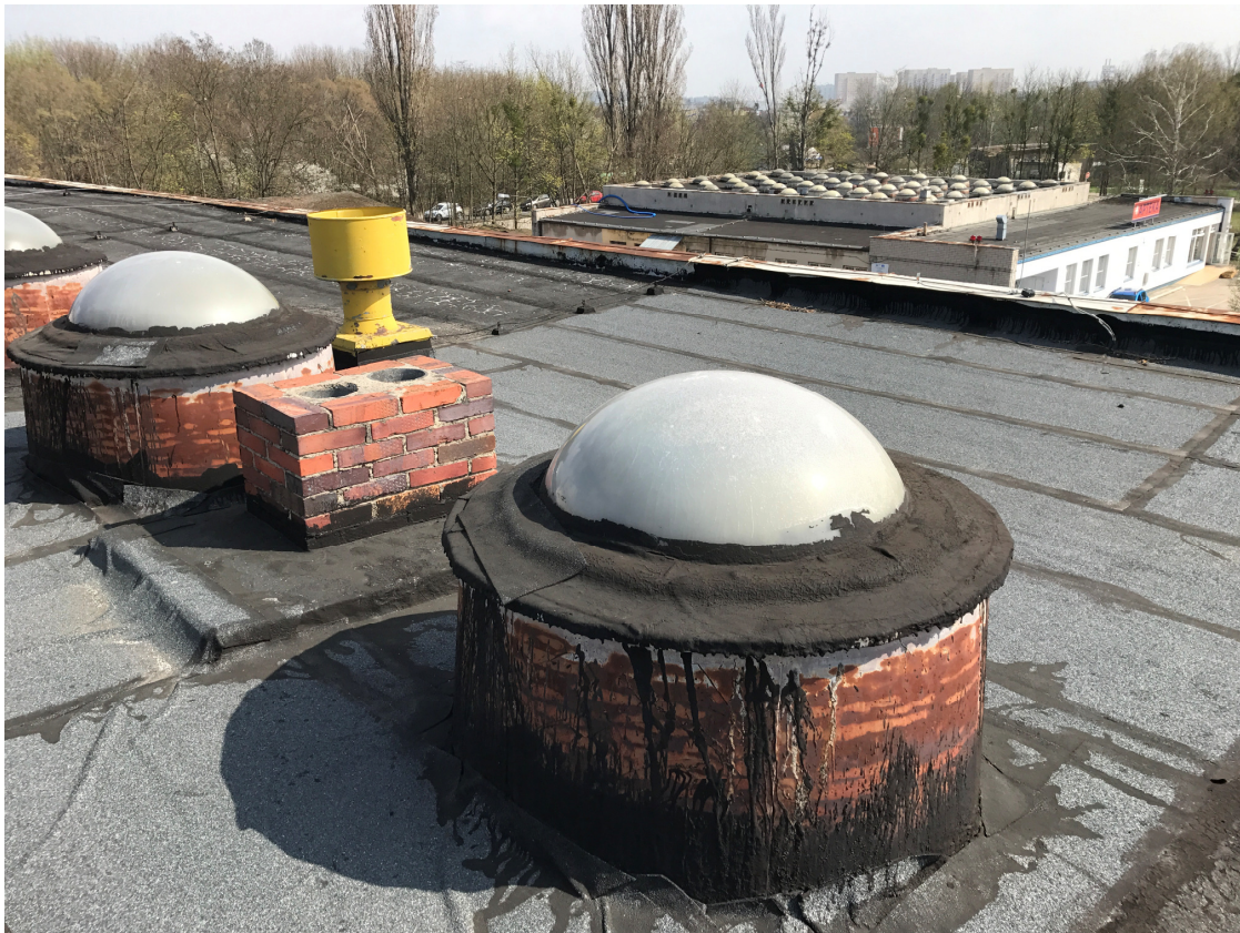
Zdjęcie nr 4 – widok świetlika kopułkowego na dachu budynku
