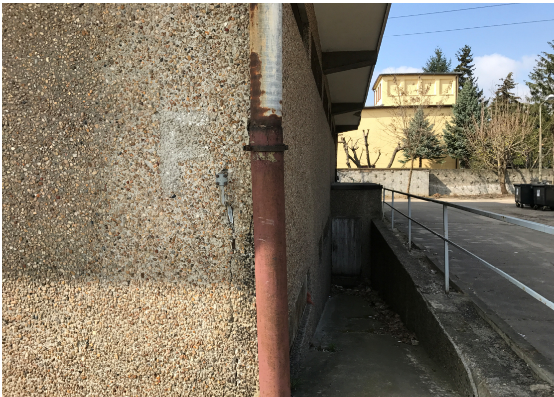
Zdjęcie nr 10 – widok rury spustowej na narożniku wschodnim (rura stalowa)
