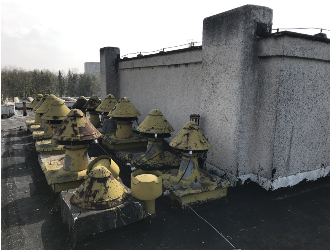
Zdjęcie nr 7 – widok kilku wentylatorów dachowych z pośród 32 sztuk znajdujących się na dachu budynku
