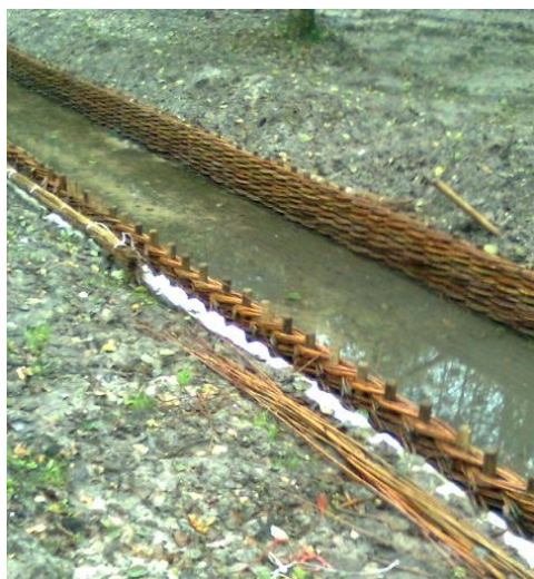
Zdjęcie nr 1 – przykład umocnienie płotkiem faszynowym
