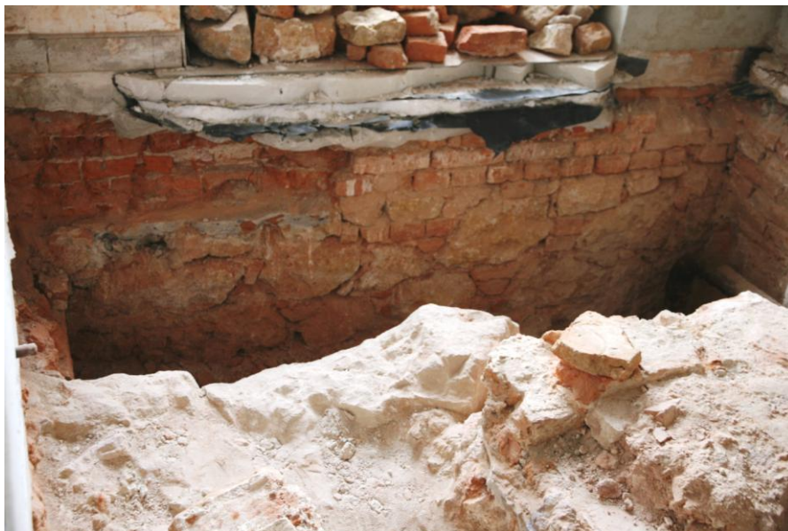
Fot.5. Widoczny fragment ściany pod oknem, po lewej stronie drzwi wejściowych (przed przebudową). Widoczne przemieszanie wątków: ceglany i z kamienia łamanego. W tym miejscu planuje się wykonanie częściowej rekonstrukcji wątku z wapiennego kamienia łamanego.
