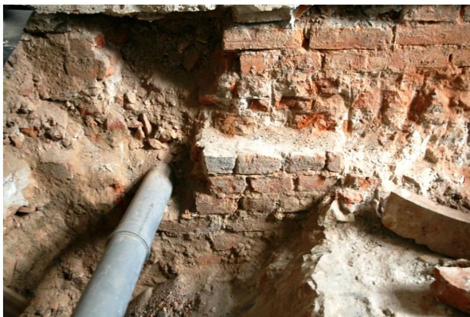
Fot.6. Widoczne przemieszanie wątków na jednej ze ścian.
