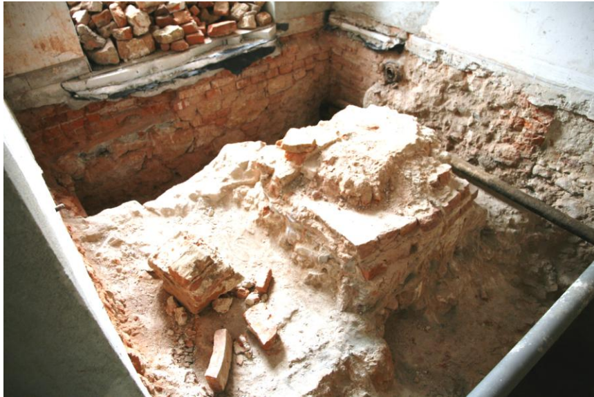
Fot.2. Fragment reliktów: widok od strony okna w pomieszczeniu, w dolnej części fotografii widoczny fragment okładziny zewnętrznej pałacu ( Santi Gucci ?) z wapienia, starannie obrobiony. Po lewej stronie pozostałości zejścia do piwnicy ( podziemi), powyżej : pozostałość po instalacjach z okresu austriackiego (?).
