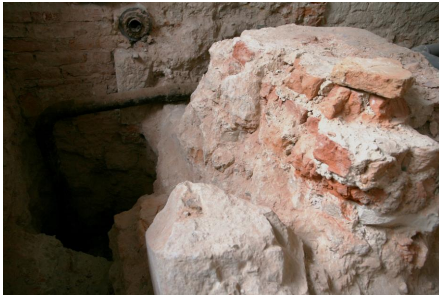
Fot.2. Fragment reliktów: widok od strony okna w pomieszczeniu, w dolnej części fotografii widoczny fragment okładziny zewnętrznej pałacu ( Santi Gucci ?) z wapienia, starannie obrobiony. Po lewej stronie pozostałości zejścia do piwnicy ( podziemi), powyżej : pozostałość po instalacjach z okresu austriackiego (?).
