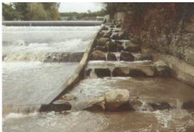
Przeławka kaskadowa przy budowlu hydrotechnicznej. (Jelonek 2008)
