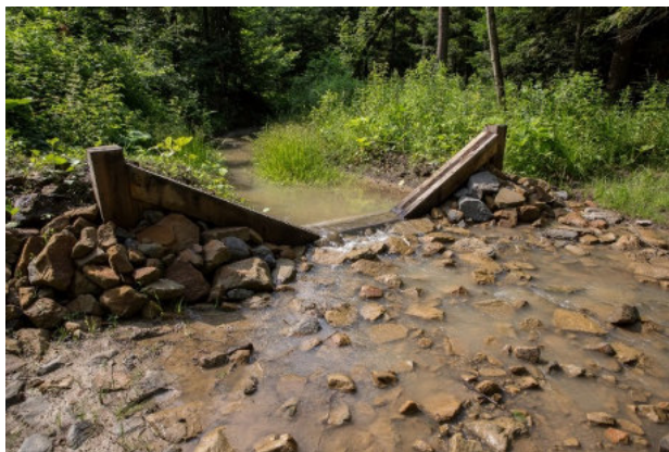
Próg powyżej brodu ukierunkowujący wodę na bród.
