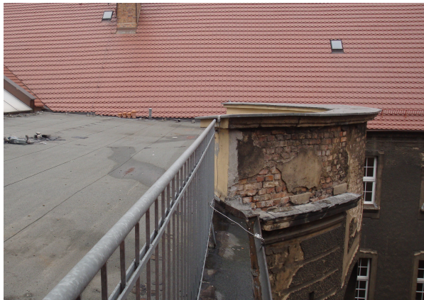
FOT.4 Widok ściany dziedzińca wewnętrznego – zniszczone tynki.
