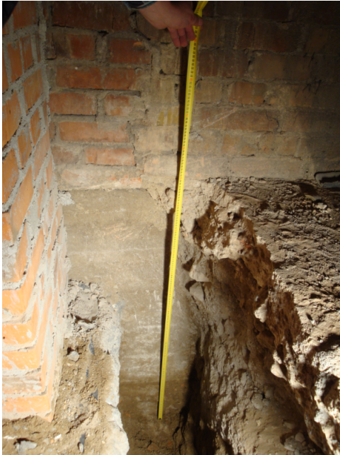
FOT. 1 i 2 Odkrywki fundamentów.
