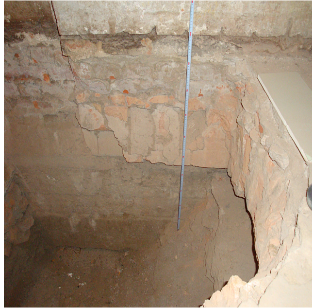
FOT. 1 i 2 Odkrywki fundamentów.
