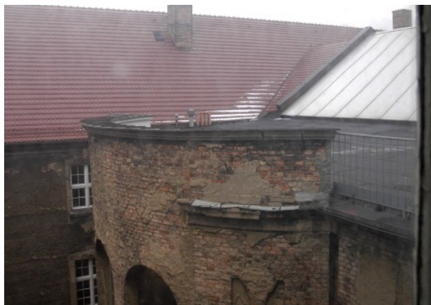
FOT.5 Widok ściany dziedzińca wewnętrznego – zniszczone tynki.
